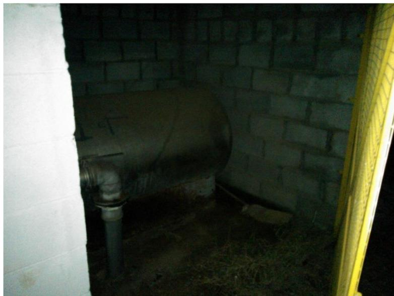
En su parte superior posee una boca de acceso circular de 50 cm de diámetro para realizar el cambio de carga filtrante y/o eventuales inspecciones de los colectores internos. La tapa del acceso se asegura con bulones de acero inoxidable y una junta de goma y posee conexión para un manómetro, que en este caso se encuentra sumamente deteriorado por lo que no se puede efectuar lecturas del mismo y, una válvula de retención que hace las veces de una válvula de aire.
