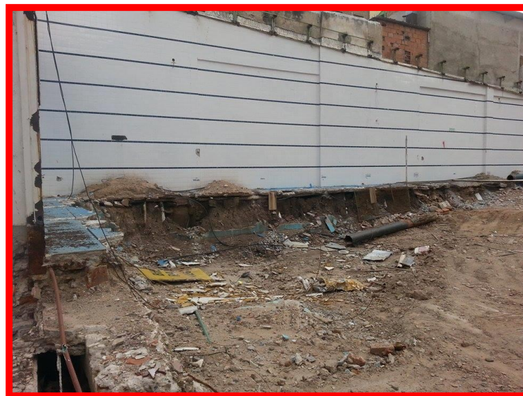
Figura 4.6.1.17- Estado final de pileta Bucor demolida
