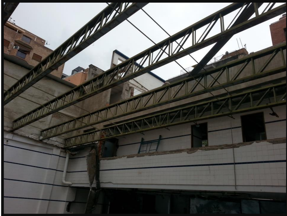
Figura 4.6.1.5 -Vigas reticuladas al descubierto del Complejo Bucor
