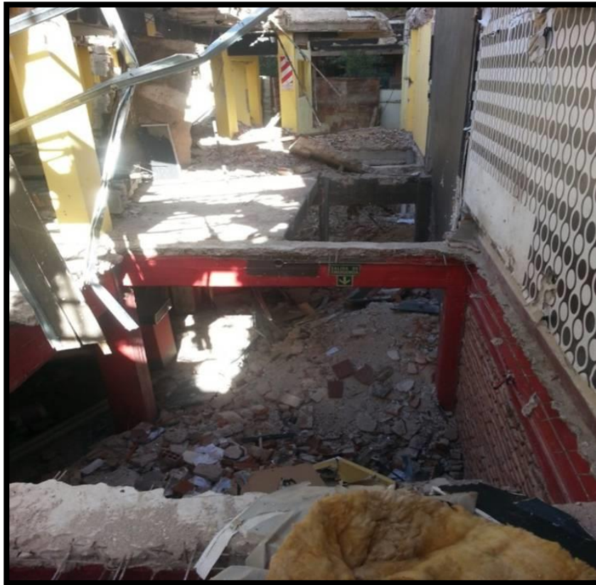
Figura 4.6.2.4- Demolición de losas. Subsuelo Boliche Hawai
