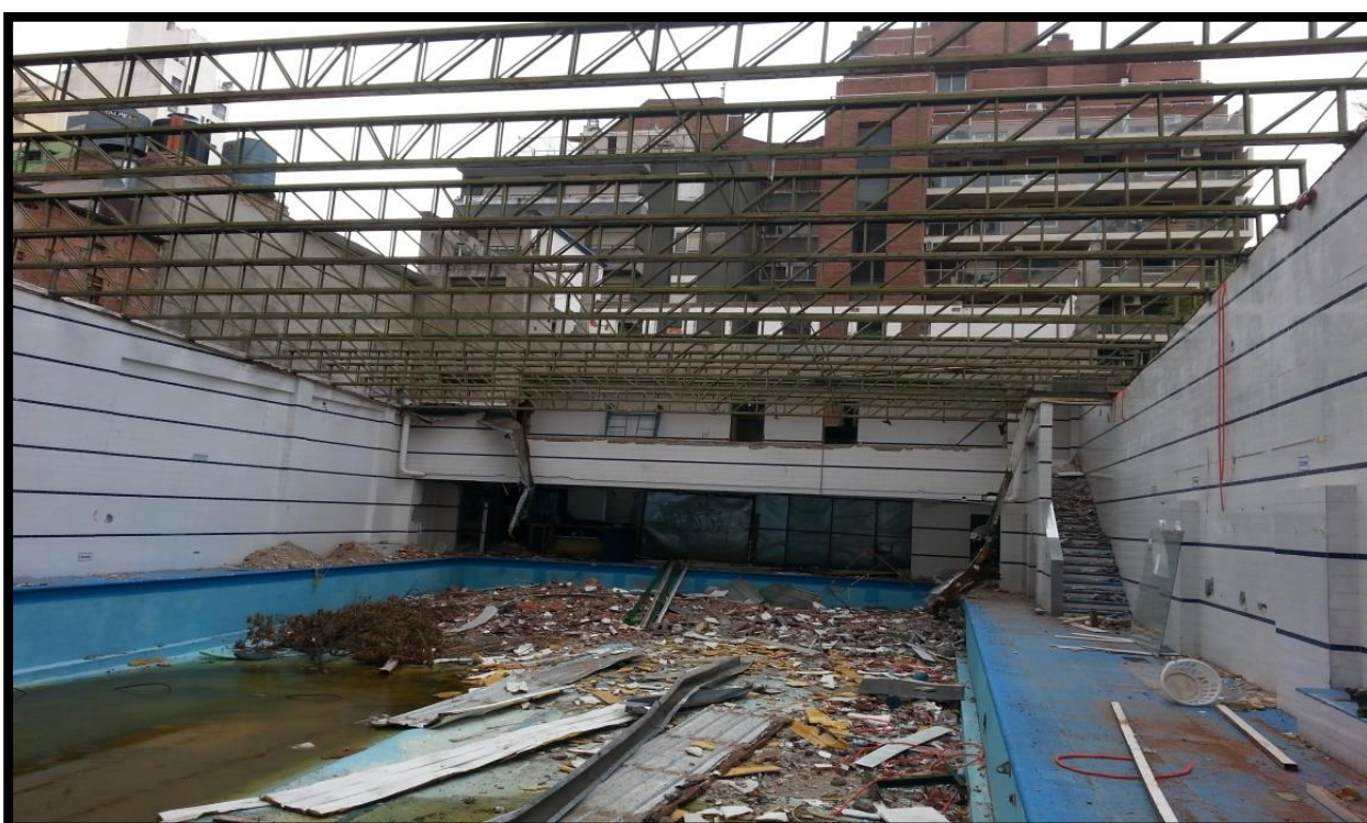
Figura 4.6.1.4 – Vigas reticuladas al descubierto del Complejo Bucor
