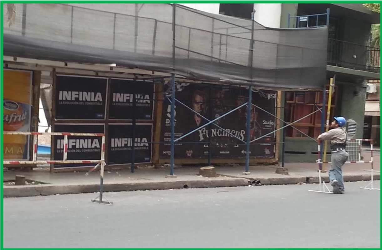
Figura 4.6.1.11 – Albañil advirtiendo a transeúntes de trabajos de demolición
