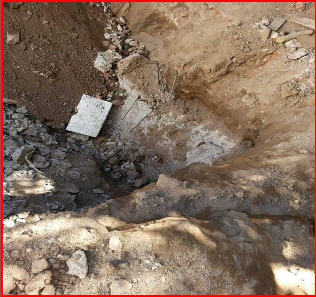
Figura 5.1.6 - Fundación original a demoler, no afecta a los vecinos.
