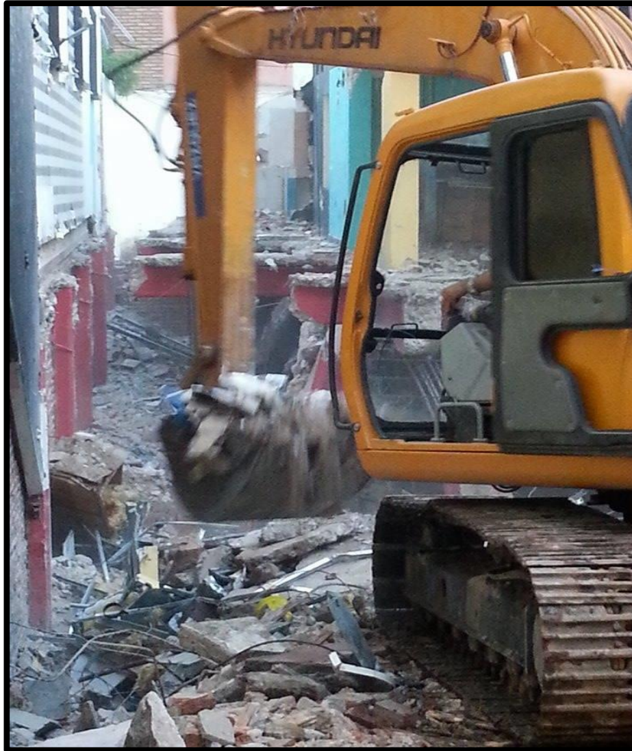
Figura 4.9 – Retroexcavadora demoliendo Vigas y Recogiendo escombros.
