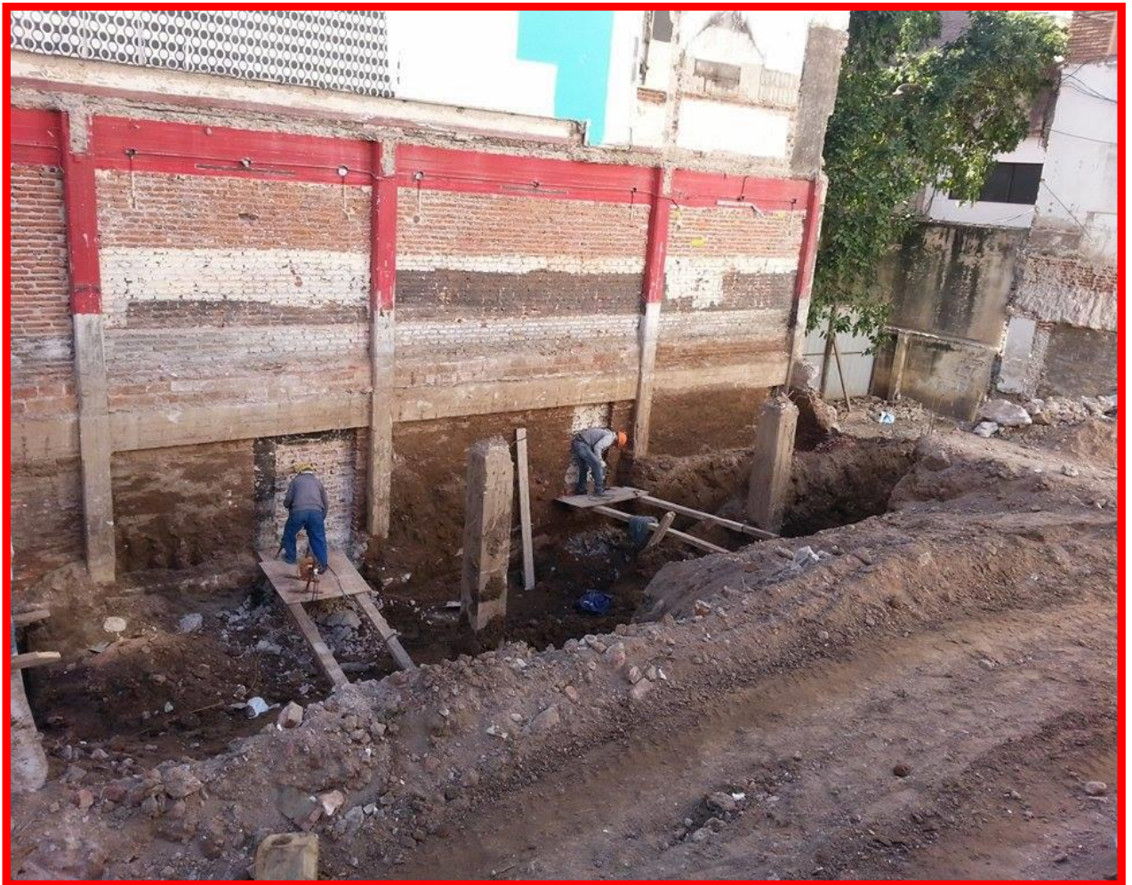
Figura 5.1.5- Excavación ya realizada por retroexcavadora e inicio de pilotes a mano.
