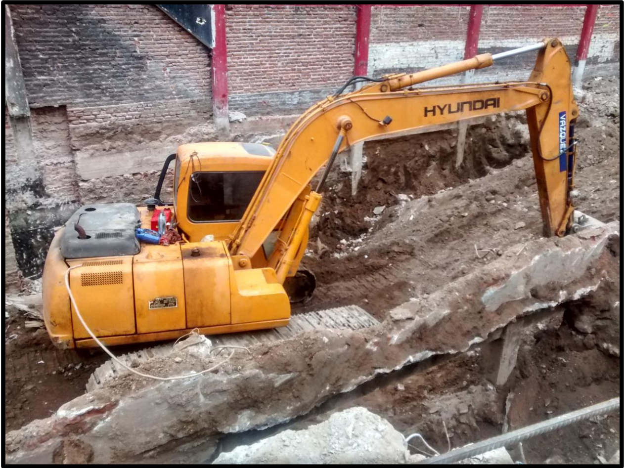
Figura 5.1.2 – Retroexcavadora Excavando tierra en Boliche Hawai
