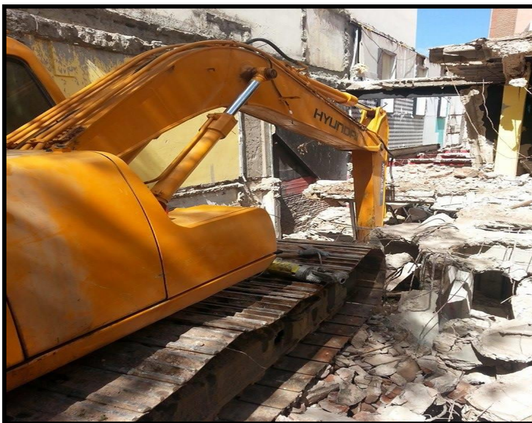
Figura 4.6 – Retroexcavadora introducida ya en boliche Hawaii
