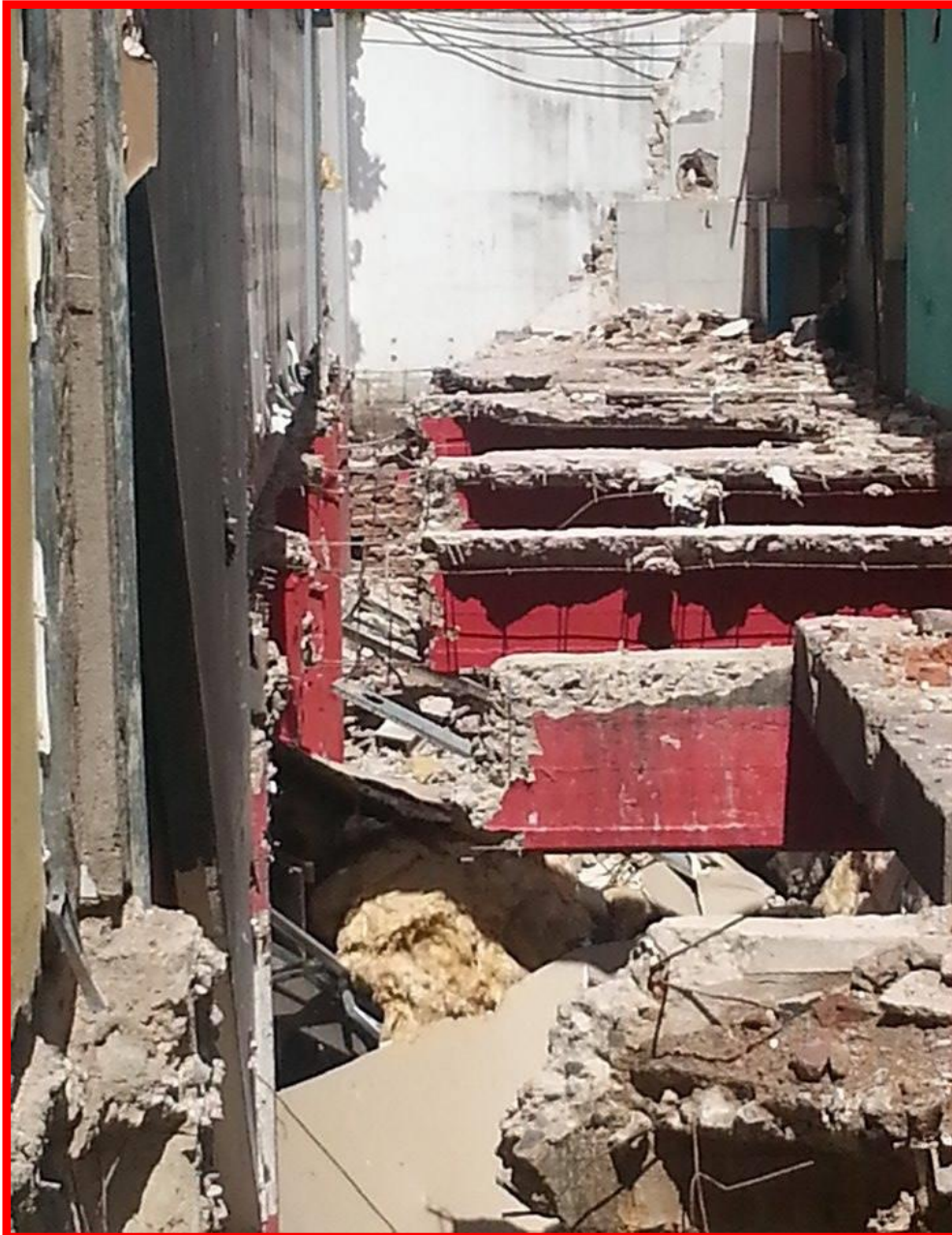
Figura 4.6.2.3 – Vigas de Boliche Hawái Desvinculadas del vecino
