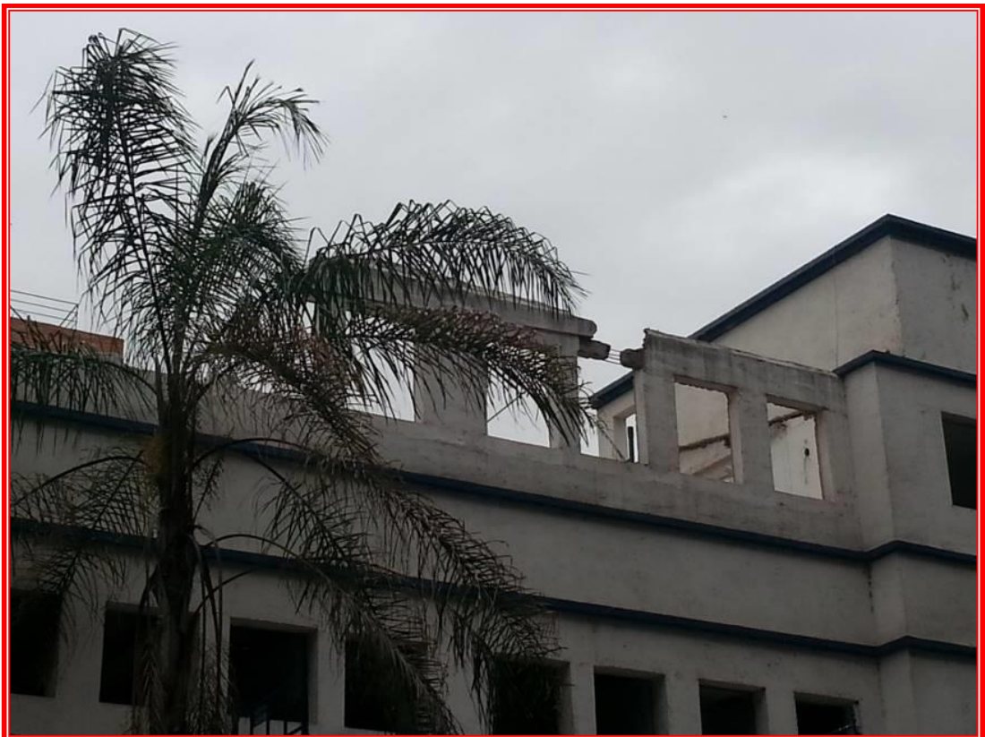
Figura 4.6.1.9- Viga superior de Fachada del Complejo Bucor
