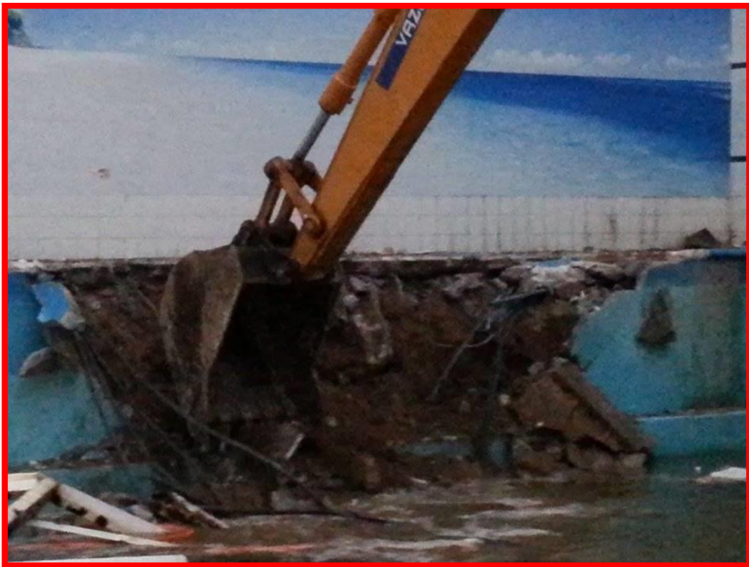
Figura 4.6.1.13 – Retroexcavadora demoliendo Borde de Pileta de Complejo Bucor
