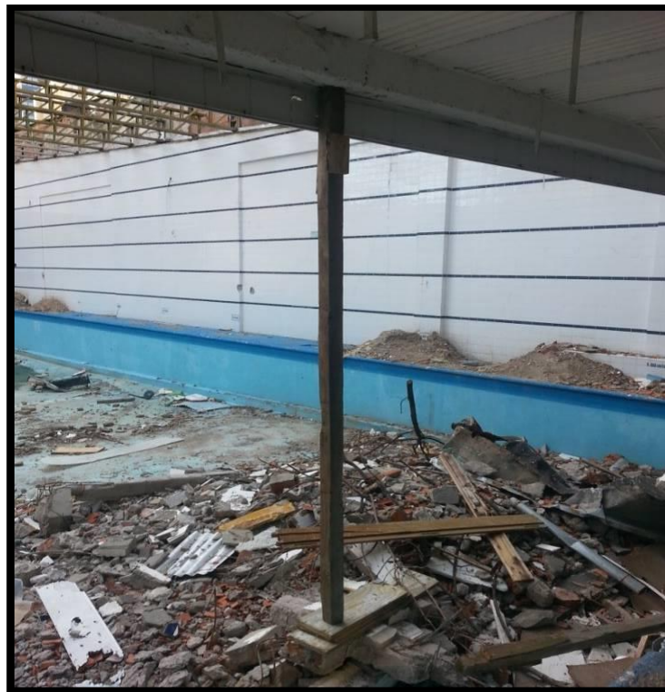
Figura 4.6.1.3 – Apuntalamiento de Vigas
