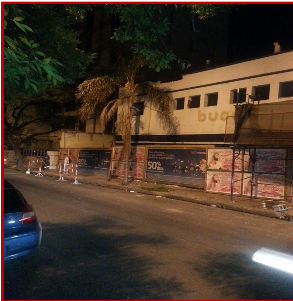
Figura 4.2.3.1 Fachada Bucor sobre calle Buenos Aires - Se observan vallados, andamios y medias sombras.
