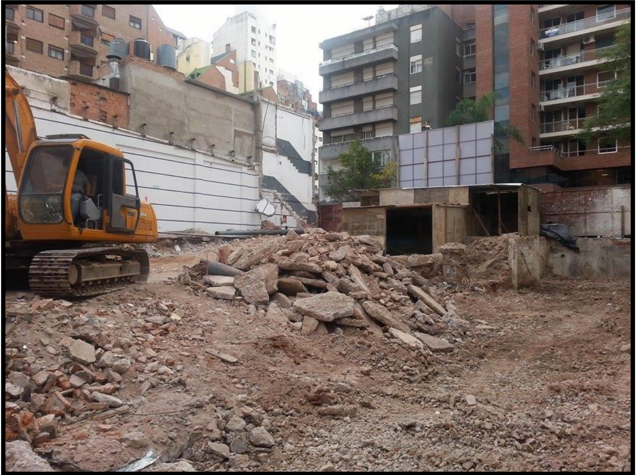
Figura 5.1.3 – Obrador. Oficina y Vestuarios empleados.
