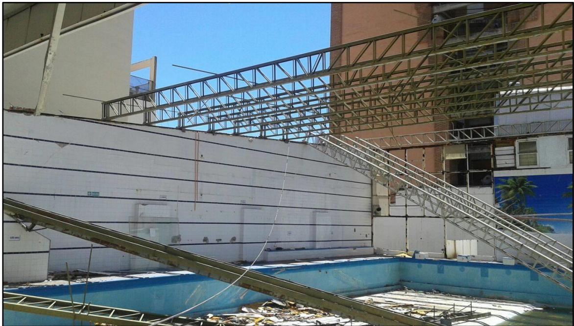
Figura 4.6.1.6- Vigas reticuladas apoyadas simplemente a la medianera
