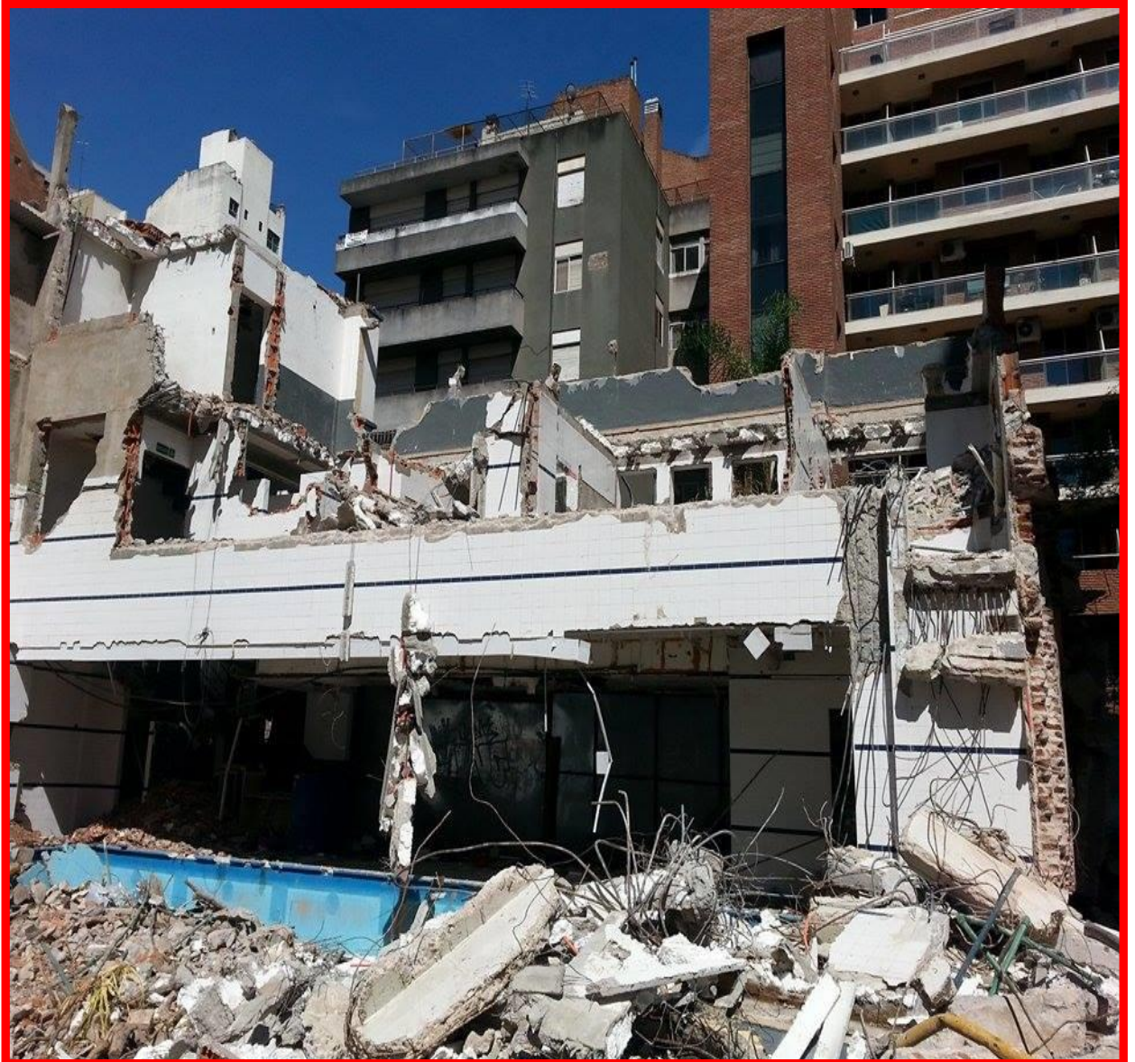
Figura 4.6.1.12 – Parte trasera recepción de Complejo Bucor
