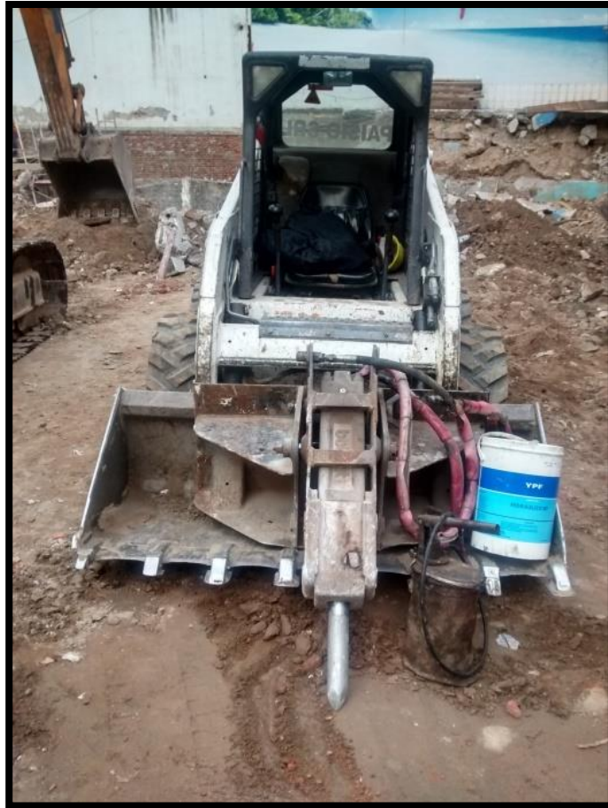
Figura 4.6.1.14- Bob Cat para demoler el piso de la Pileta de Bucor
