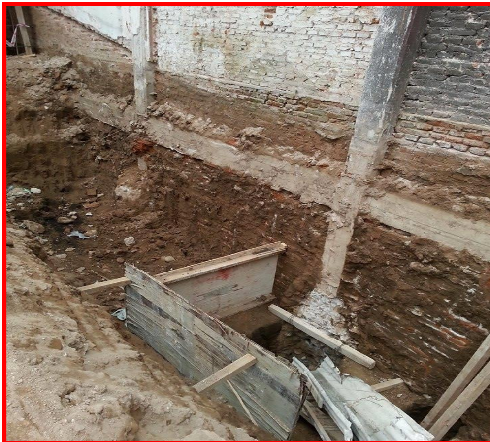
Figura 5.1.7 – Entibado para realización de pilote de 0,8m
