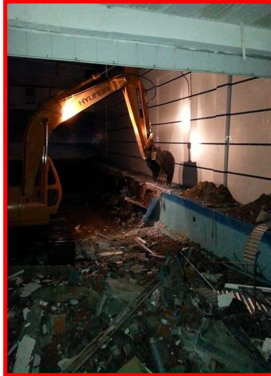
Figura 4.6.1.16- Retroexcavadora trabajando de noche
