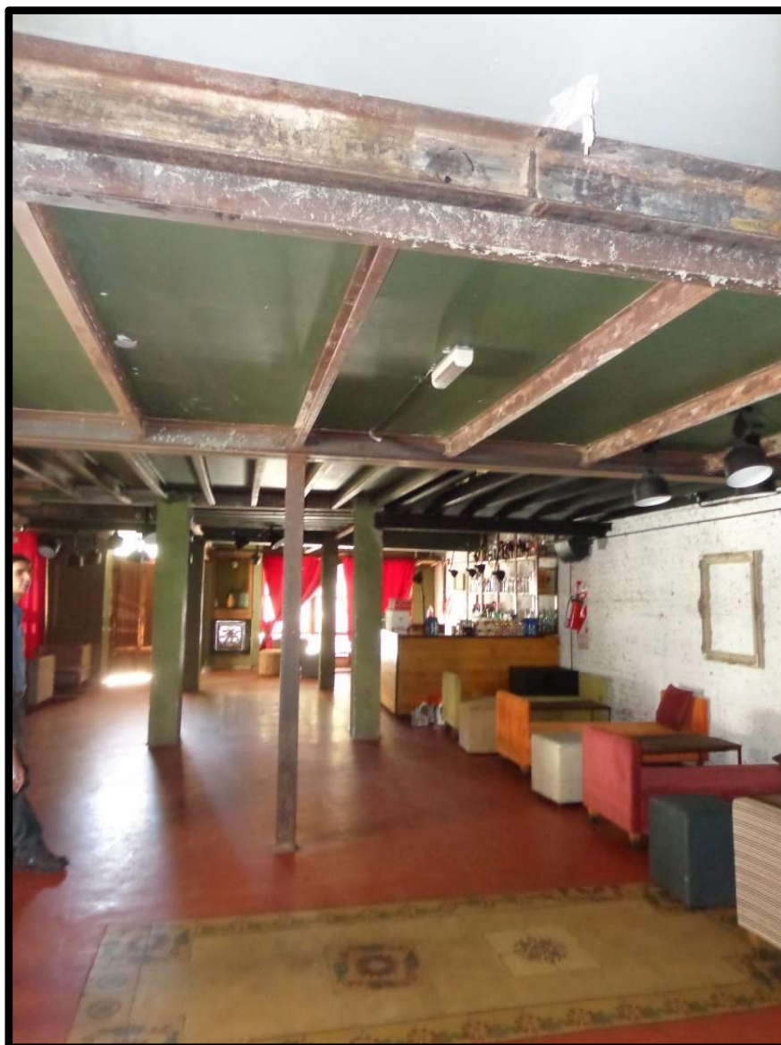
Figura 4.2.5 – Vigas Metálicas refuerzo de losas
