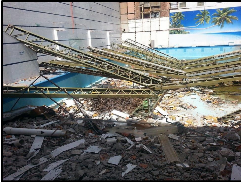
Figura 4.6.1.8 – Vigas cortadas a la mitad para poder sacarlas del predio
