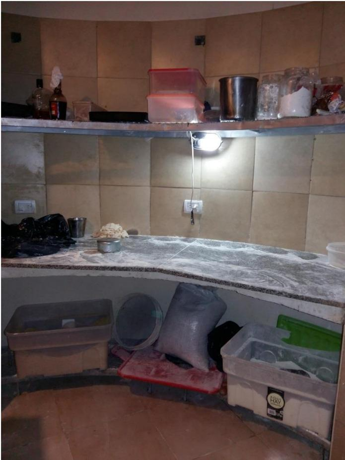
*Foto 3. Sector Panadería. Instalación eléctrica inadecuada (sin protección antiestallido/ cinta aisladora/ boca sin tapa ciega). Frascos y botella sin tapa correspondiente.*
