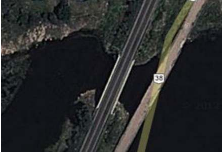
Figura 8. Vista aérea del Puente las Mojarras
