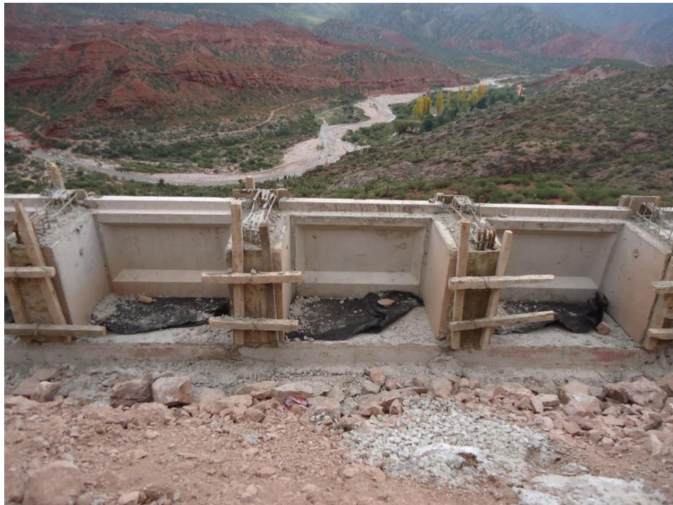
Figura 1.2. Vista interior de paneles tipo U prefabricados
