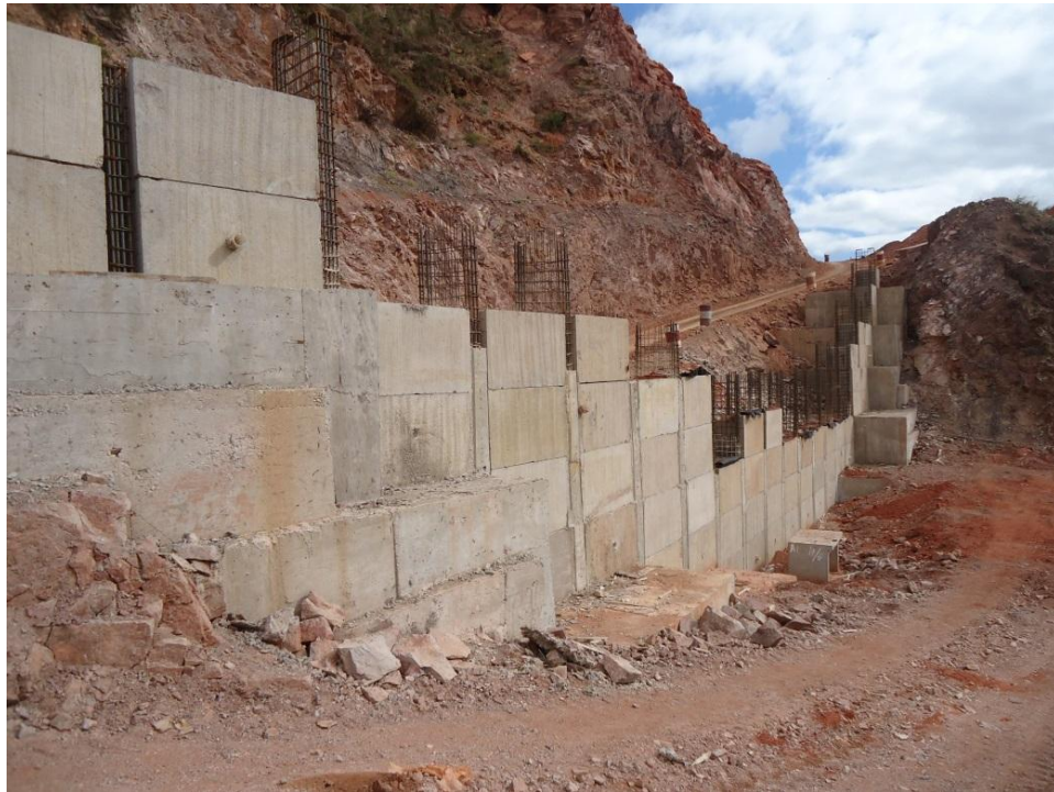
Figura 1.3. Desarrollo longitudinal de muros sin voladizo. Etapa de construcción
