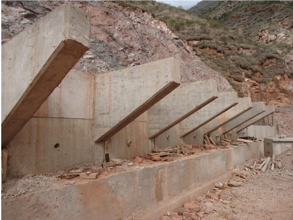
Figura 1.4. Pases para drenaje en paneles de arranque
