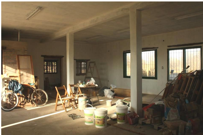
Sala principal, en proceso de pintado
