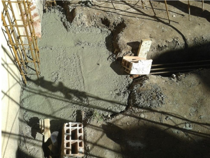
Fig. 35_ Tapado de zanjas de vigas riostras de fundación para hormigonado.
