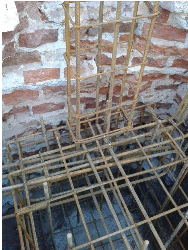
Fig. 39_ Replanteo y disposición de armadura de columna.
