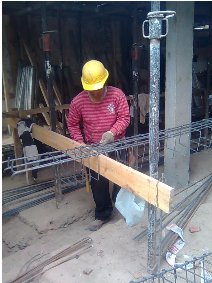
Fig. 40_Armado de columnas.
