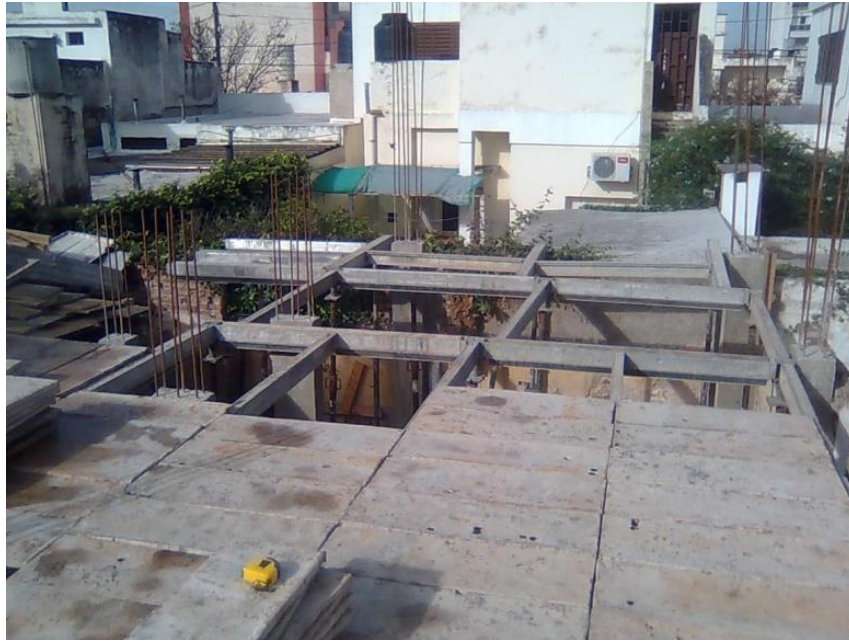
Fig. 52_Colocación de chapones sobre estructura de encofrado.
