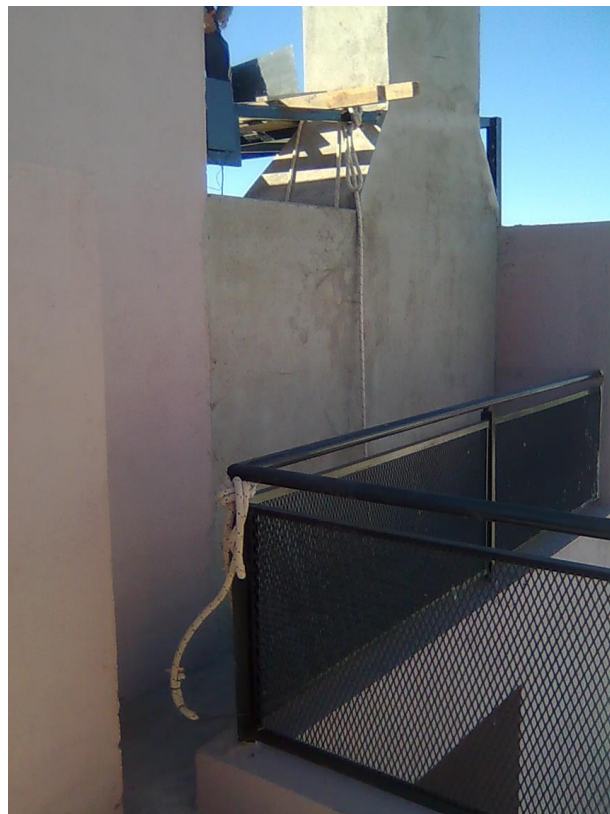
Fig. 15_Punto seguro de amarre del arnés de seguridad.
