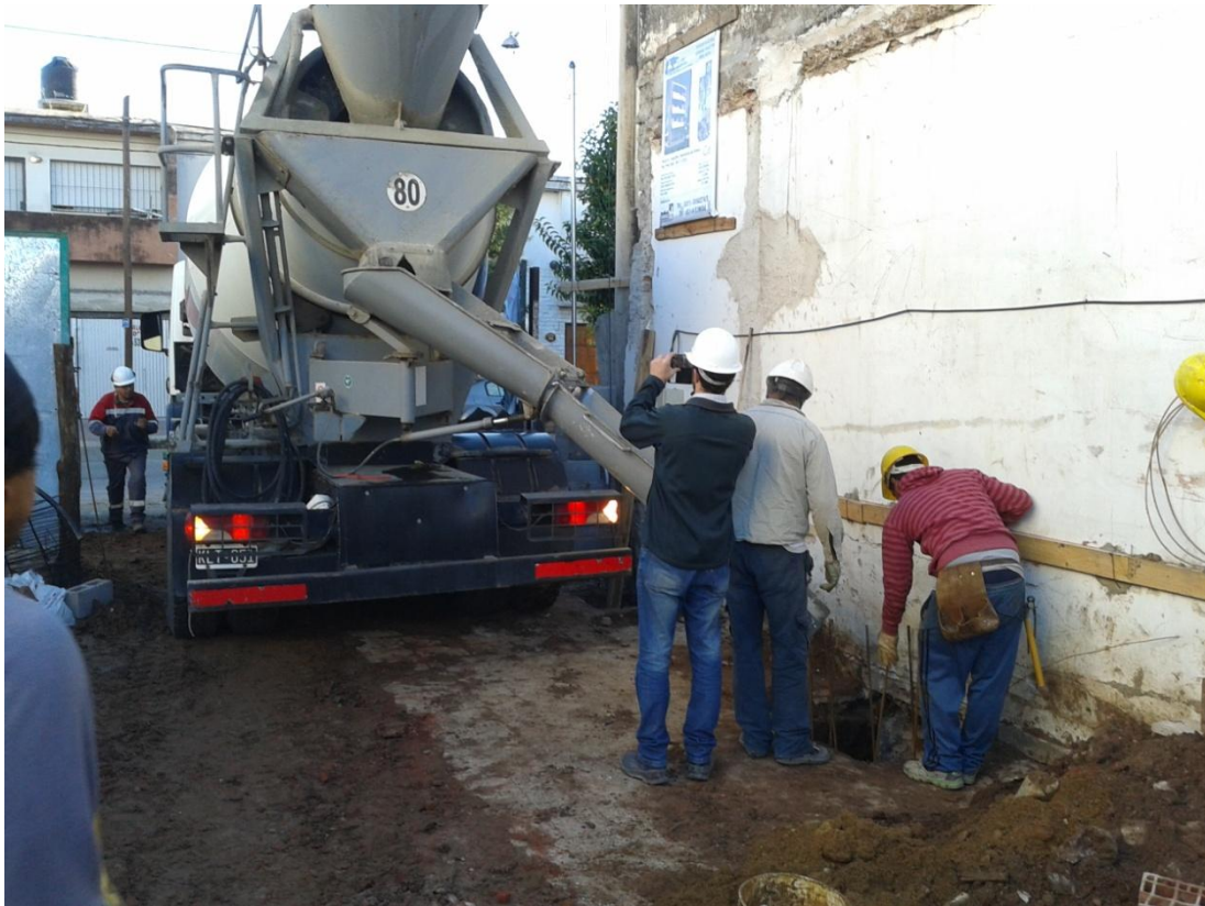
Fig. 30_Ingreso de camión moto-hormigonero al terreno.
