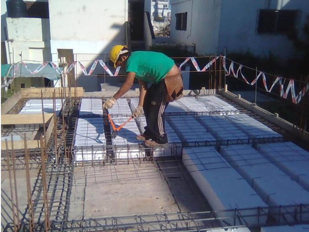
Fig. 63_Disposición y cortado de mallas metálicas.
