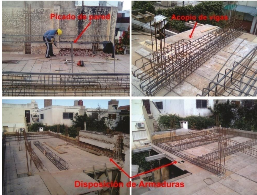
Fig. 59_Operaciones para la disposición de armaduras.
