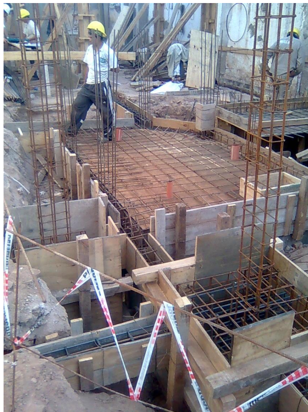
Fig. 29_Fundaciones expuestas listas para hormigonar.
