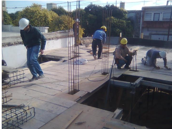
Fig. 56_Verificación de perpendicularidad de ejes principales.
