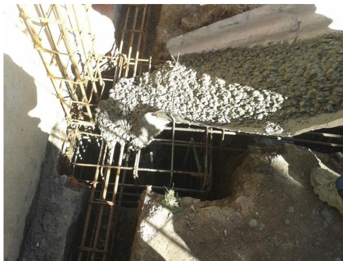
Fig. 32_Colado de hormigón en cabezal y viga riostra de fundación.
