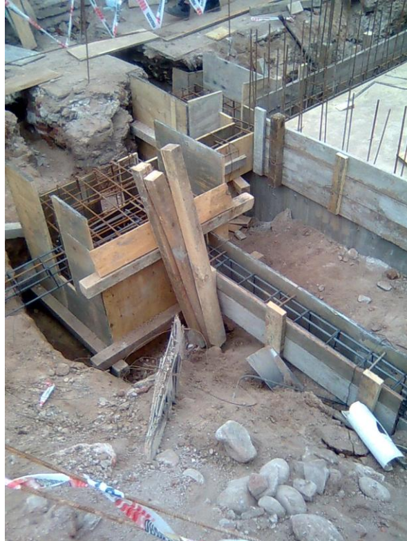
Fig. 28_Encofrado de cabezal expuesto y vigas riostras de fundación.
