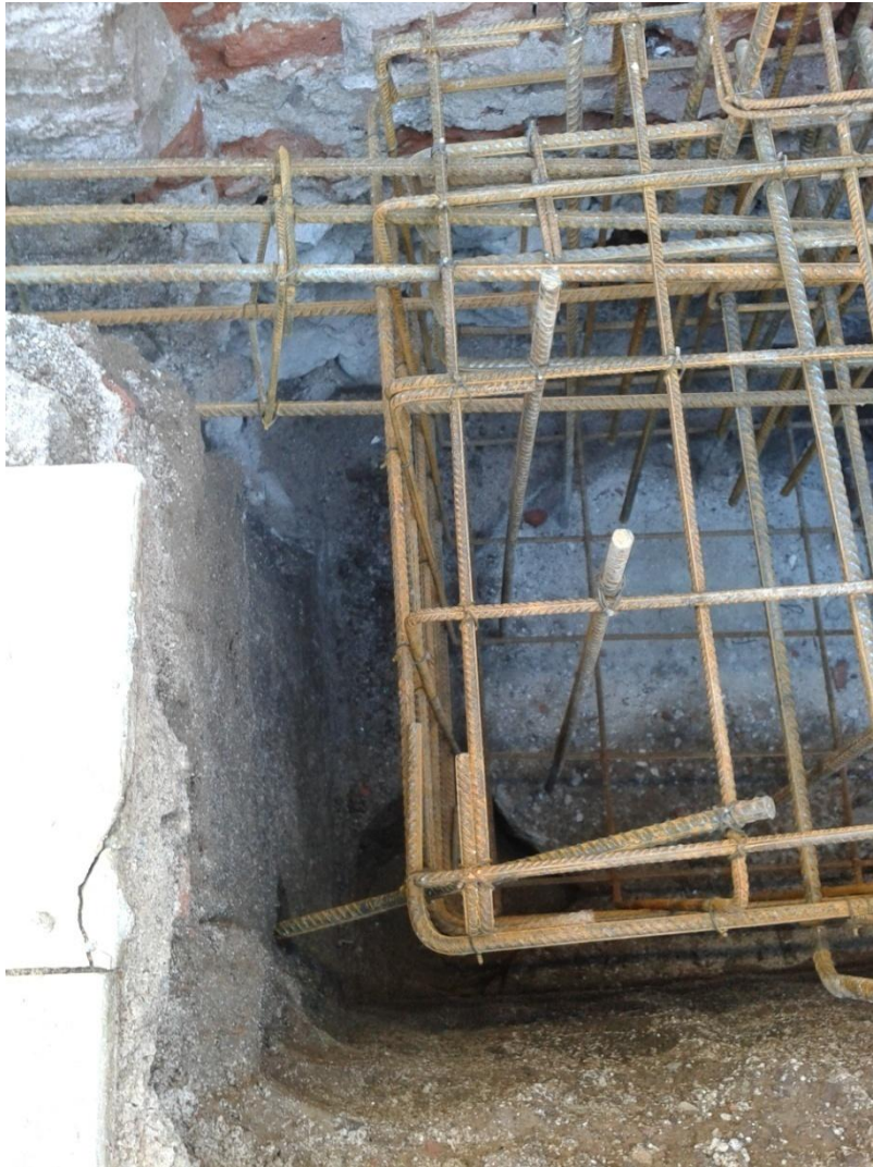
Fig. 34_Pozo de fundación con residuos.
