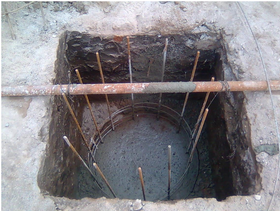
Fig. 25_Suspensor sosteniendo armadura de pozo de fundación.
