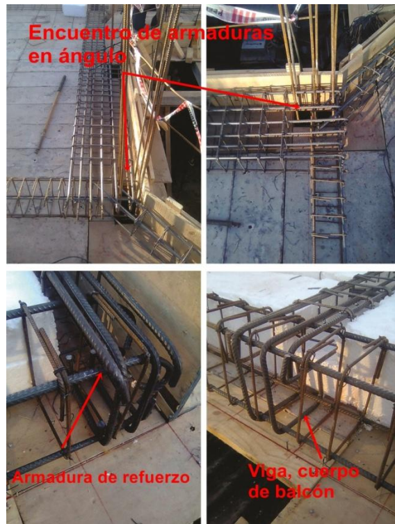
Fig. 60_Control de detalles en disposición de armaduras.
