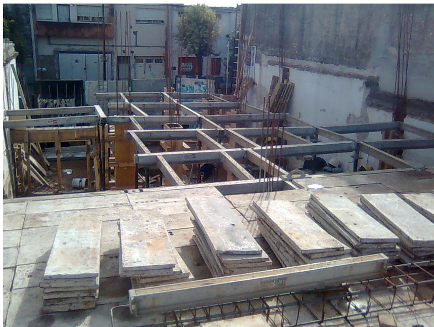
Fig. 53_Acopio de chapones para continuar la colocación.
