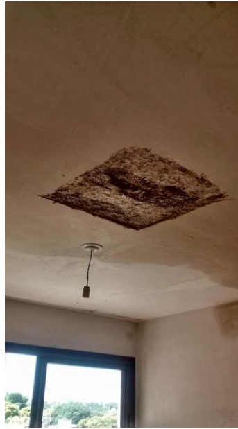
Fig. 7_Remoción de material en la zona afectada por la humedad.
