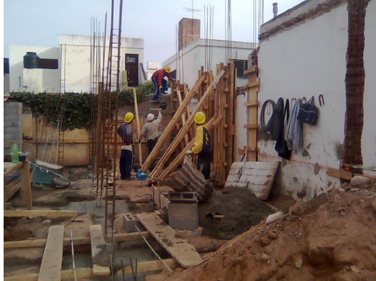
Fig. 49 Impulsión de balde para llenado de columna.
