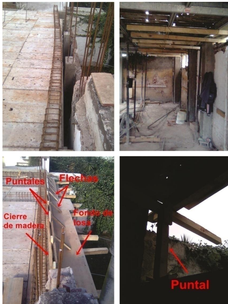
Fig. 54 _Detalles de cierre de losa en extremo.
