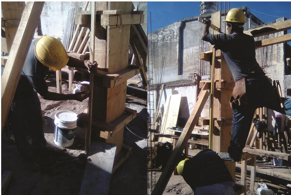
Fig. 47_Definición de nivel de llenado de columna.
