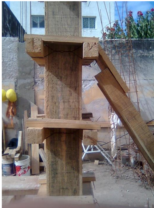
Fig. 42_ Atadura de travesaños con alambre y torniquete.
