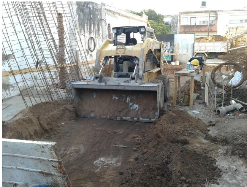
Fig. 23_Extracción de material de excavación.
