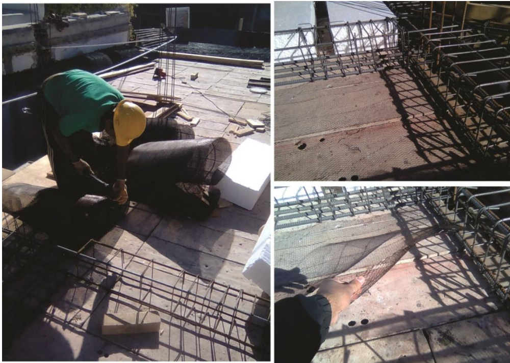
Fig. 61 _Disposición de rollos de metal desplegado.
