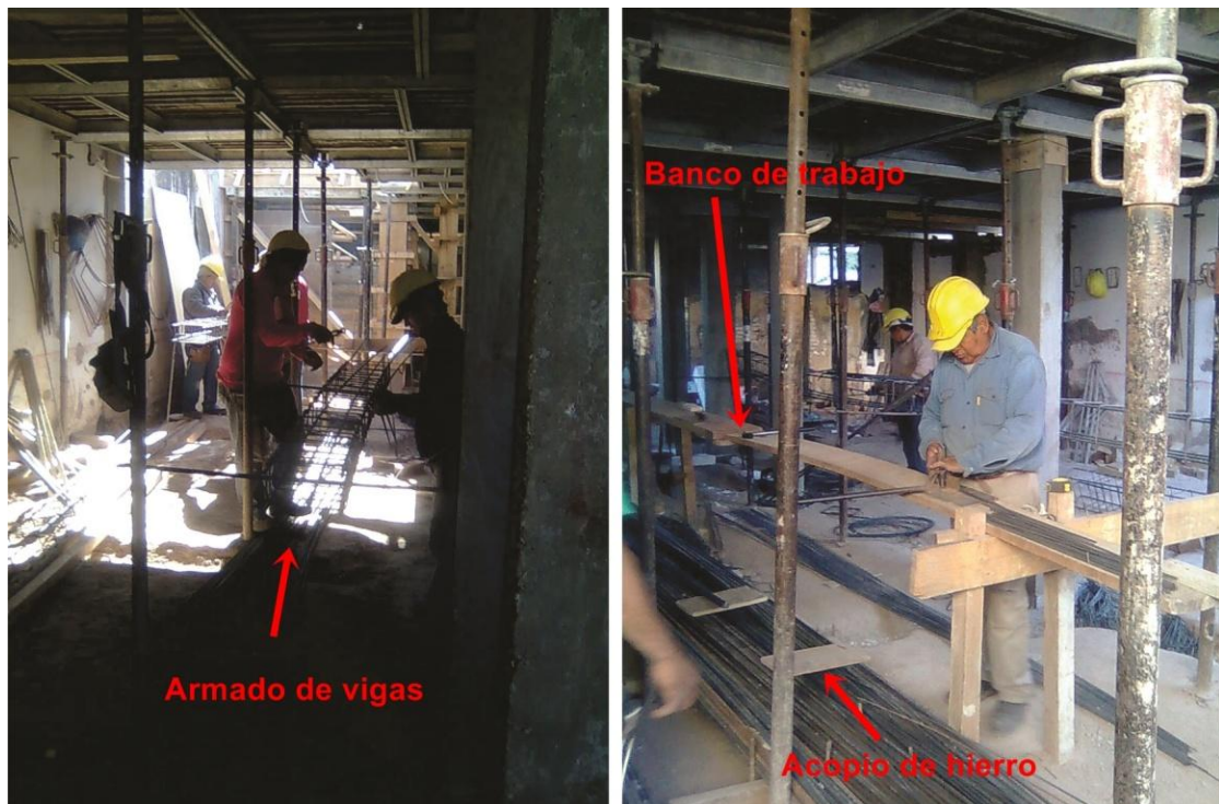
Fig. 58_Armado de vigas en planta baja.
