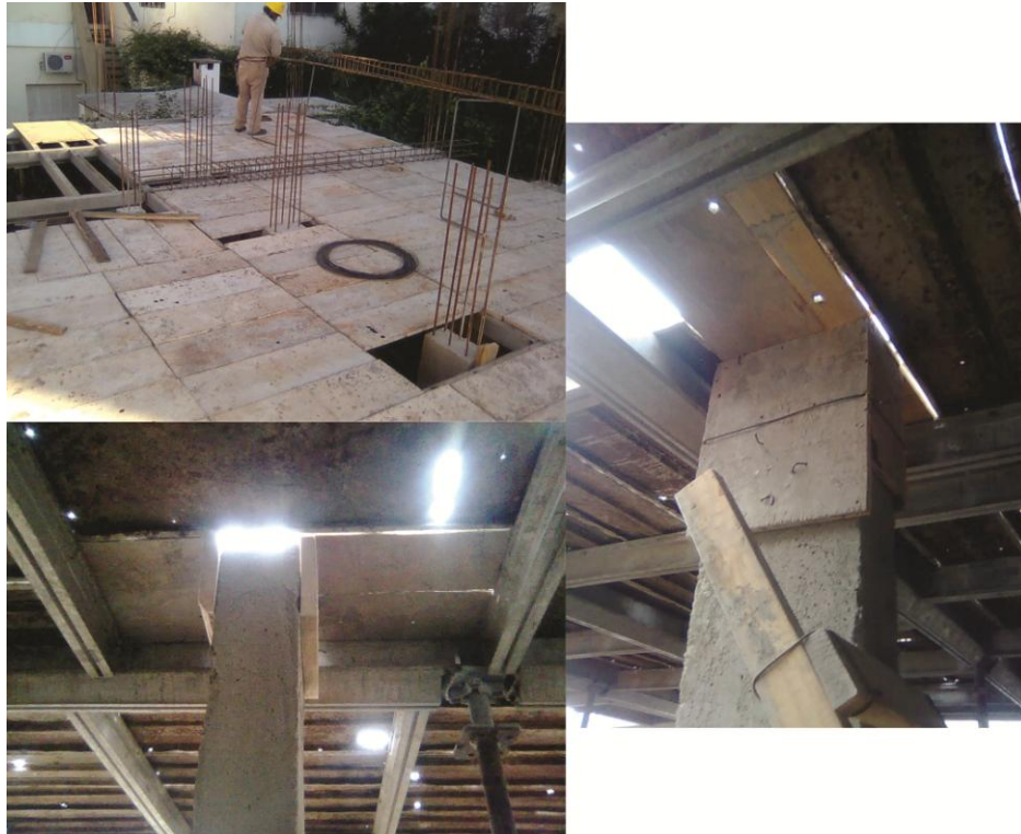
Fig. 55_Detalle de cierre con madera en zona de columna.
