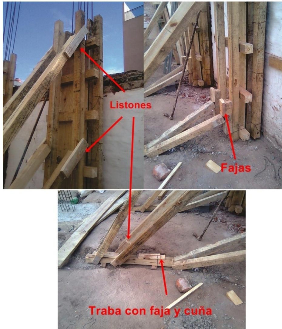
Fig. 44_ Elementos de fijación de encofrado.
