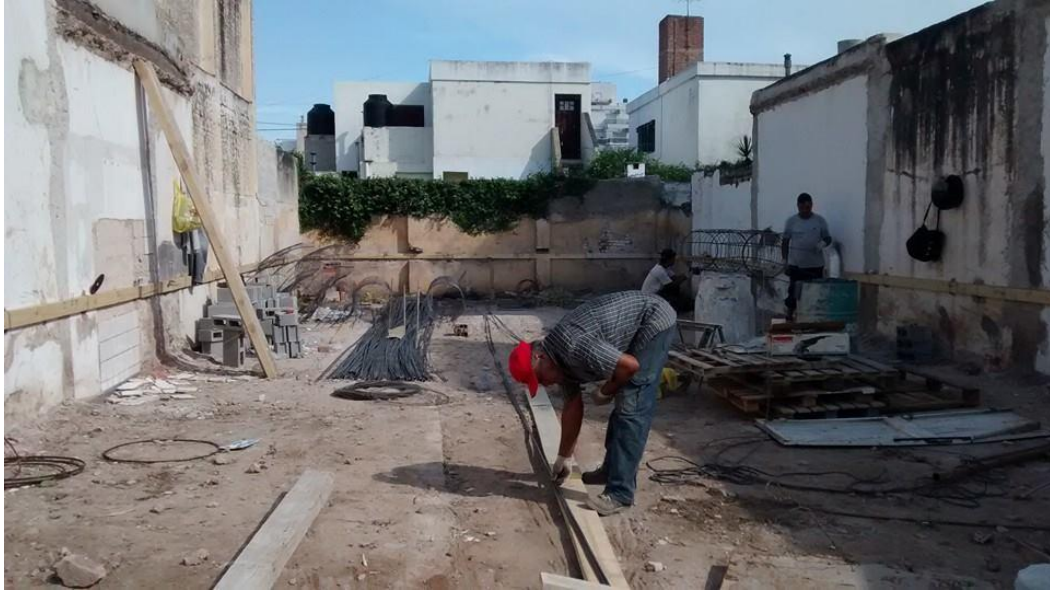
Fig. 19_Trabajo de replanteo.
