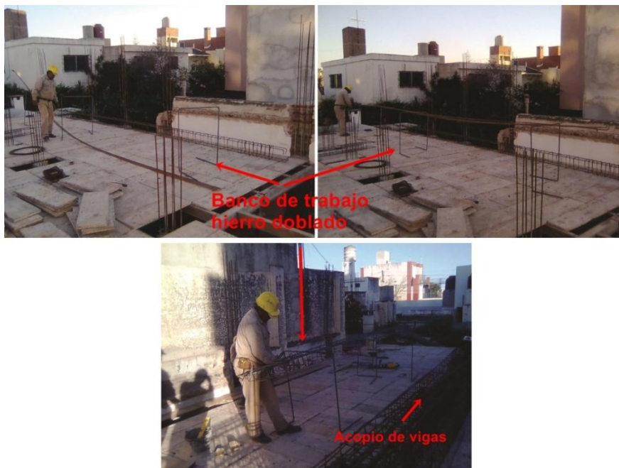
Fig. 57_Armado de vigas sobre encofrado.
