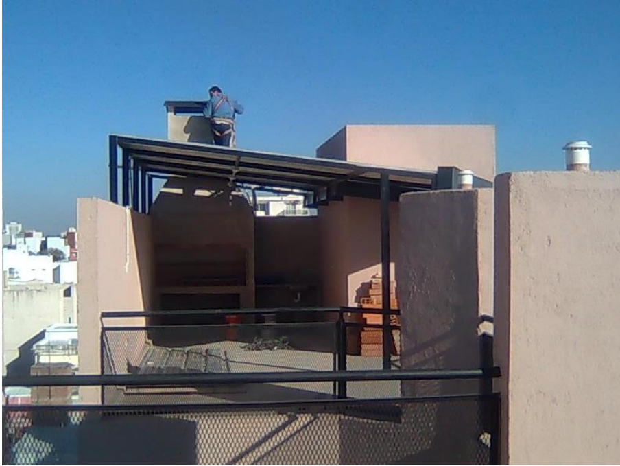
Fig. 14_Trabajos de terminación en terraza.
