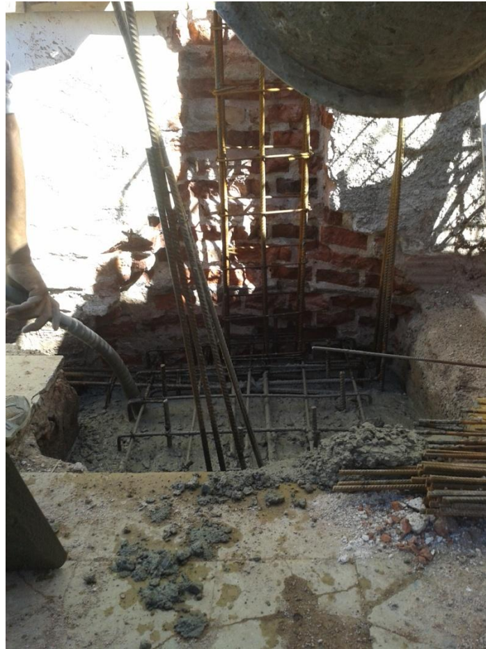
Fig. 33_Vibrado de hormigón en cabezal.
