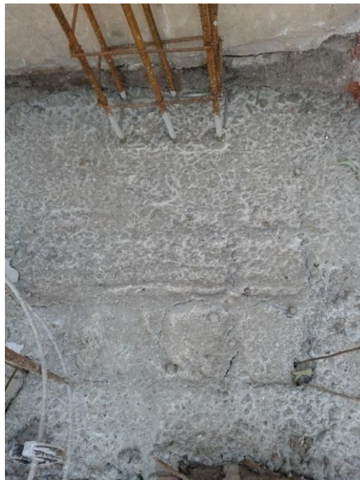
Fig. 36_ Armadura marcada en el hormigón fraguado de cabezales.
