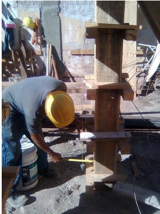
Fig. 46_Control de verticalidad de encofrado.
