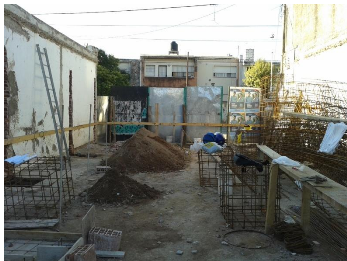
Fig. 22_Montículos de tierra excavada.
