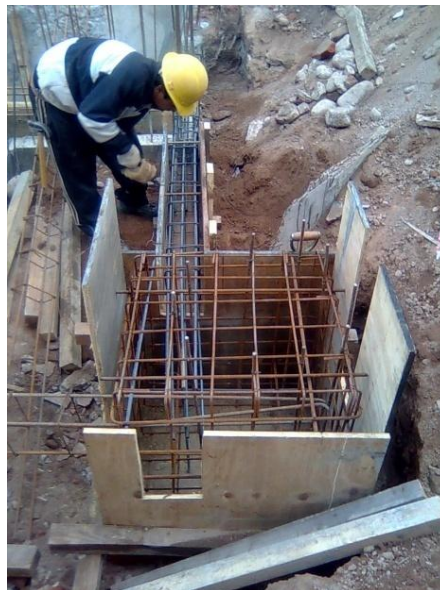
Fig. 27_Disposición de armaduras.
