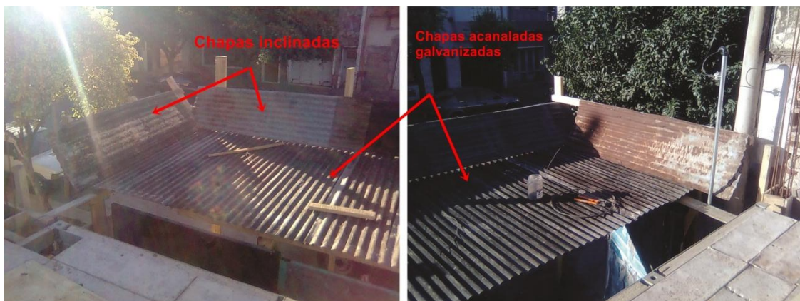
Fig. 70_Detalle bandeja de seguridad.
