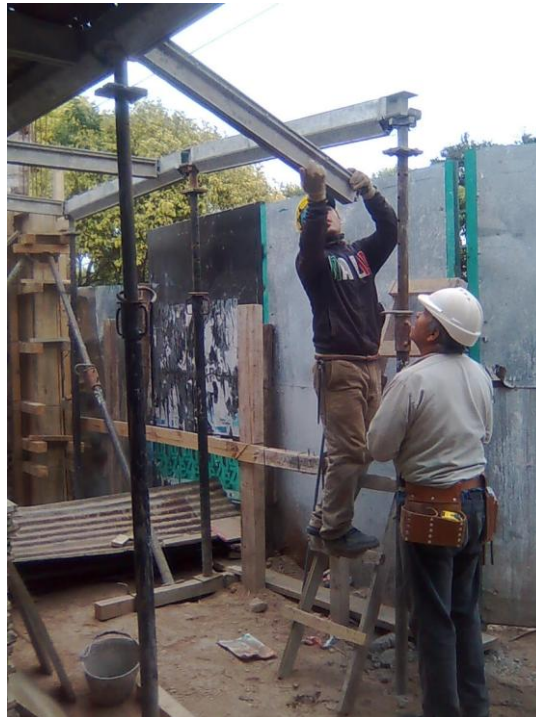
Fig. 51_Operarios armando encofrado metálico.
