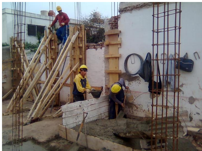
Fig. 48_Carga de hormigón desde "cachingo".
