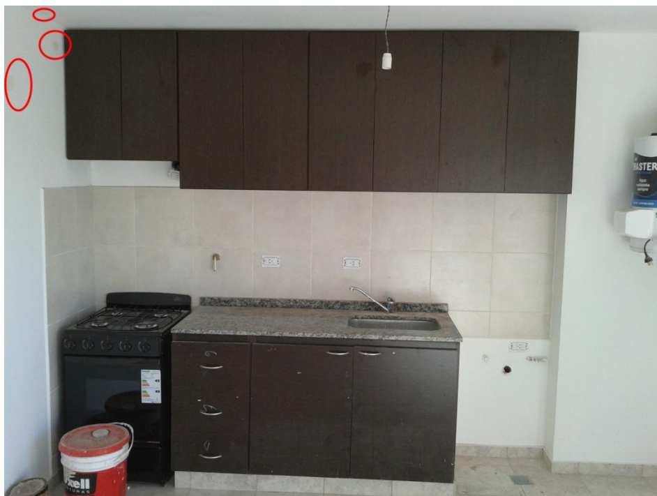
Fig. 8_Corrección de detalles de pintura por colocación de mobiliario.
