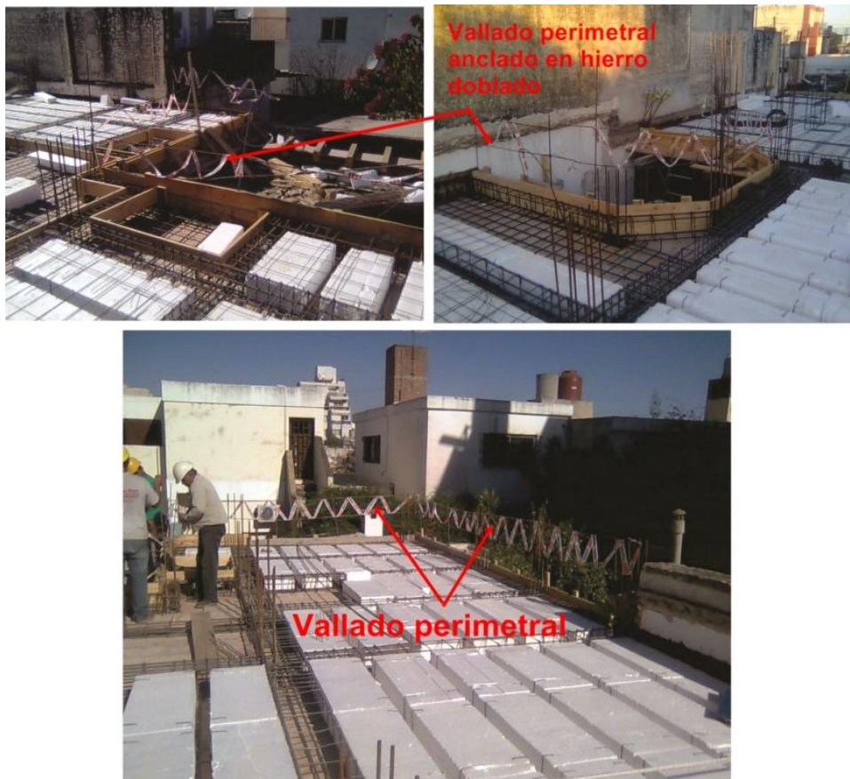
Fig. 72_Vallado en extremos de losa.
