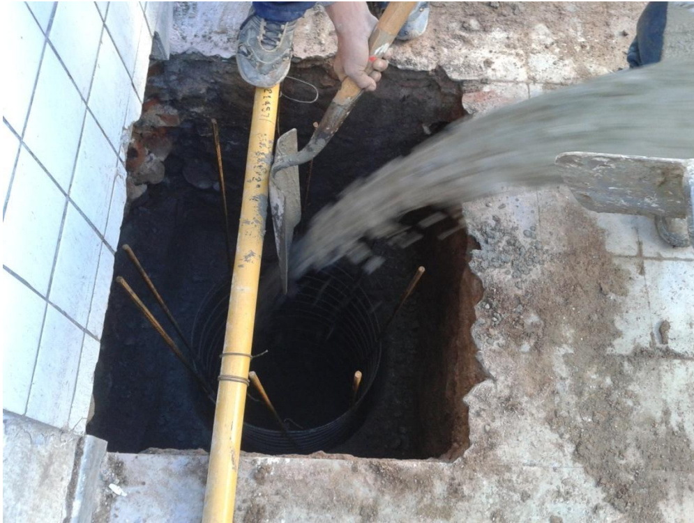
Fig. 31_Colado del hormigón, cuidando de no dañar los bordes de la excavación.
