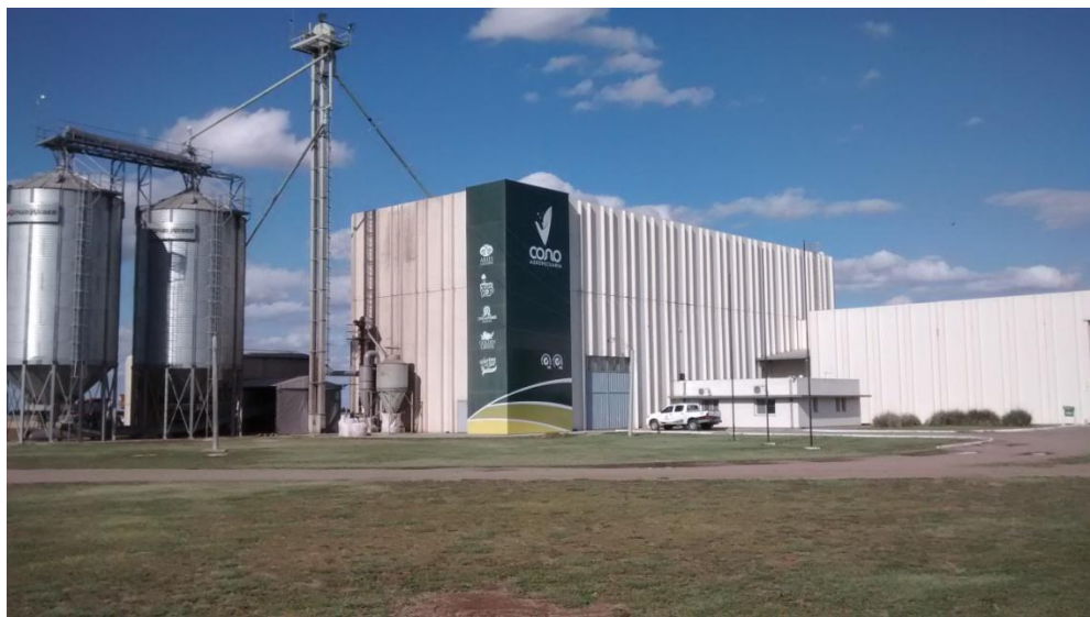
Figura 9: Vista exterior planta Cono Agropecuaria.
