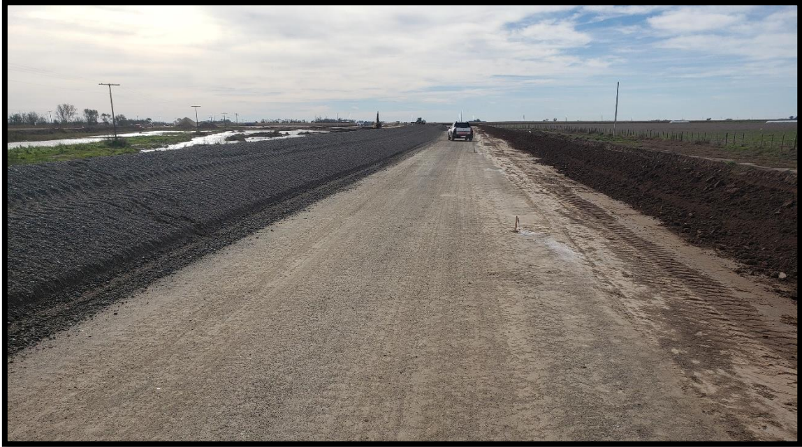
Figura 27 - Base granular acopiada y suelo para banquina
