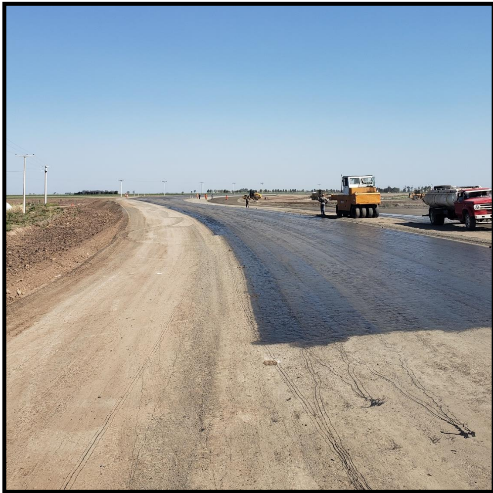
Figura 35 - Riego de imprimación
