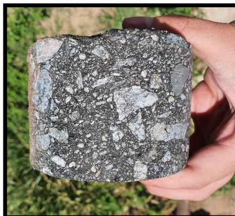
Figura 42 - Testigo extraído de la base negra
