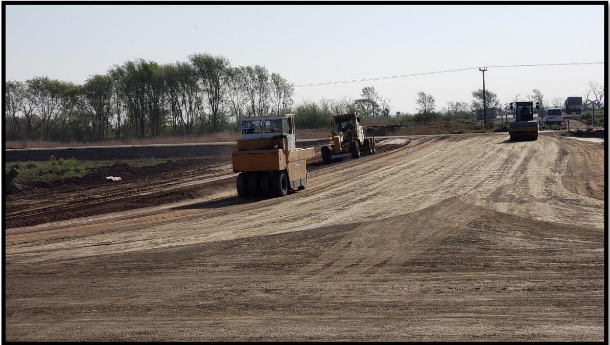
Figura 29 - Rodillo neumático y Rodillo vibro liso compactando Base Granular
