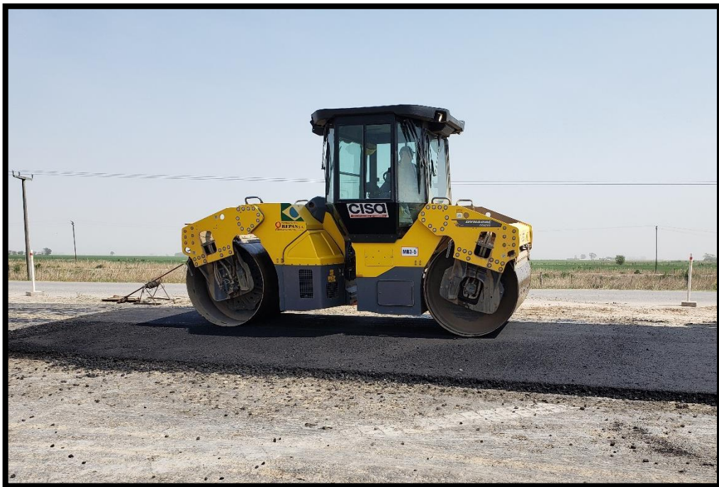
Figura 39 - Aplanadora pisando base negra
