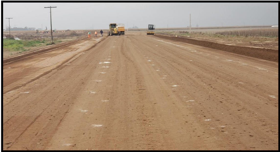
Figura 22 - Subbase nivelada para aprobación
