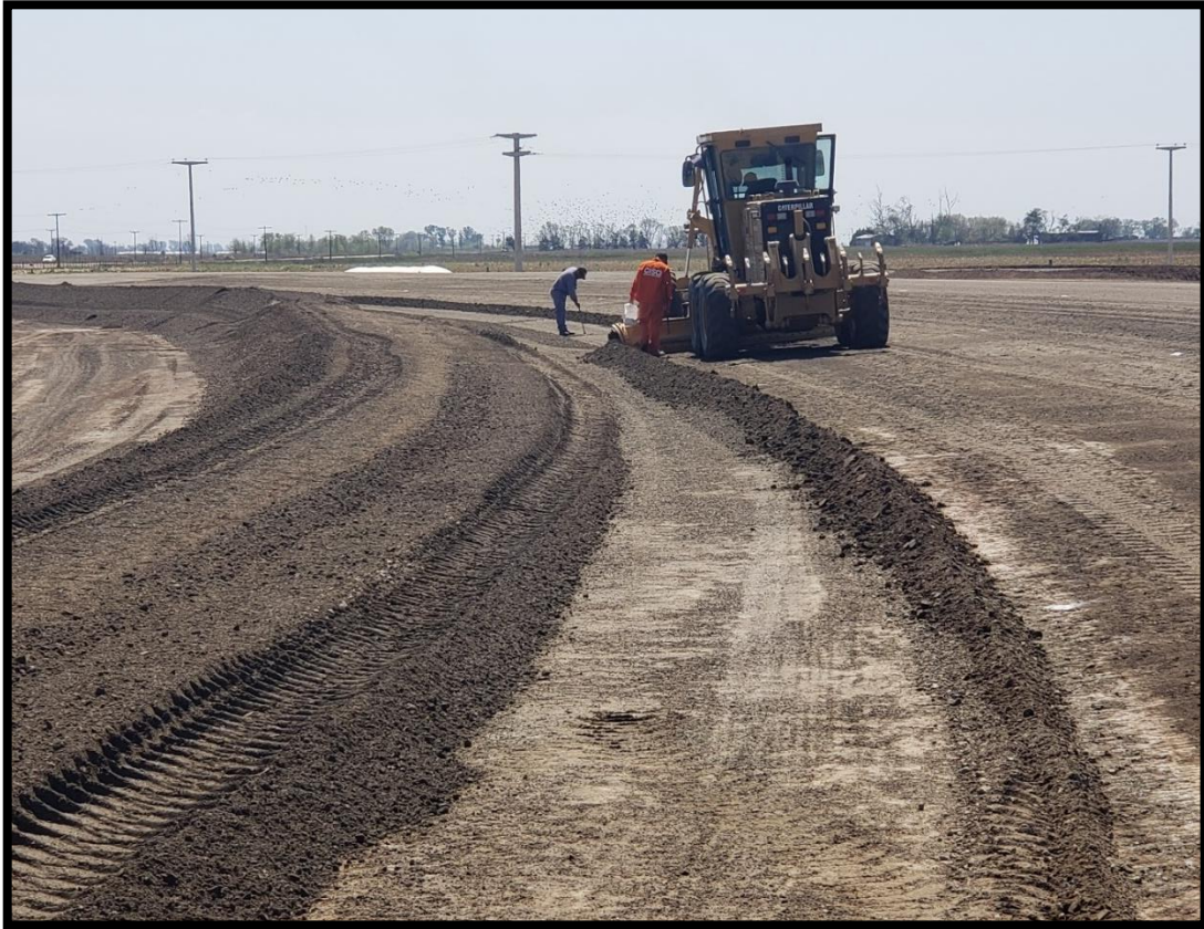
Figura 26 - Motoniveladora trabajando base granular
