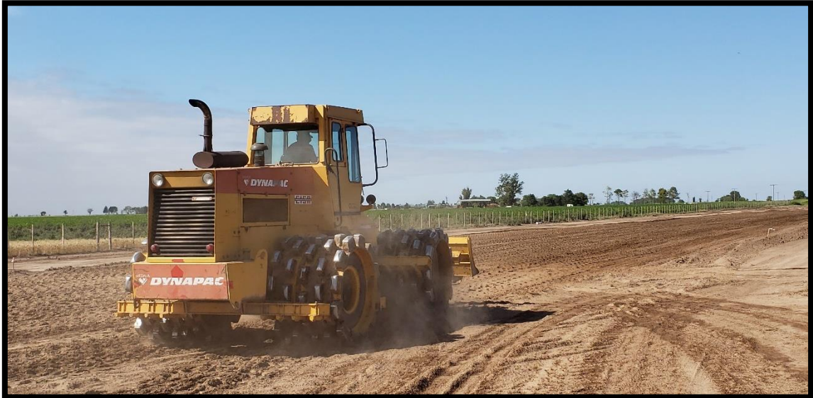
Figura 15 - Compactación de suelo con pata de cabra
