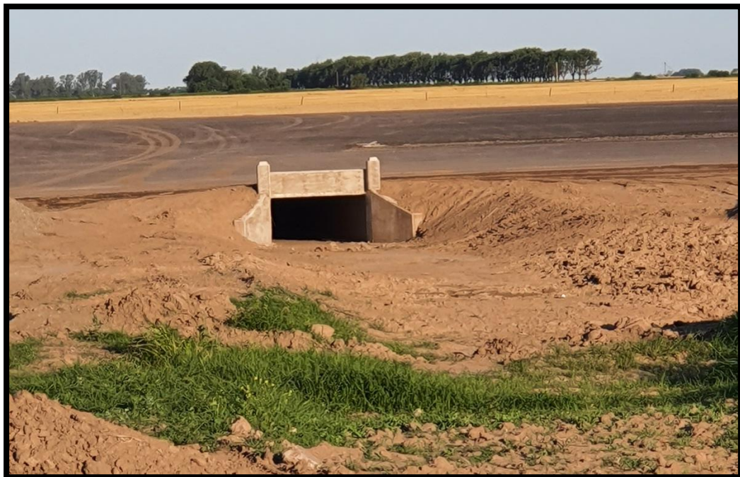
Figura 20 - Alcantarilla con muros de ala y guarda rueda
