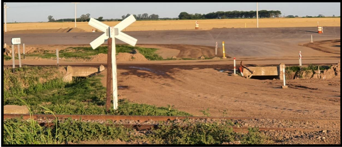
Figura 10 - Alcantarillas sobre RP-10
