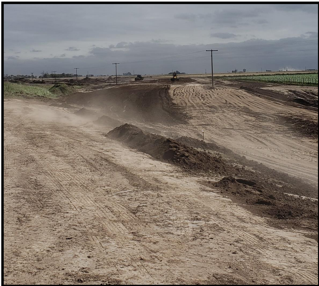
Figura 11 - Limpieza de terreno
