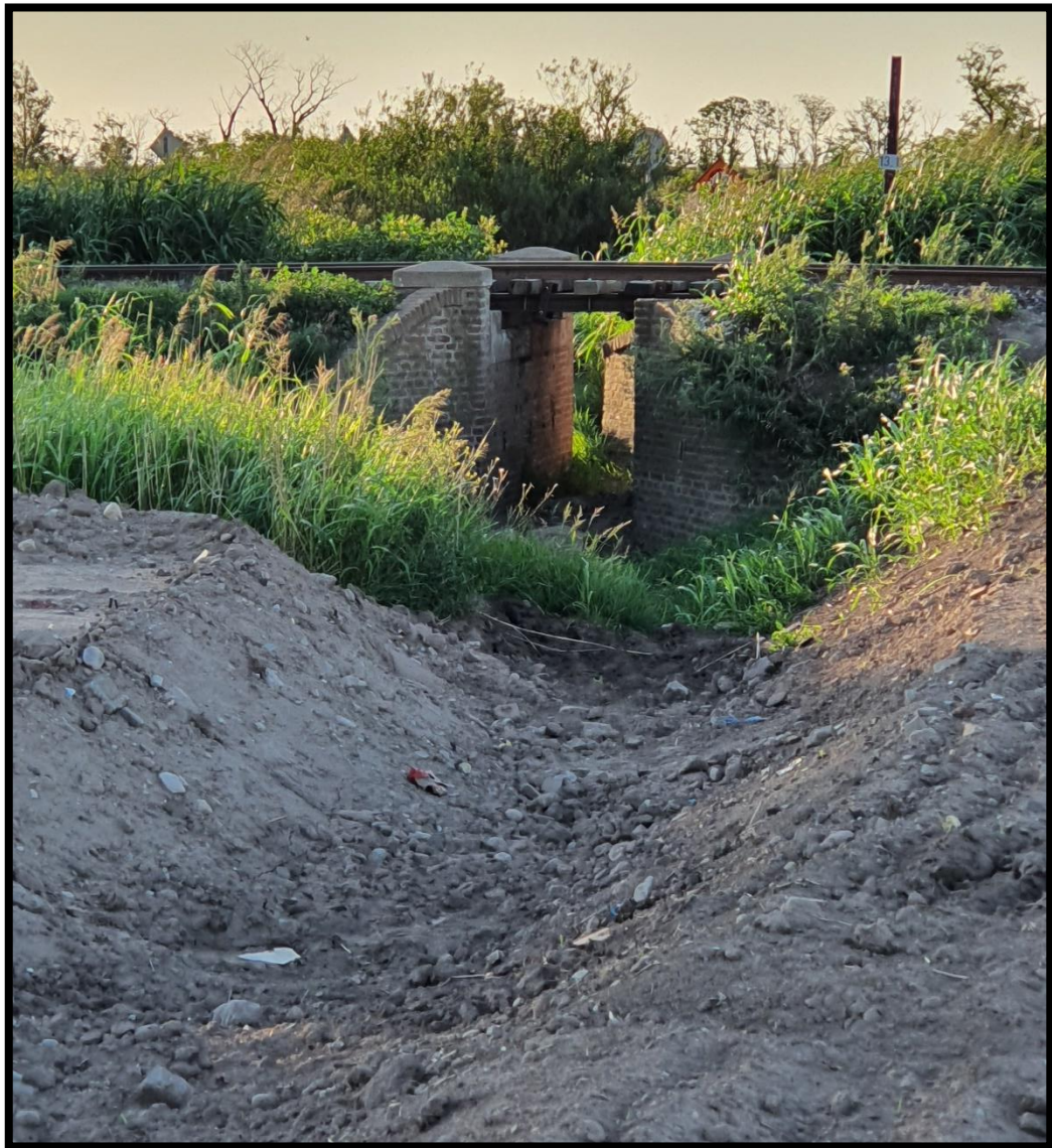
Figura 9 - Alcantarilla en cruce de ferrocarril
