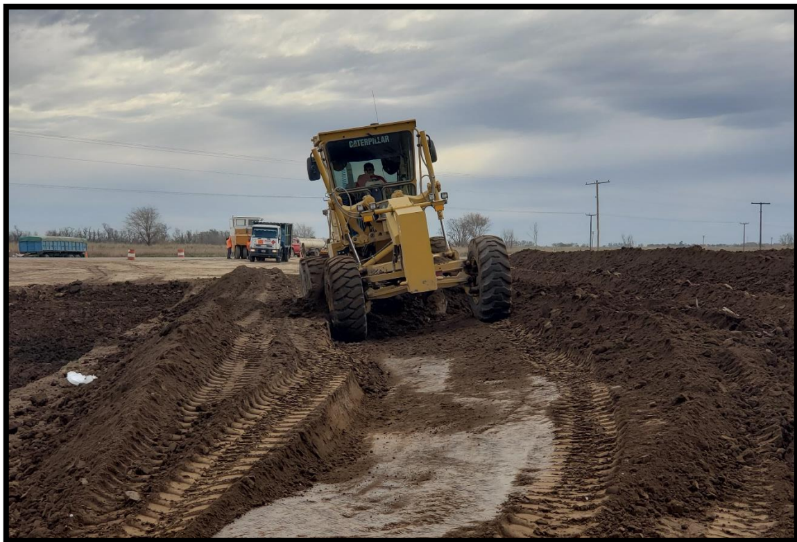
Figura 16 - Motoniveladora trabajando suelo
