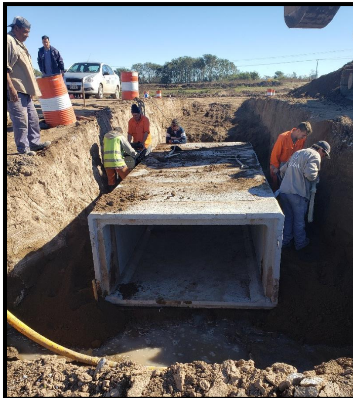
Figura 19 - Colocación de módulos póstico
