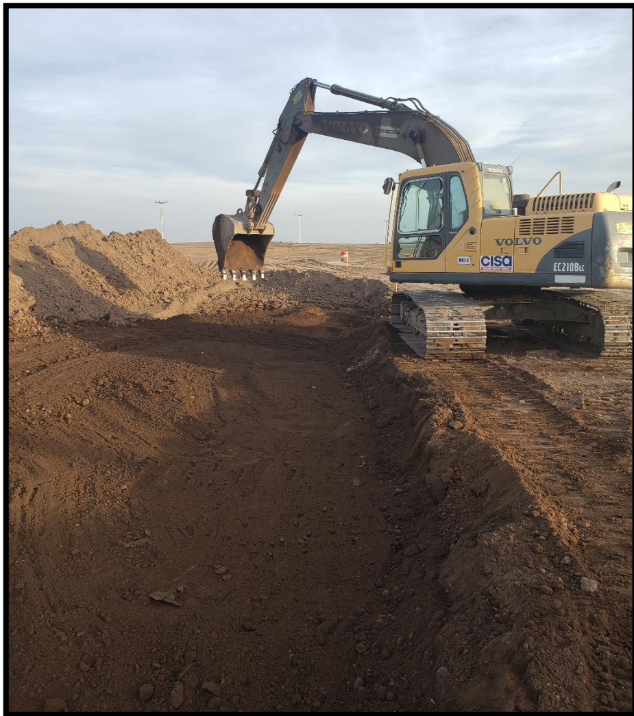
Figura 13 - Reemplazo de suelo por suelo con cal
