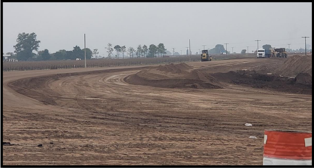
Figura 21 - Mezcla de materiales sobre el tramo
