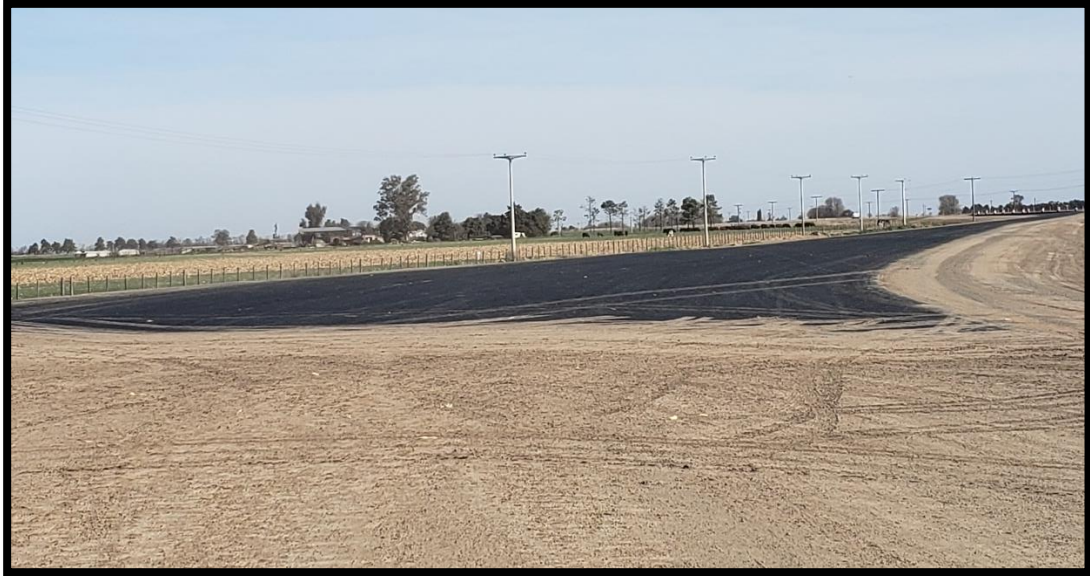
Figura 34 - Tramo de base imprimado
