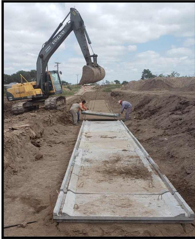
Figura 18 - Colocación de pisos de alcantarilla
