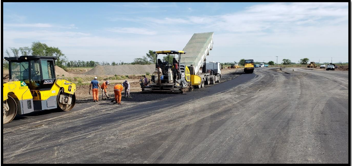
Figura 38 - Colocación de base negra con terminadora
