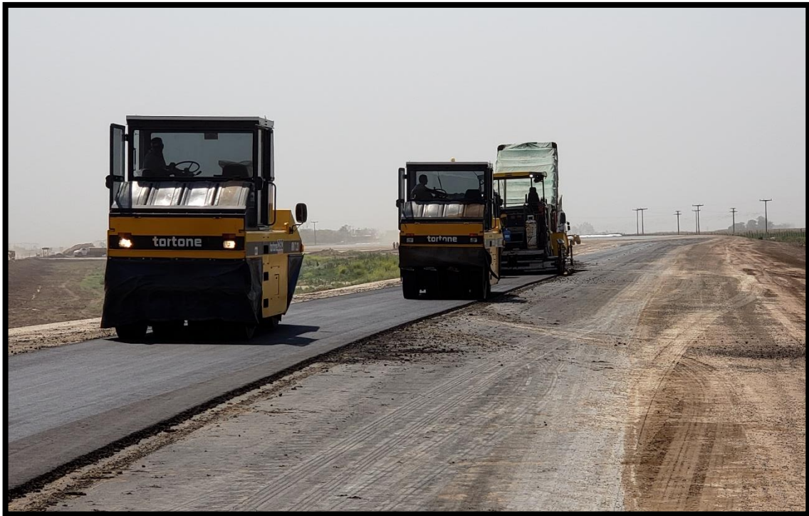
Figura 40 - Rodillos neumáticos en simultaneo con avance de terminadora
