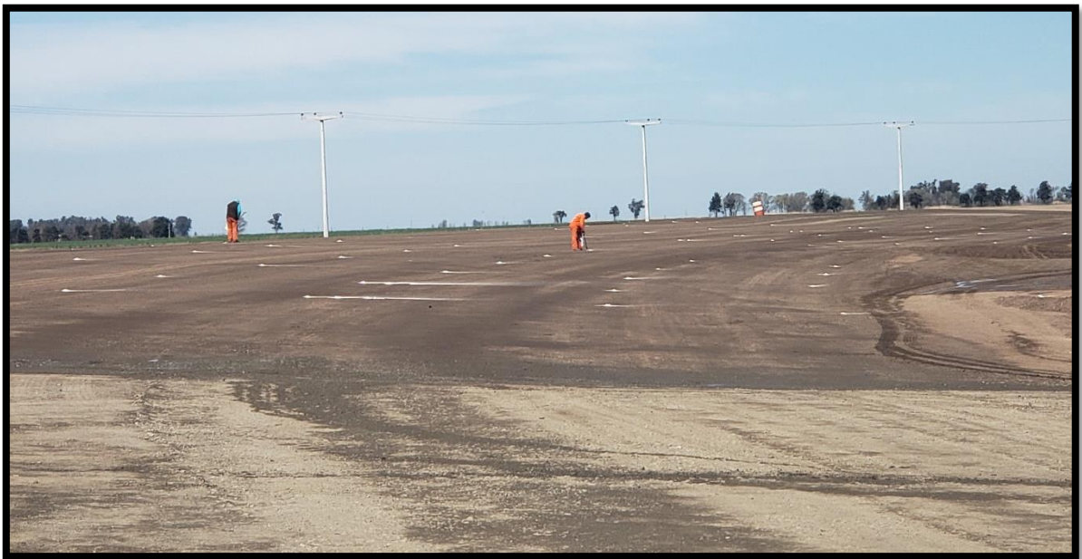
Figura 28 - Tramo de base nivelado y cortado por motoniveladora
