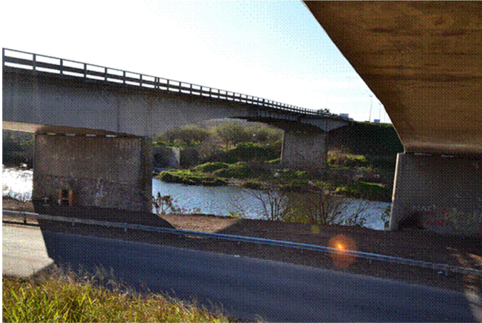
Figura 2.8. Vista general de uno de los Puentes.
