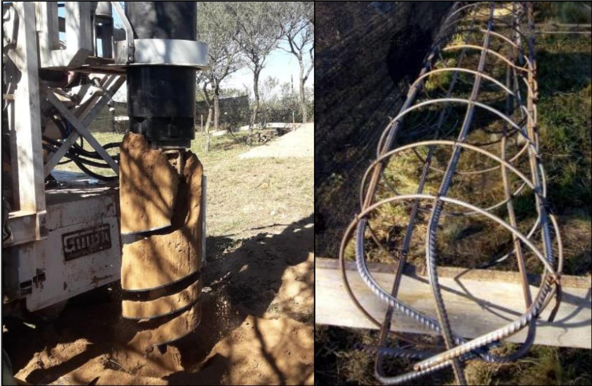
Figura A.5: a) Excavación mecánica de pilote. b) Armadura para pilote.
