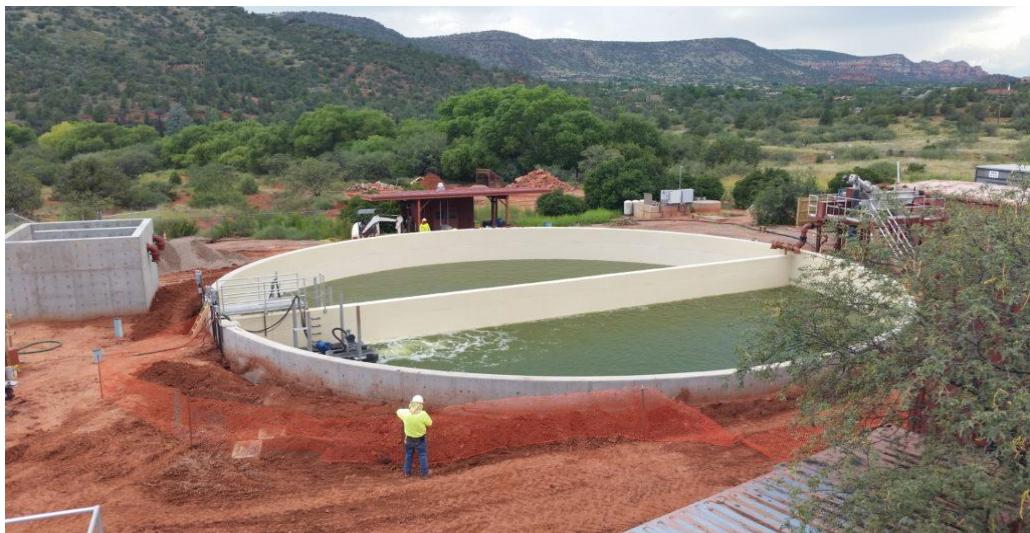
Figura 4. 7 - Ecuador de caudal cilíndrico, con división
