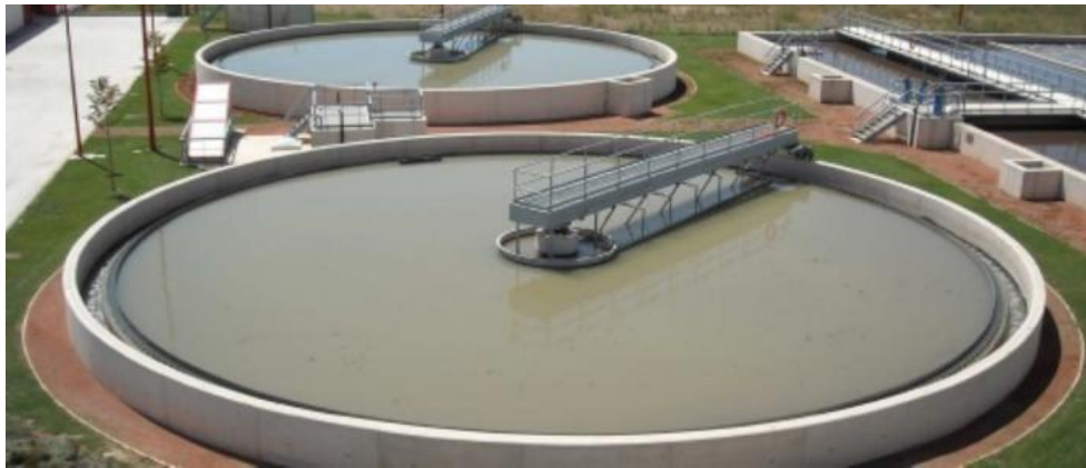
Figura 2. 19 - Decantadores primarios utilizados en sedimentación floculenta
