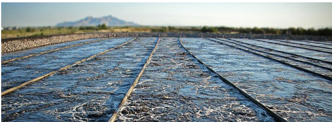
Figura 2. 21 - Laguna aireada por difusores flotantes
