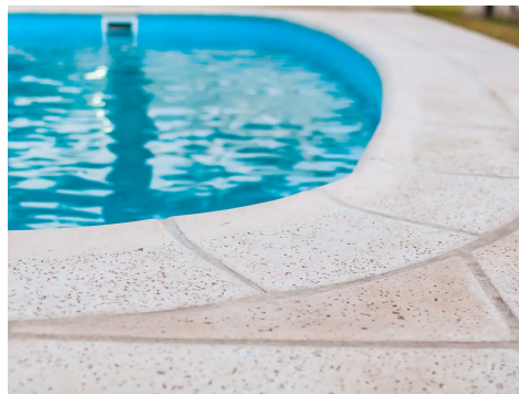
Gráficos VII y VIII. Borde atérmico “L” 50x50. Vereda atérmica instalada.
