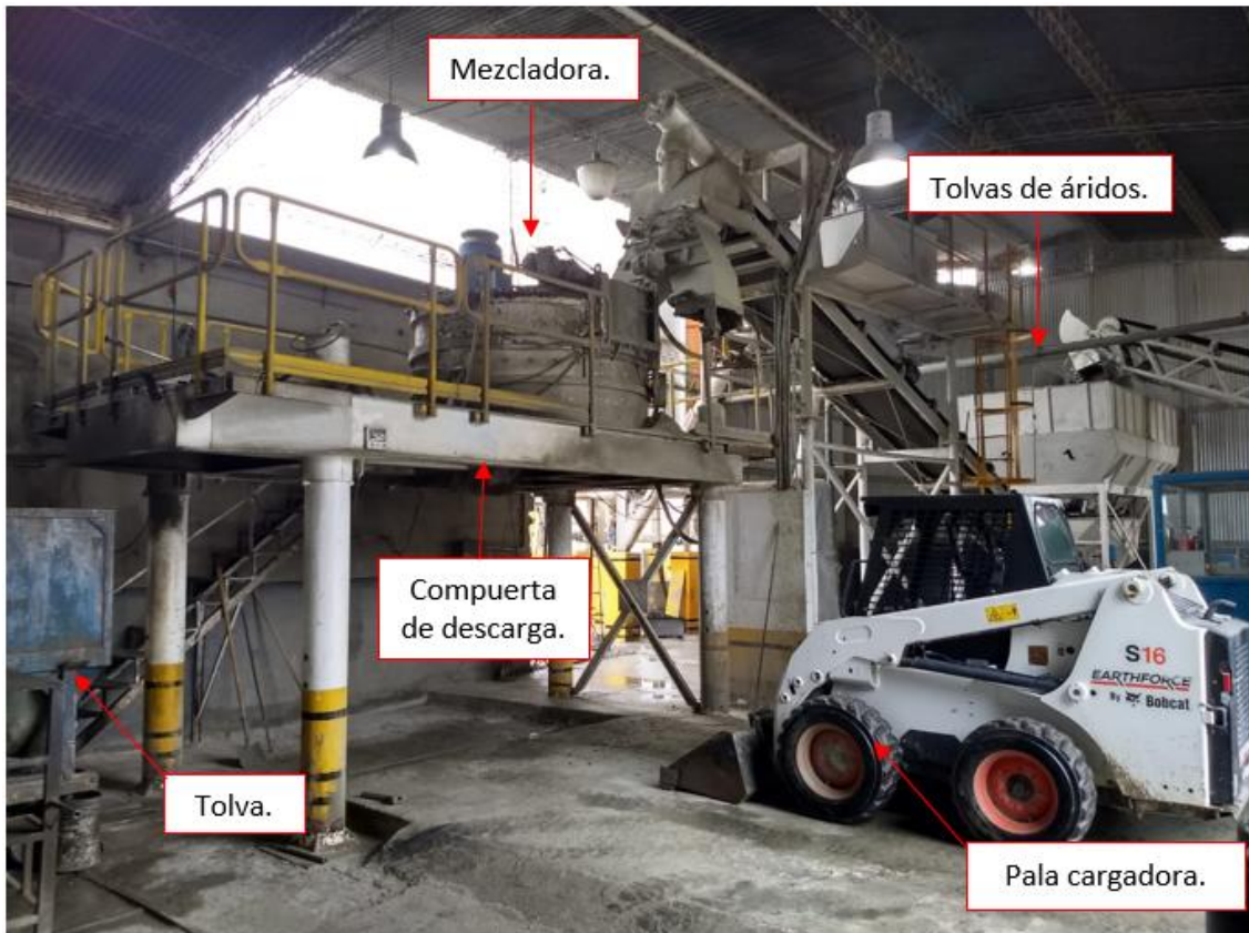
Imagen 5.9. Equipo hormigonero de Hormicoop, minipala cargadora y tolva de llenado.
