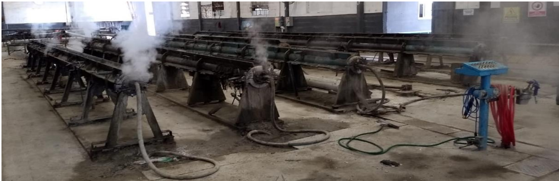
Imagen 5.11. Moldes de poste de baja tensión durante el proceso de curado a vapor.
