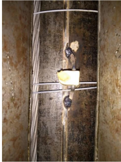
Imagen 5.8. Bloquete o PAT soldada al hierro liso AL 10mm.
