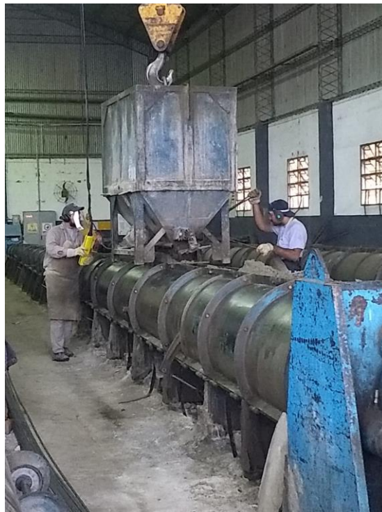
Imagen 5.10. Operarios ejecutando el colado de hormigón de un poste de alta tensión.
