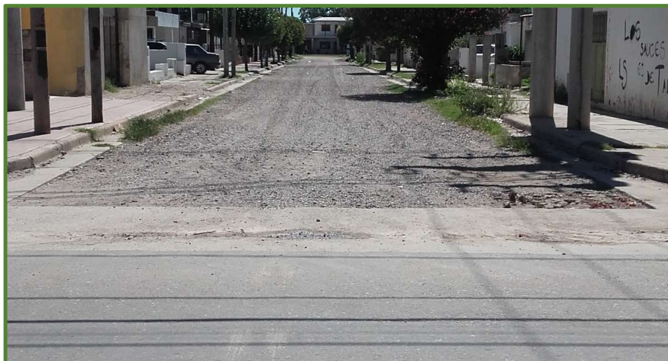
Figura 44 – Calle Los Guayacanes (Relevamiento Topográfico – Municipalidad de Córdoba)
