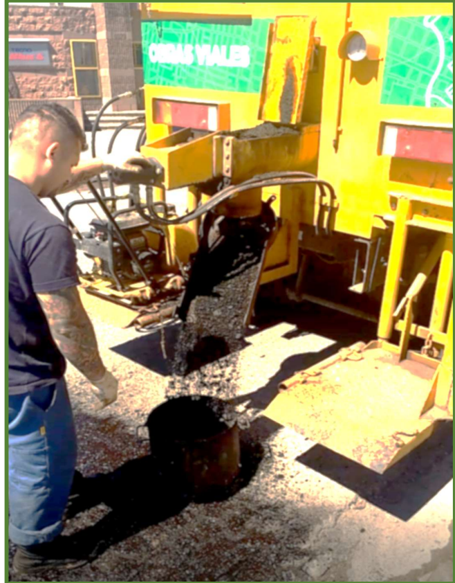
Figura 64 - Toma de muestra de Camion Asfaltero en Obra de Bacheo
