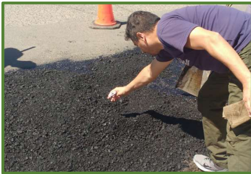
Figura 65 - Medición de Temperatura en Bacheo
