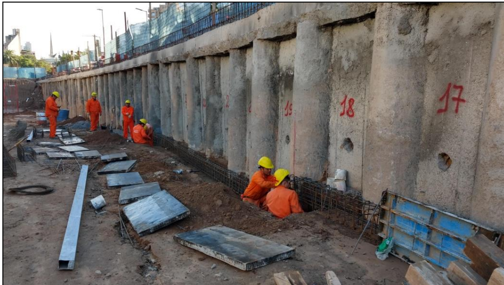
3.57. Armado y encofrado. Fuente: Elaboración propia
