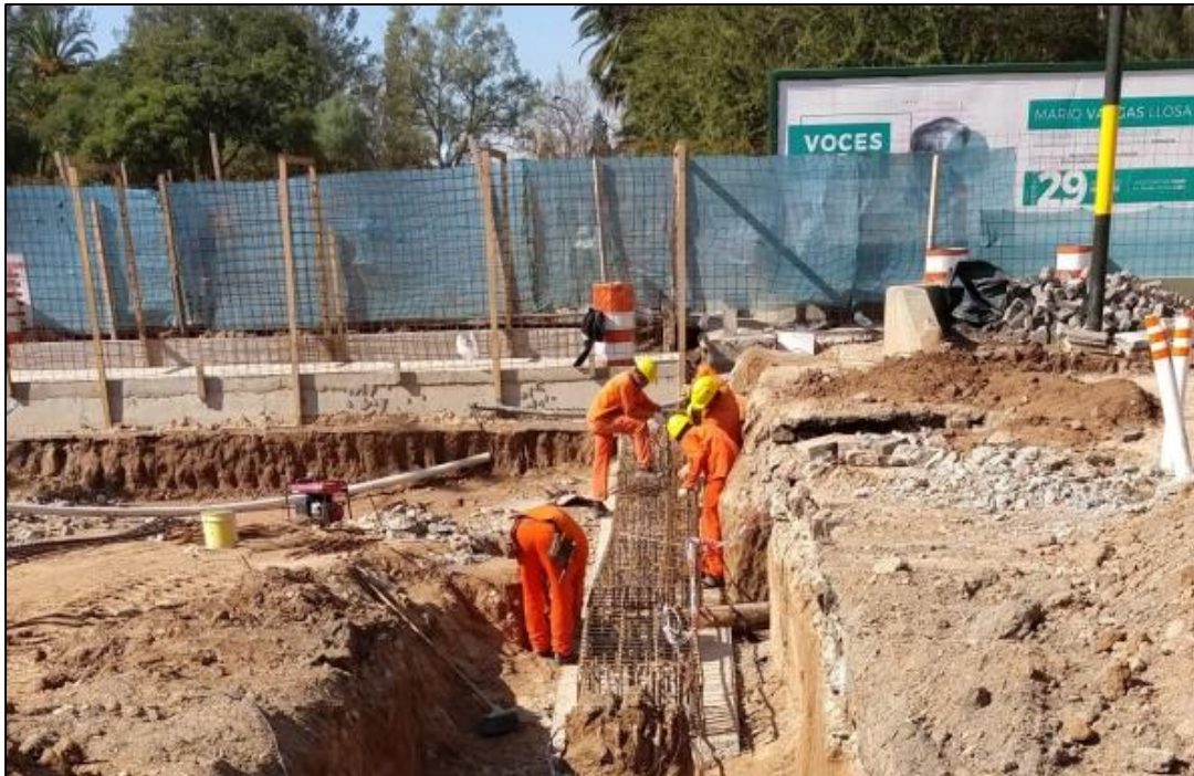
Fig. 3.65. Armado in situ de la viga dintel longitudinal. Fuente: Elaboración propia.
