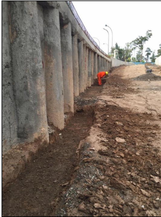
Fig. 3.52. Excavación del terreno lado derecho. Fuente: Elaboración propia.
