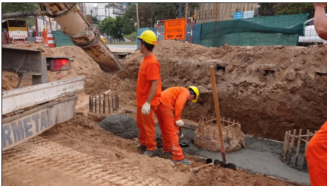
Fig. 3.64. Colocación de reglas para posterior ejecución del hormigonado de limpieza. Fuente: Elaboración propia.
