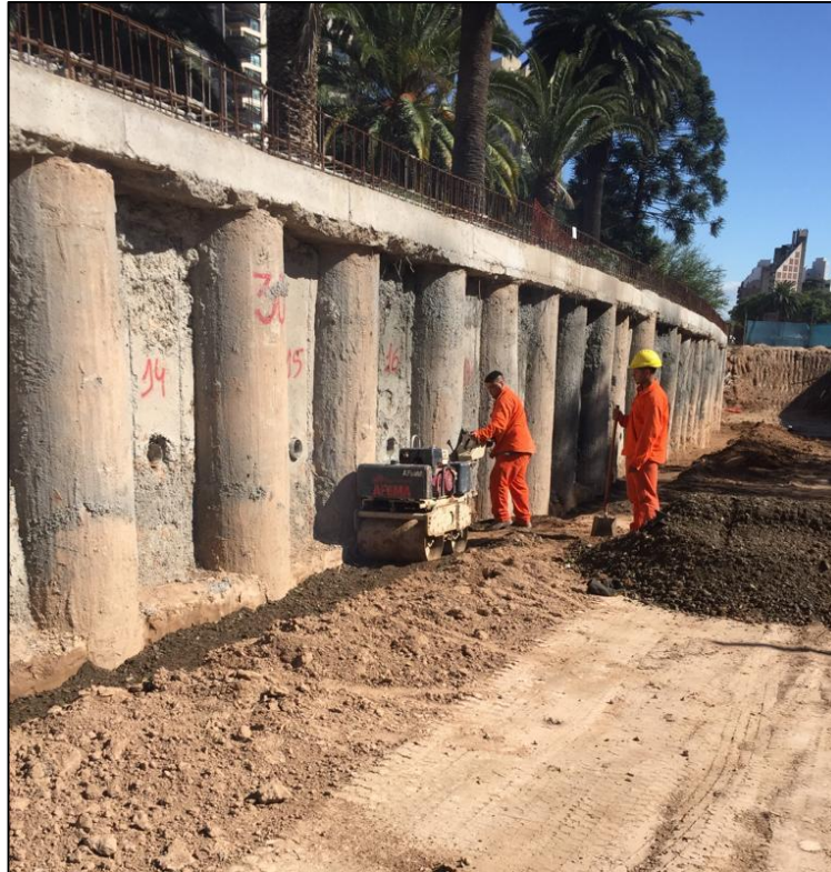
3.54. Nivelación y compactación del terreno. Fuente: Elaboración propia
