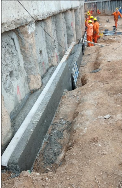
3.58. Desencofrado. Fuente: Elaboración propia
