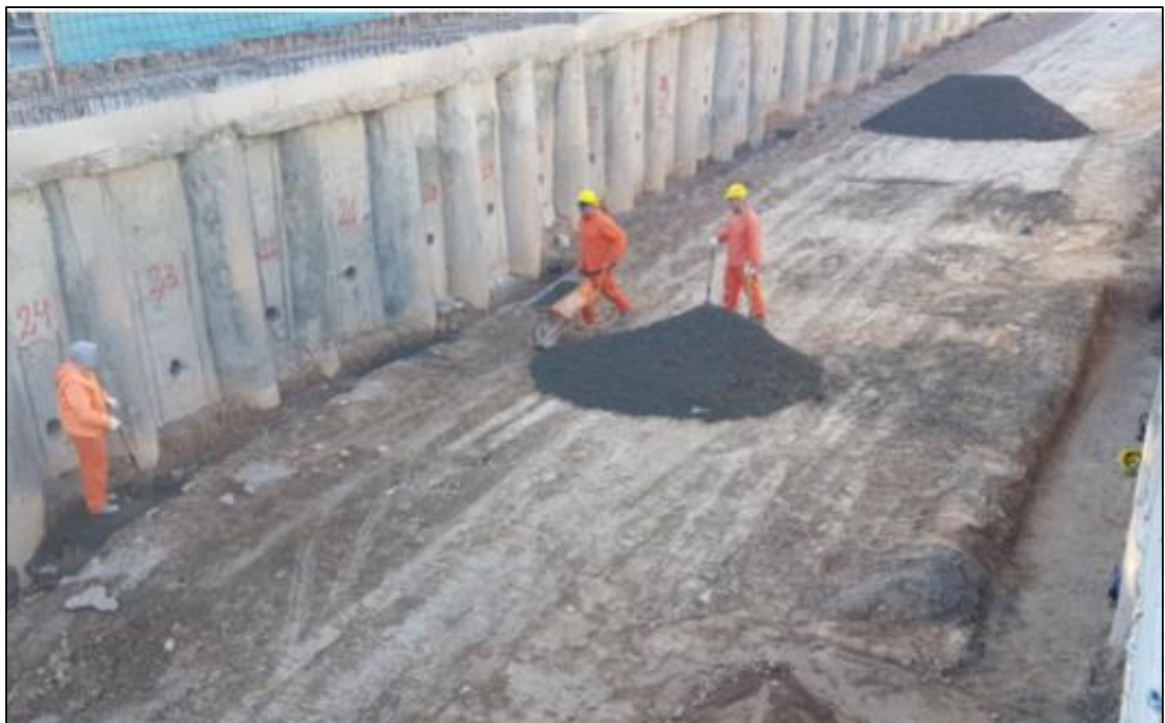
3.55. Colocación de material granular y compactación del mismo. Fuente: Elaboración propia.
