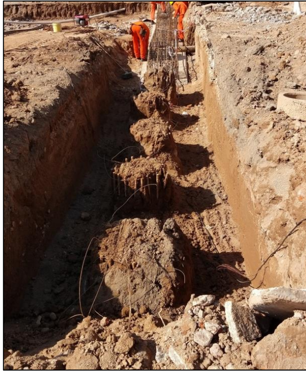
Fig. 3.61. Excavación hasta nivel de armaduras. Fuente: Elaboración propia
