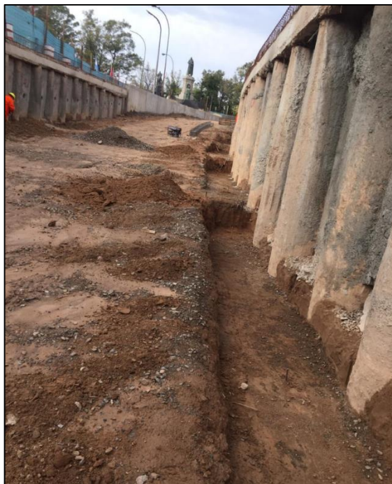
Fig. 3.53. Excavación del terreno lado izquierdo. Fuente: Elaboración propia
