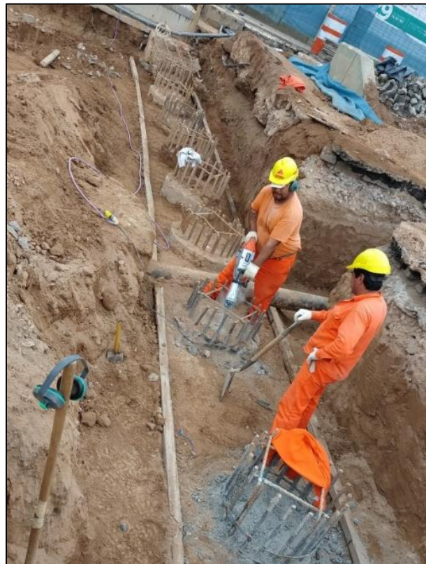
Fig. 3.62. Desmoche de pilotes. Fuente: Elaboración propia
