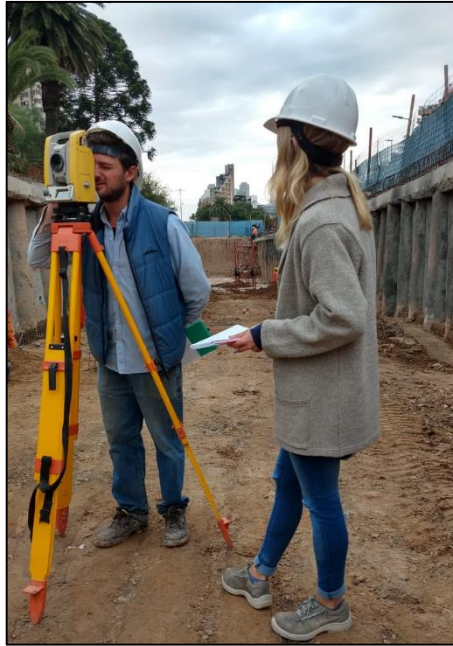
Fig. 3.50. Replanteo planialtimétrico. Fuente: Elaboración propia.
