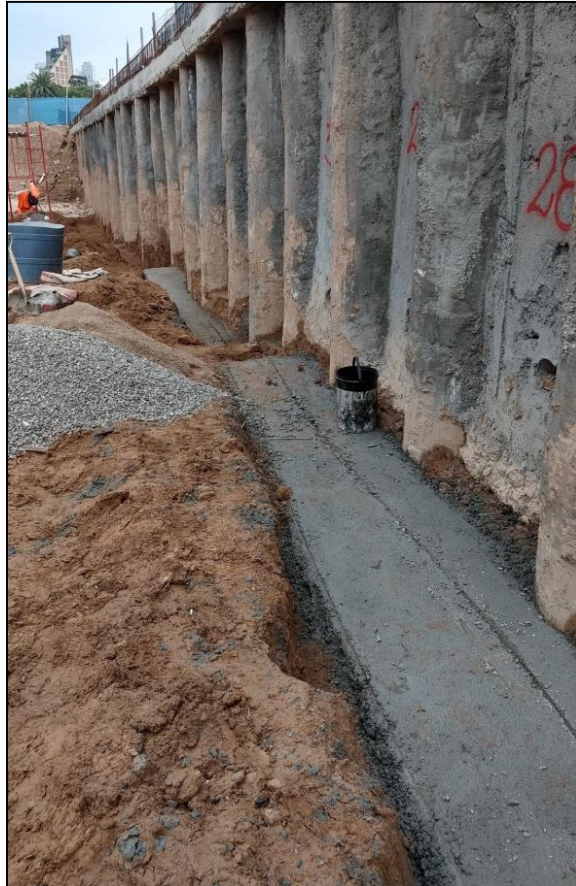
3.56. Hormigón de nivelación. Fuente: Elaboración propia.
