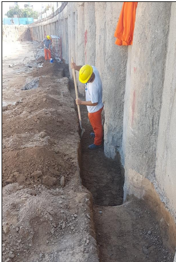
Fig. 3.51. Excavación del terreno. Fuente: Elaboración propia.
