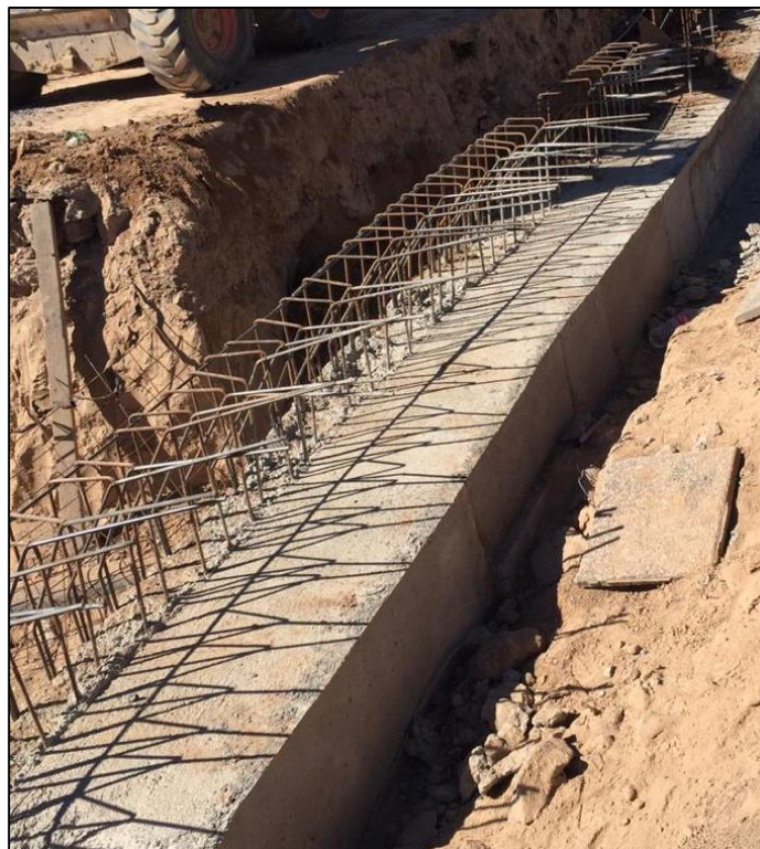
Fig. 3.66. Hormigonado 1° y 2° etapa de la viga dintel longitudinal. Fuente: Elaboración propia
