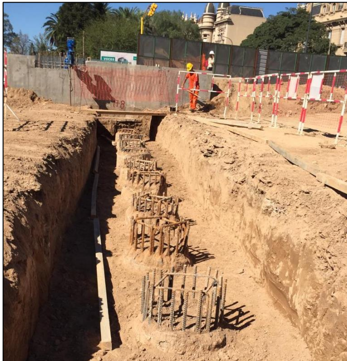
Fig. 3.63. Pilotes luego de realizar el desmoche. Fuente: Elaboración propia.
