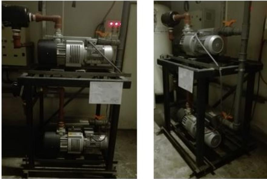
Figura 4.51: Soporte para sistema de bombas dúplex
