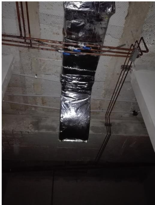
Figura 13.7: Derivación a Quirófano, Colocación Válvulas de Corte
