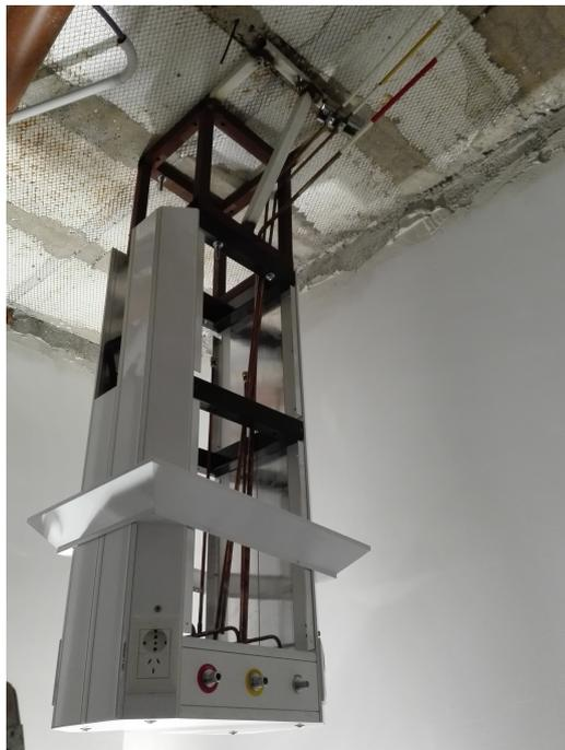
Figura 13.9: Montaje en Quirófano de una Columna de Techo con su respectivo soporte
