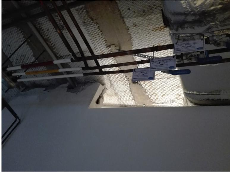
Figura 13.8: Marcación de Cañería e Identificación de Válvulas de Corte
