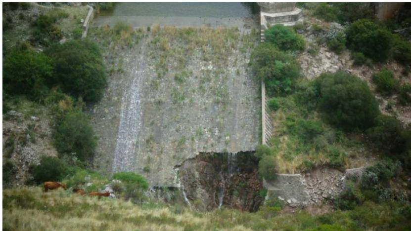
*Figura 50: Vista de la rotura de la rápida del vertedero de descarga del dique Los Alazanes*
