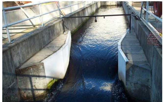
*Figura 1: Izquierda: Molinete. Derecha: Canaleta Parshall.*
