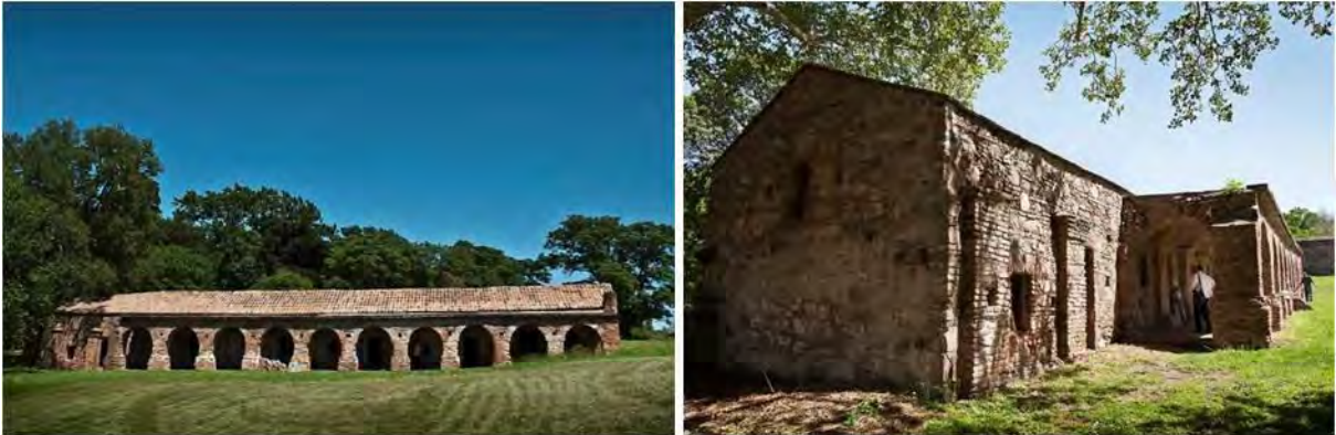
Figura 15: Vistas generales del edificio del Noviciado
