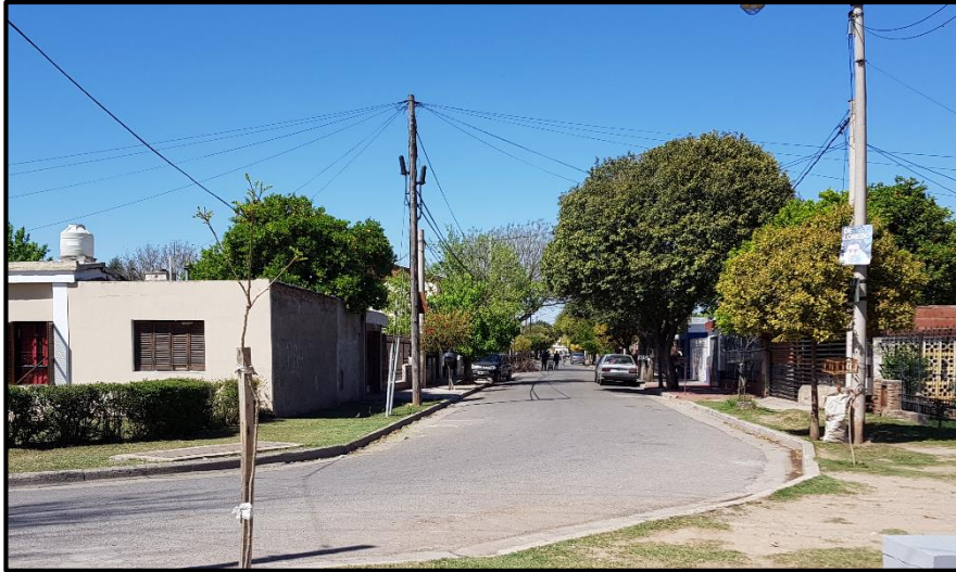
Figura 1.4.1.2.3 – Tendido eléctrico calle Bracamonte esquina Pje. Tavira (límite norte del barrio) (Fuente: Elaboración propia)
