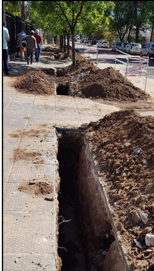
Figura 4.2.5.3 – Zanja terminada preservando acceso cocheras (Fuente: Elaboración propia)
