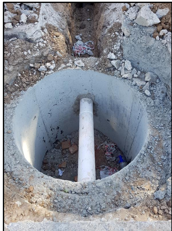
Figura 4.2.4.2 – BR desencofrada (Fuente: Elaboración propia)
