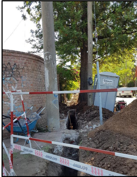
Figura 4.2.1.1 – Baño químico y vallado en obra (Fuente: Elaboración propia)
