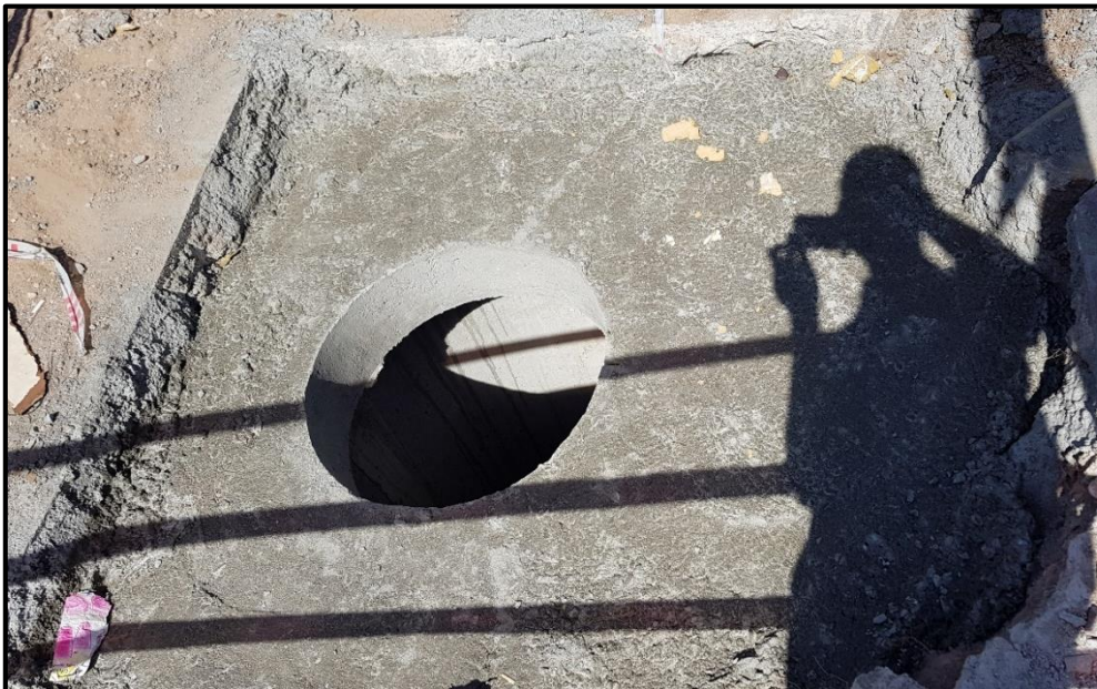
Figura 4.2.4.4 – Losa de BR terminada (Fuente: Elaboración propia)
