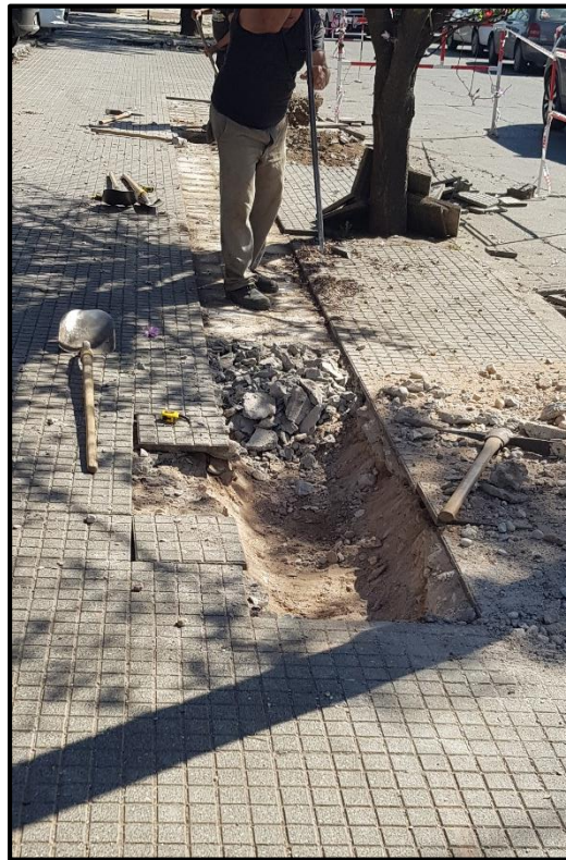
Figura 4.2.5.1 – Trabajos de excavación zanja (Fuente: Elaboración propia)
