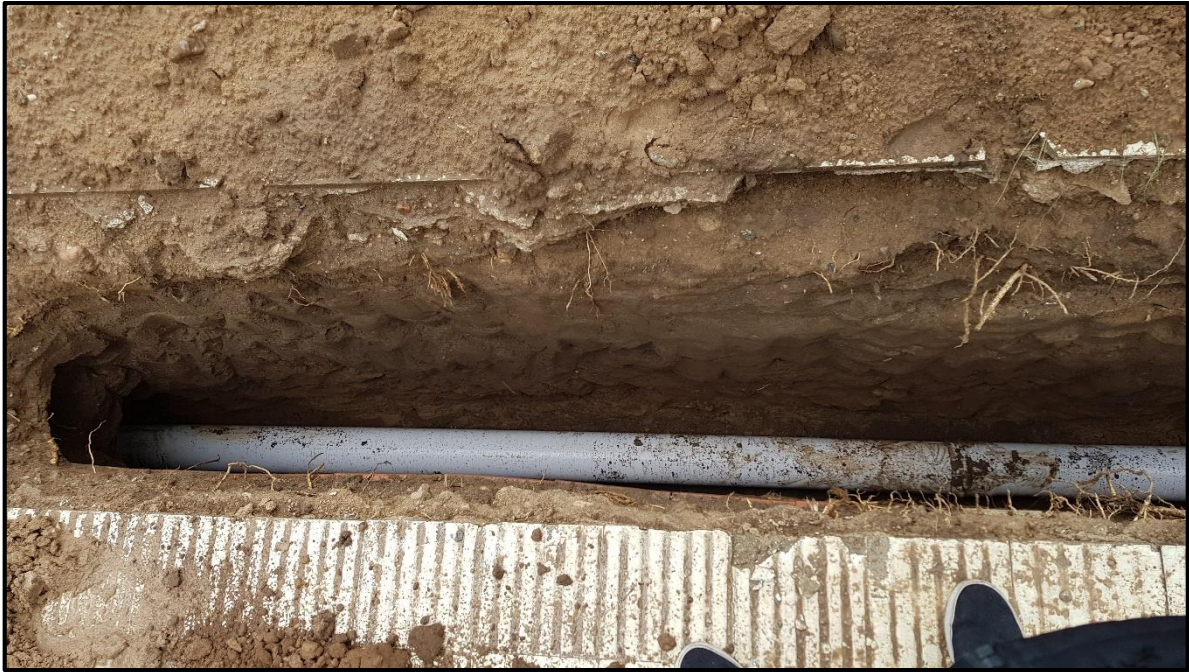
Figura 4.2.6.1 – Cañería asentada en zanja (Fuente: Elaboración propia)
