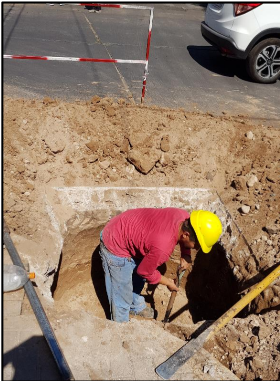
Figura 4.2.4.1 – Obrero excavando pozo para futura BR (Fuente: Elaboración propia)
