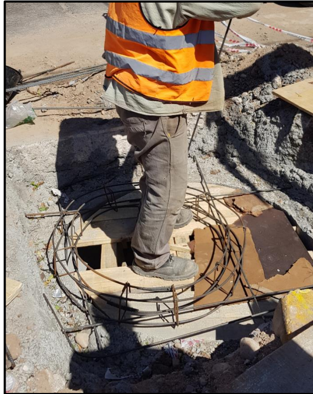
Figura 4.2.4.3 – Armadura losa de BR (Fuente: Elaboración propia)
