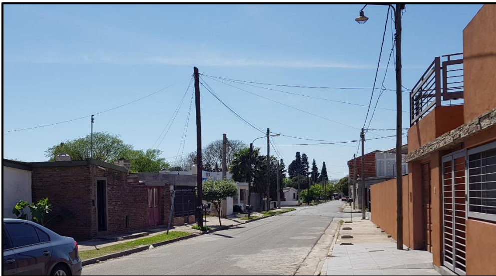
Figura 1.4.1.2.4 – Tendido eléctrico calle Astorga (límite sur del barrio) (Fuente: Elaboración propia)
