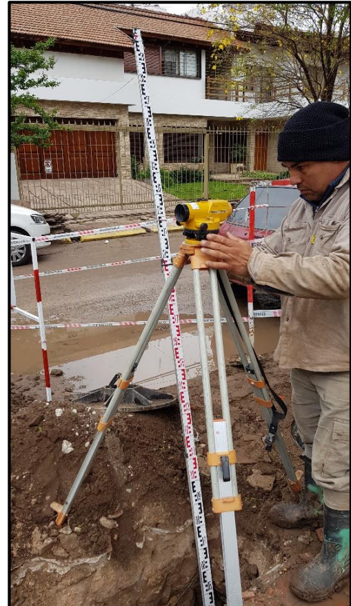
Figura 4.2.6.3 – Operario estacionando nivel topográfico (Fuente: Elaboración propia)
