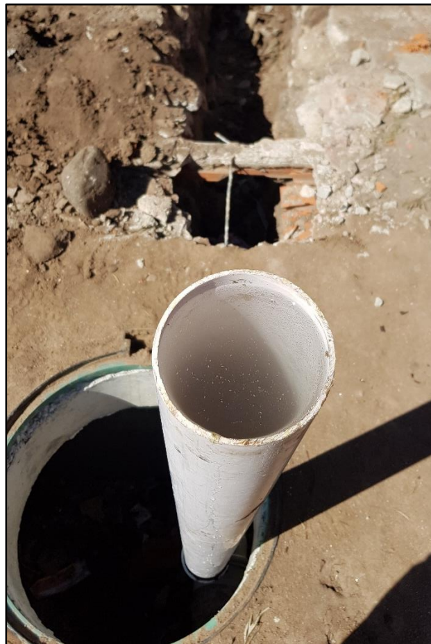
Figura 4.2.7.1 – Prueba hidráulica con 2 metros columna de agua de presión (Fuente: Elaboración propia)
