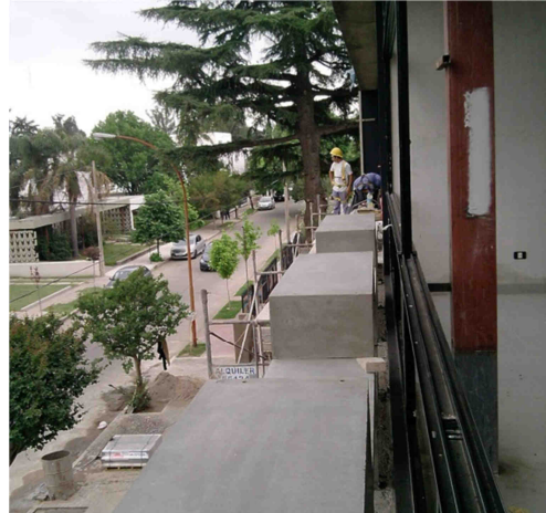
Figura 4 – Colocación de piezas HºP.
