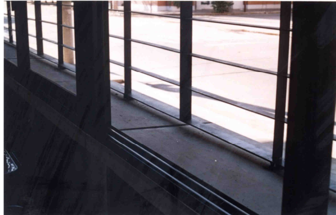
Figura 12 – Antepecho, disposición de la carpintería.
