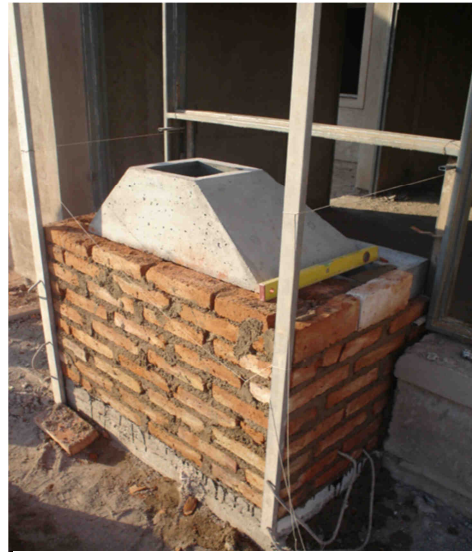
Figura 14 – Armado de estufas.
