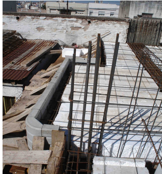
Figura 8 – Pieza como encofrado de losa.
