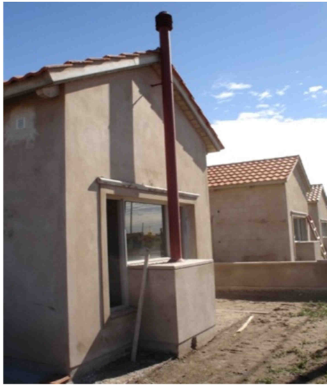
Figura 13 – Fachada vivienda Bº Smata.
