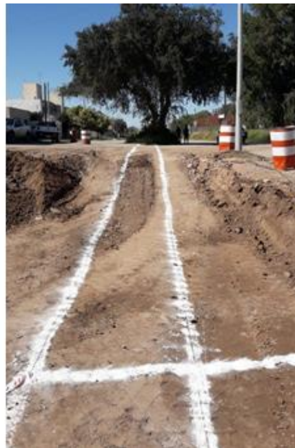
Figura 32: Replanteo cantero central en Tramo Noroeste – Empalme con Av Donato Alvarez y Calle J. Fangio.
