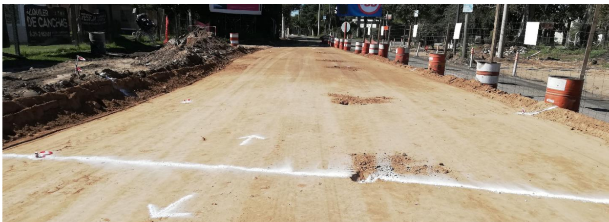
Figura 23: Replanteo cambio de pendiente longitudinal en ramal sureste entrante.
