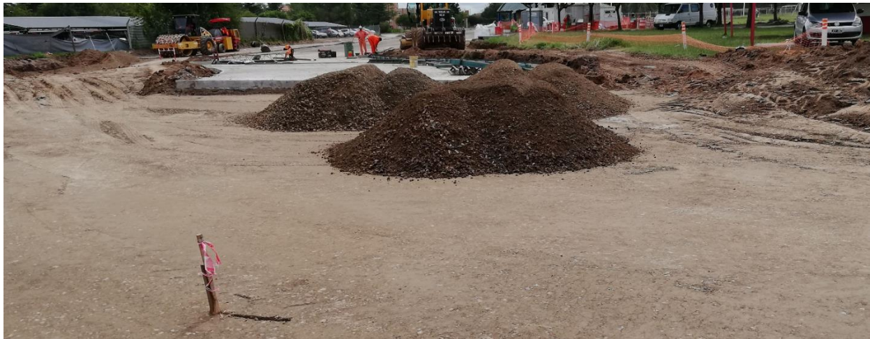
Figura 24: Estaca y material de carga en rotonda.
