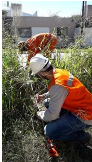
Figura 32: Replanteo cantero central en Tramo Noroeste – Empalme con Av Donato Alvarez y Calle J. Fangio.
