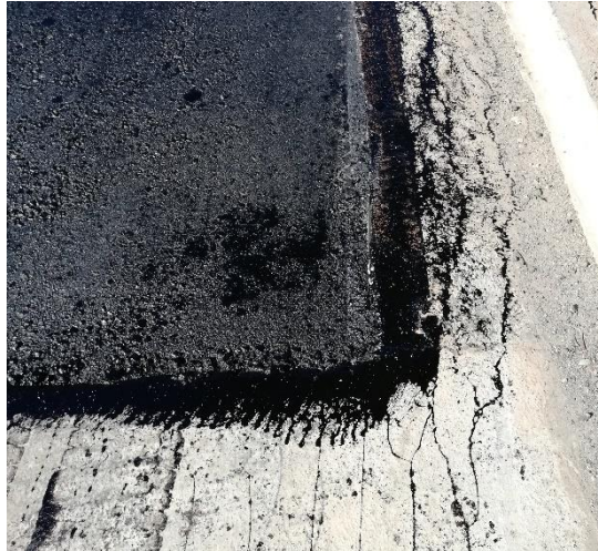
Figura 27: Verificación del vertido del riego de liga.
