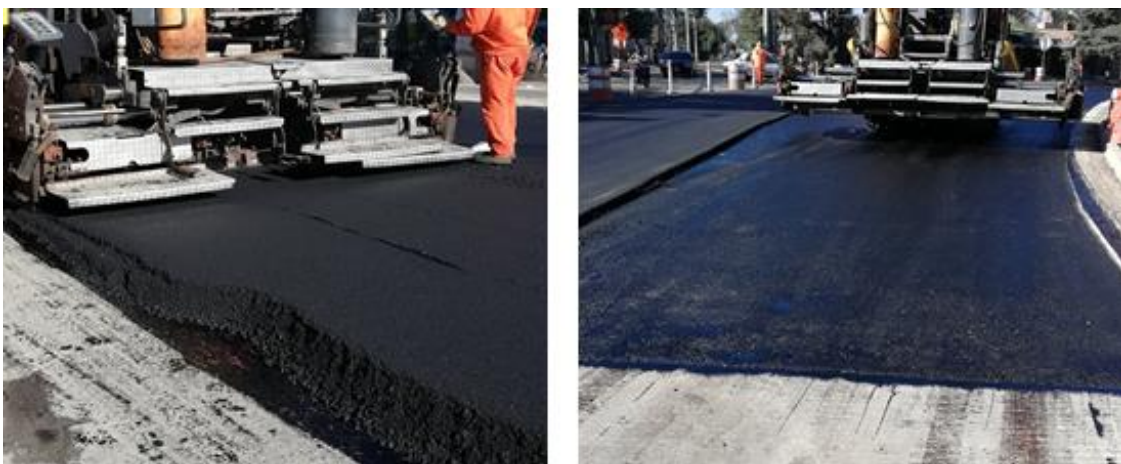
Figura 26:Primera y segunda capa de mezcla asfáltica.
