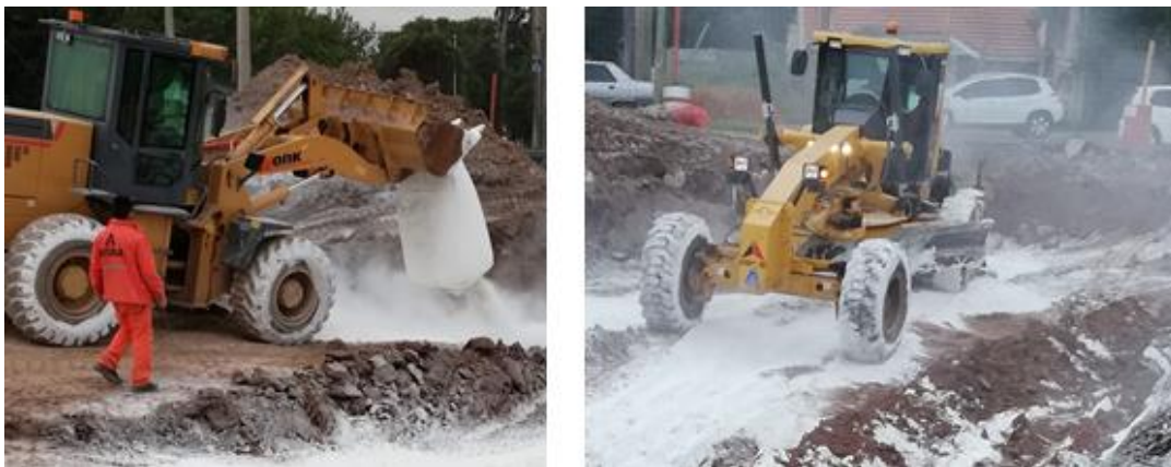
Figura 45: Distribución de cal para perder humedad en el suelo.
