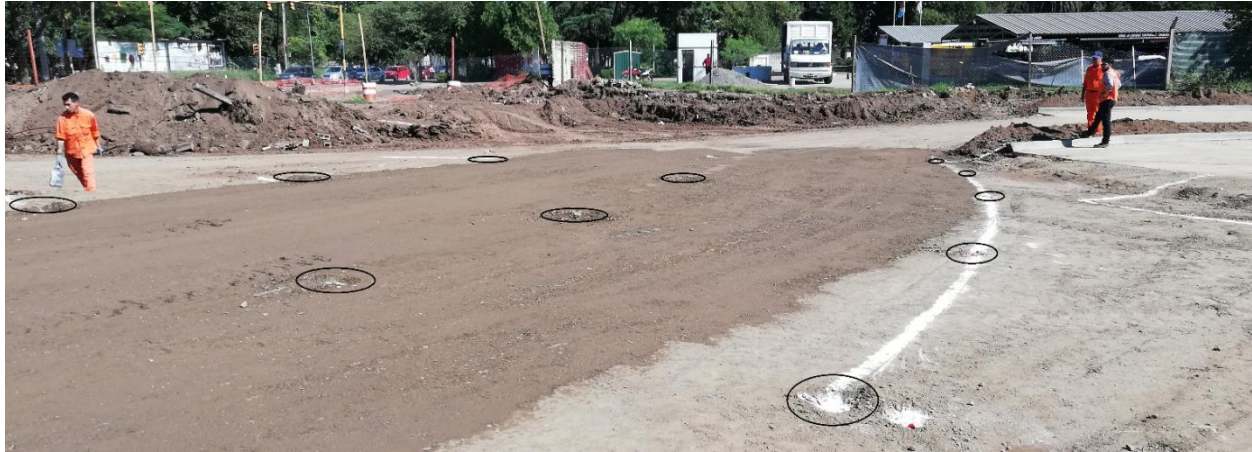
Figura 22: Replanteo del sector noreste de la rotonda.
