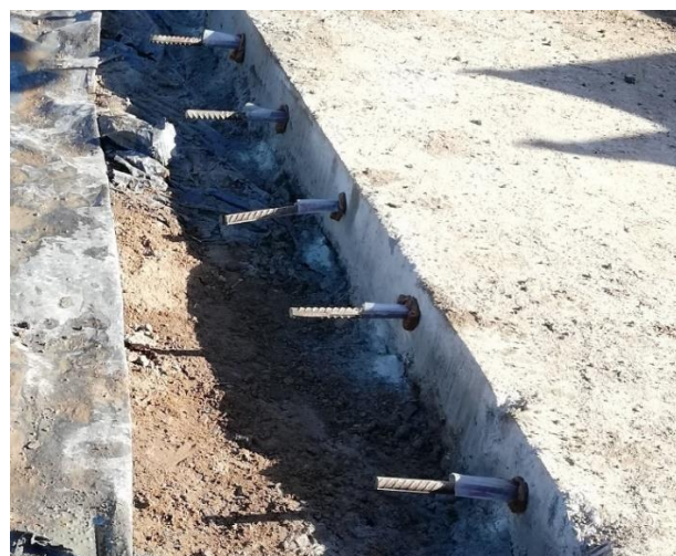
Figura 52: Pasadores de hierro en junta transversal.
