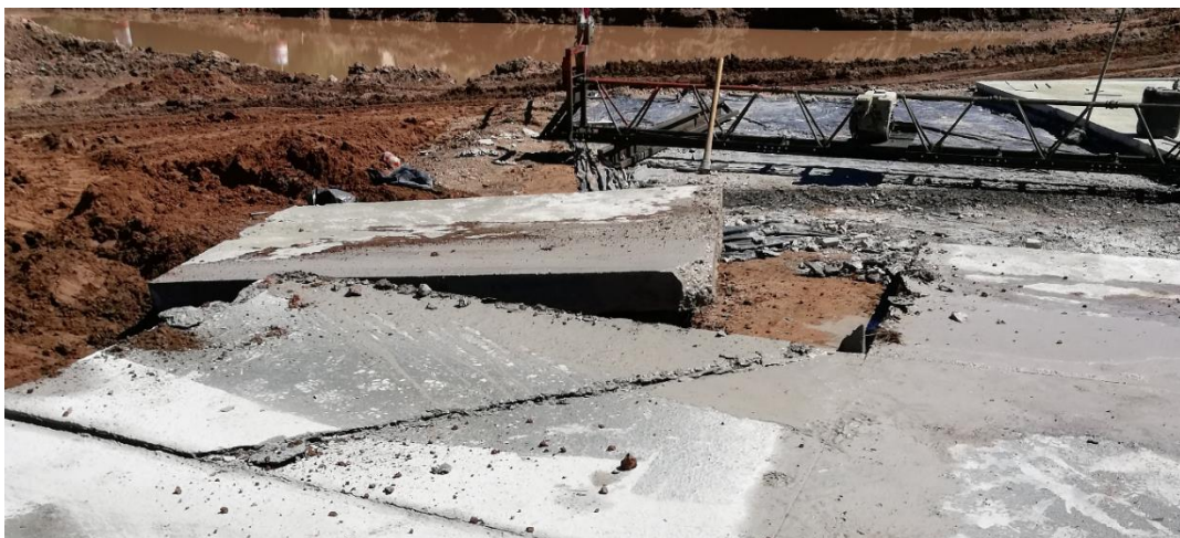
Figura 42: Demolición de losa completa por hormigonar con mal clima.
