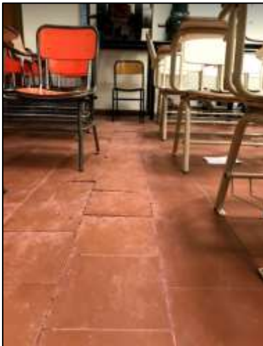
Fotografía 98. Corredor central del aula en donde la junta de los cerámicos se encuentra rota y se ha ido saltando.
