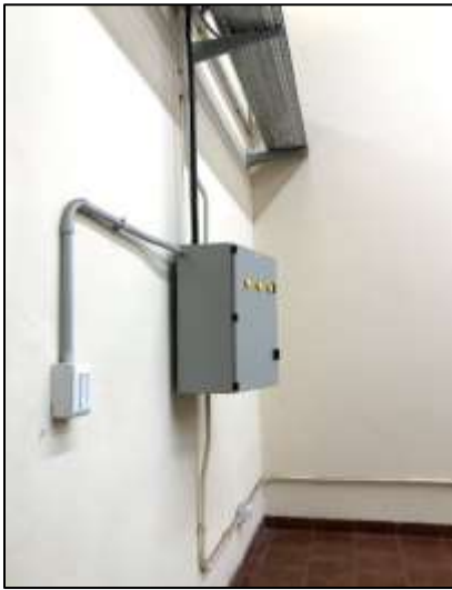
Fotografía 106. Instalación eléctrica nueva y vieja del local, utilizada para los elementos de climatización e iluminaria. Se presenta el tablero eléctrico y la bandeja metálica que lleva parte de las conexiones.
