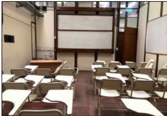
Fotografía 85. Vista desde el fondo del aula, en donde se ve el pasillo, los bancos dispuestos, el pizarrón, la puerta de ingreso y parte de la instalación eléctrica (nueva y antigua).
