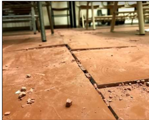
Fotografía 98. Corredor central del aula en donde la junta de los cerámicos se encuentra rota y se ha ido saltando.
