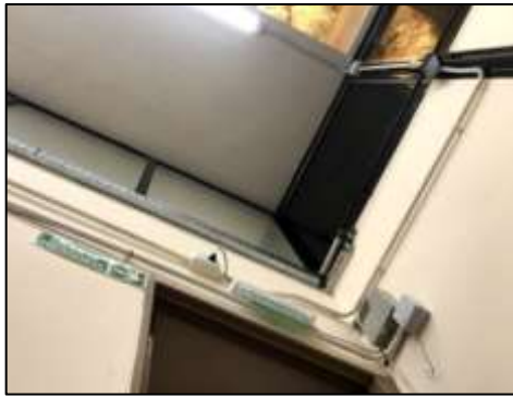
Fotografía 50. Se observa la instalación eléctrica nueva y vieja para los elementos de climatización del local y la iluminaria del mismo.
