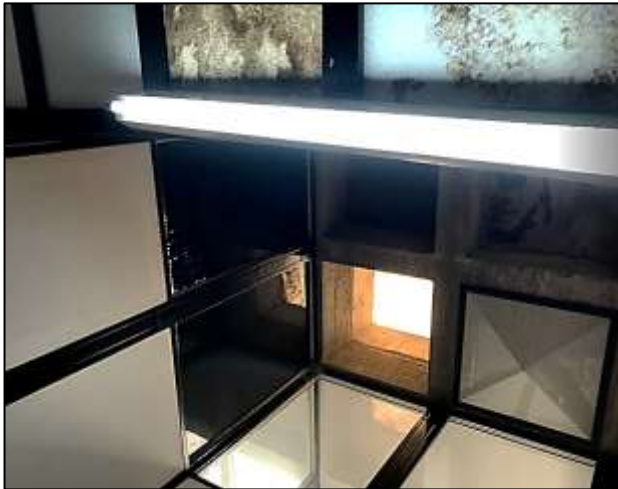
Fotografía 42. Iluminación natural y artificial del espacio, en donde se muestra el tragaluz y la única lámpara que se dispone en el local.
