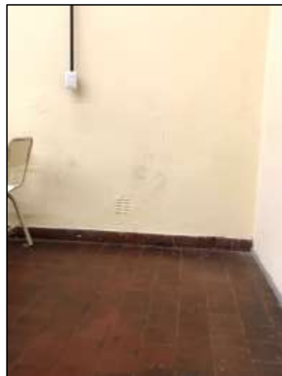
Fotografía 82. Se muestran los medios de ventilación del aula, el conducto de ventilación, las rejillas y como las mismas están colocadas en paredes paralelas, una en la parte superior y otra en la inferior.
