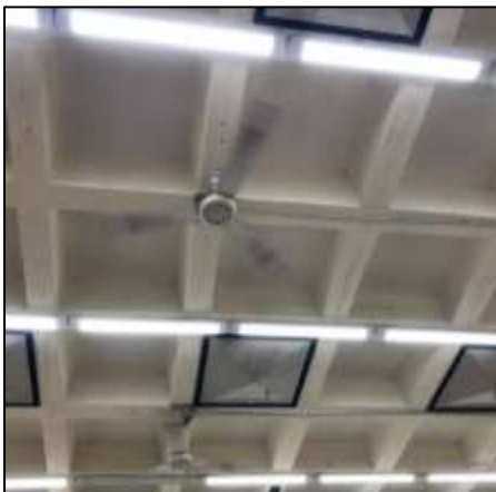
Fotografía 77. Luces led y medio de acondicionamiento del aula, los cuales ya tienen su velocidad de funcionamiento determinada.
