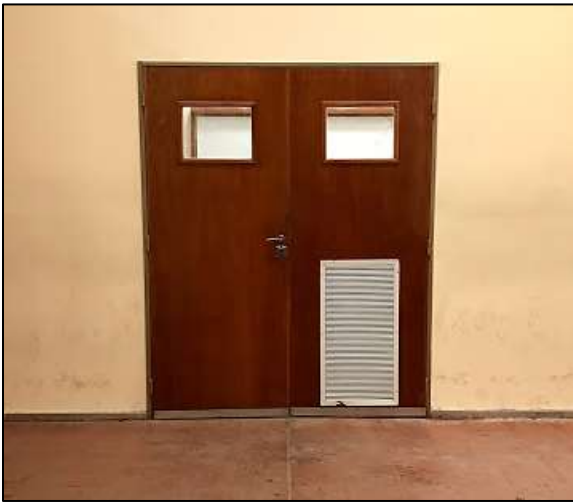
Fotografía 69. Puerta de ingreso del aula 103, la cual posee una rejilla de ventilación en la parte inferior.
