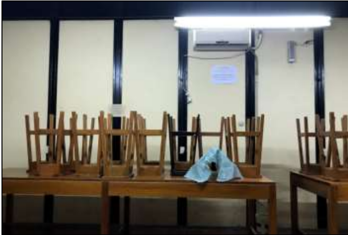
Fotografía 44. Disposición de mesas, bancos, aires acondicionados, instalación eléctrica y sistema de iluminación artificial (lámpara de tubos) además de la luz de emergencia del aula.
