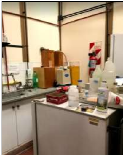
Fotografía 60. Ambas imágenes son tomadas de la parte del local que se ha creado en uno de los costados del laboratorio. En ellas se quiere presentar el estado de las bachas con sus respectivas griferías, las cuales se utilizan como medio de apoyo. Actualmente debido a la falta de espacio, ambas está bastante desordenadas y desorganizadas.
