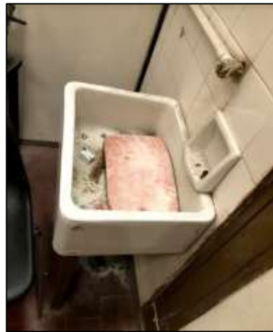
Fotografía 97. Esquina del salón, en donde se muestra la bacha a la cual se le retiro la canilla que poseía, dejándose el trabajo sin terminar y generando con ello que lavado quede sin uso alguno.
