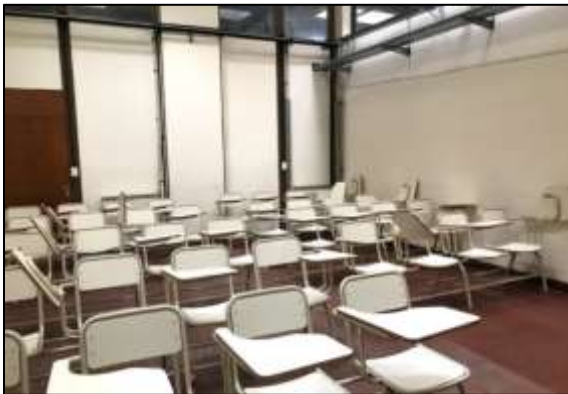
Fotografía 84. Disposición de los bancos, donde se observa parte de la instalación eléctrica, la bandeja, los paños fijos y la puerta que lo une con la sala de cómputos.
