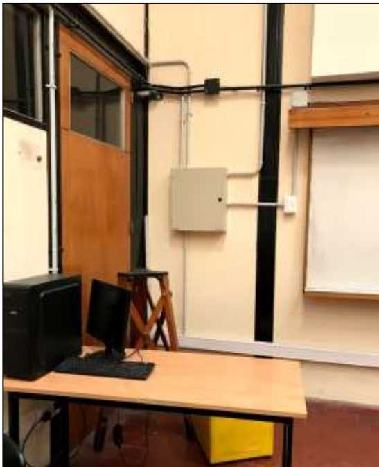
Fotografía 22. Instalación eléctrica, en donde se diferencia entre la parte nueva y la que tiene ya sus años, se puede observar claramente la diferencia de los materiales empleados (parte nueva en color gris y la parte vieja en color negro).
