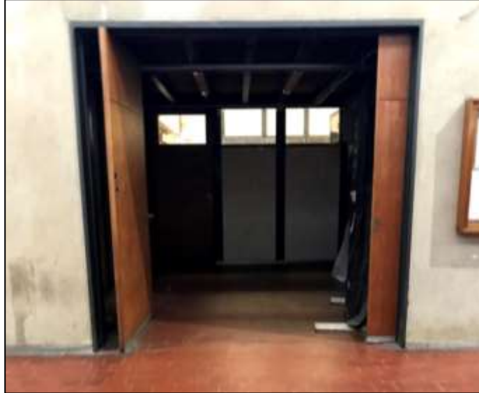
Fotografía 3. Pasillo secundario 3, en donde se puede ver los elementos que lo forman.
