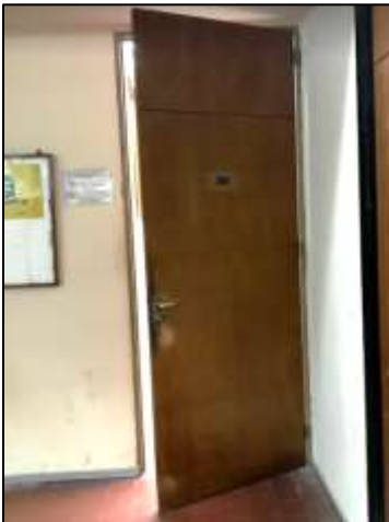
Fotografía 55. Puerta de madera de ingreso al laboratorio.
