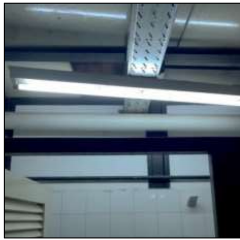
Fotografía 18. Estado del techo desde donde se puede apreciar los listones de madera del piso superior, además de las placas de telgopor.
