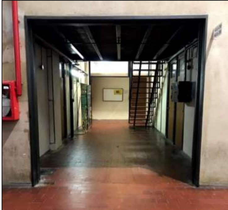
Fotografía 5: Pasillo secundario 4, en donde se presentan los elementos que lo establecen.
