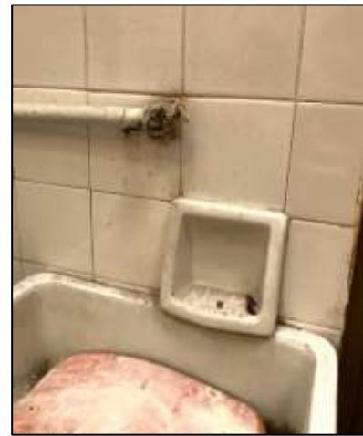
Fotografía 97. Esquina del salón, en donde se muestra la bacha a la cual se le retiro la canilla que poseía, dejándose el trabajo sin terminar y generando con ello que lavado quede sin uso alguno.
