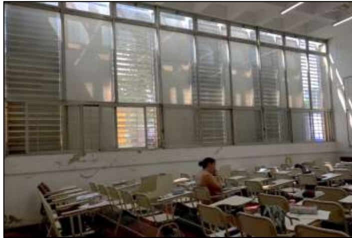
Fotografía 7. Distribución de los bancos, presencia de ventanas en la pared lateral y su protección correspondiente constituida por paneles y parasoles (las cuales actualmente están trabadas).
