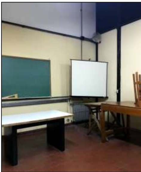
Fotografía 43. Una de las esquinas del gabinete en donde se observan dos de los medios de refrigeración (ventilador y radiador), además del pizarrón, el lugar de proyección y parte de la conexión eléctrica.
