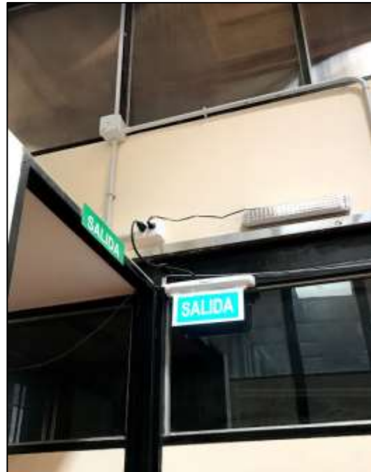
Fotografía 22. Instalación eléctrica, en donde se diferencia entre la parte nueva y la que tiene ya sus años, se puede observar claramente la diferencia de los materiales empleados (parte nueva en color gris y la parte vieja en color negro).
