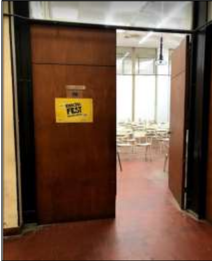
Fotografía 25. Puerta de ingreso de madera del aula, la cual posee paño fijo en la parte superior, además se puede ver los paños fijos en la parte superior de las paredes que rodean totalmente el aula.
