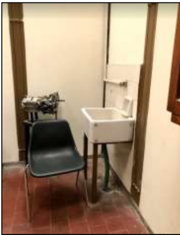
Fotografía 97. Esquina del salón, en donde se muestra la bacha a la cual se le retiro la canilla que poseía, dejándose el trabajo sin terminar y generando con ello que lavado quede sin uso alguno.
