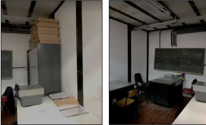
Fotografía 39. Disposición de los elementos, para poder aprovechar al máximo el espacio disponible. A su vez se pueden ver las conexiones eléctricas y la iluminación artificial.
