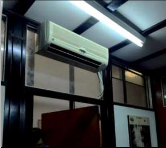
Fotografía 14. Puerta de acceso a la AEDA desde la Secretaría, donde se puede advertir el aire acondicionado convencional descrito anteriormente.
