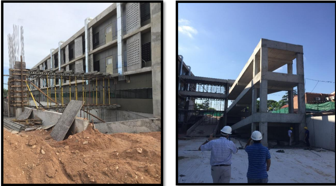
Figura N°22. Fotografías de la rampa peatonal. Armado de Ménsula. Armado de tramos inclinados y pasarelas
