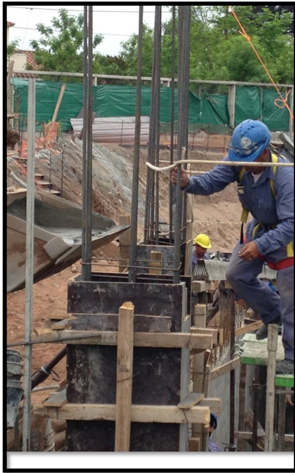
Figura N°16. Encofrado de columna
