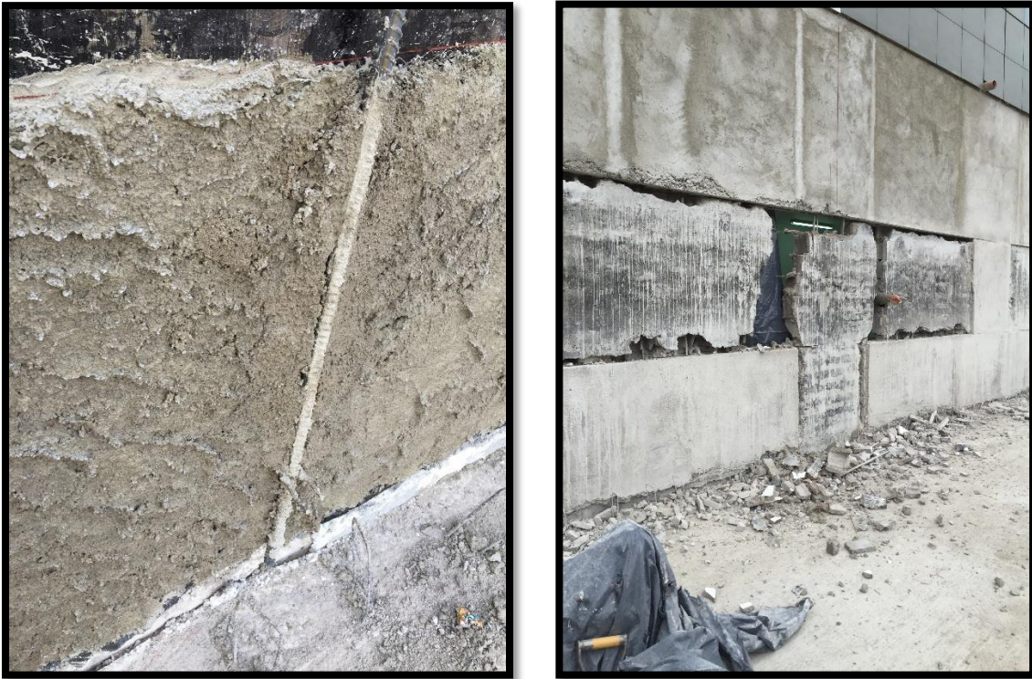
Figura N°24. Revoque grueso y apertura de vanos en edificio existente
