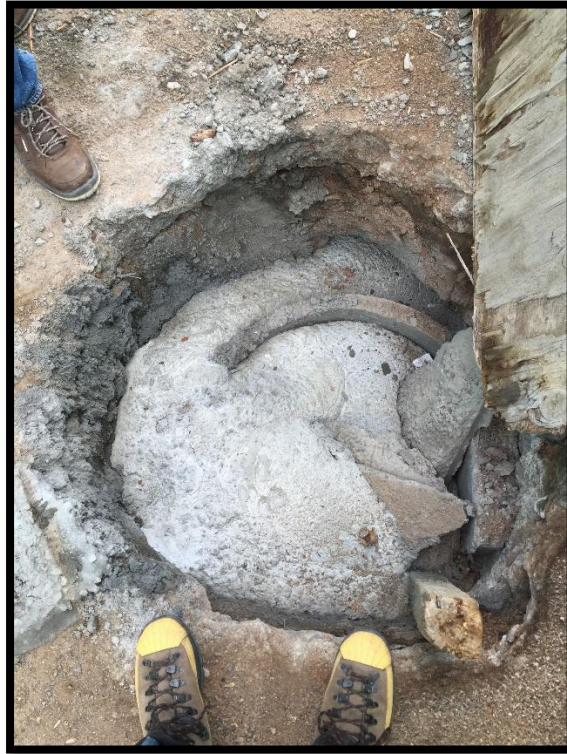
Figura N°12. Pozo sobre vereda ya hormigonado
