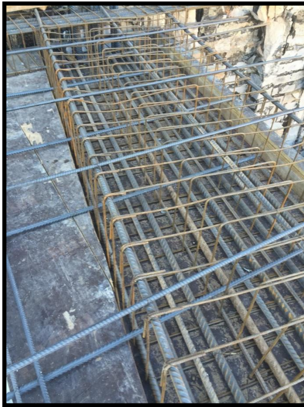
Figura N°18. Viga en etapa de encofrado y armado. Armadura de viga y encuentro con nervios de la losa adyacente
