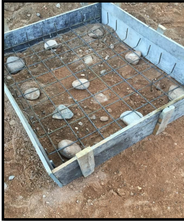
Figura N°7. Encofrado de base centrada, con su respectiva armadura
