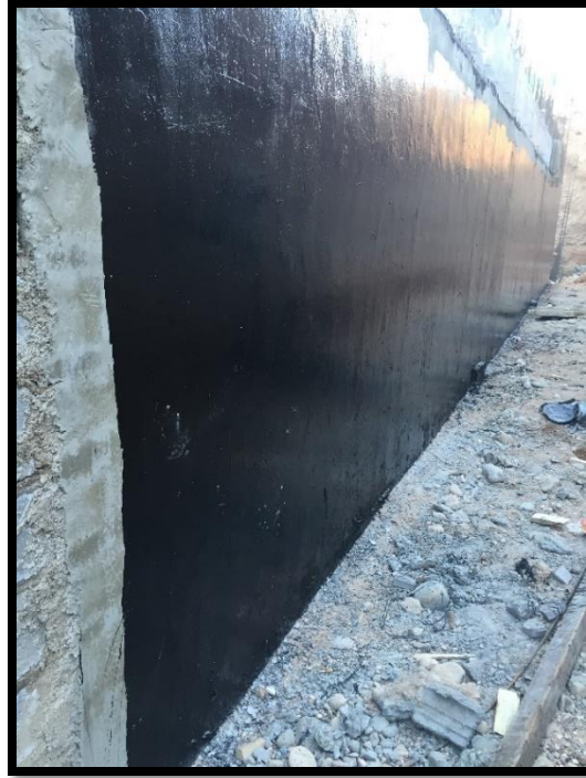
Figura N°10. Muro de mampostería armada, con su impermeabilización de pintura asfáltica
