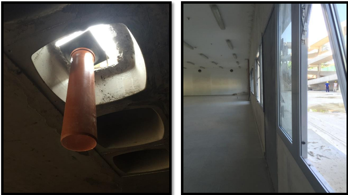
Figura N°25. Embudo colocado en losa de primer subsuelo. Aberturas de aluminio sobre muro existente
