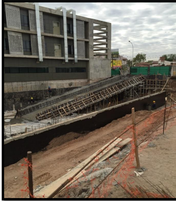
Figura N°20. Rampa vehicular de ingreso
