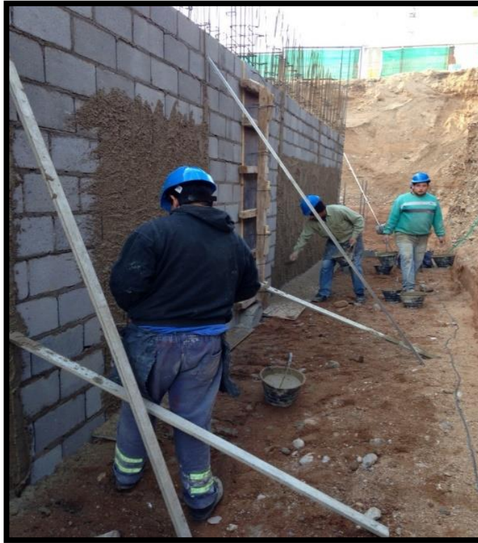
Figura N°8. Muro de mampostería armada
