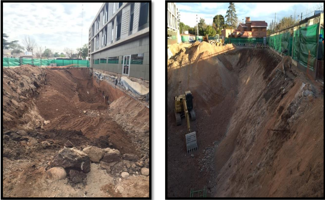
Figura N°5. Excavación del pozo, desde Avenida Laplace y Calle Blas Pascal
