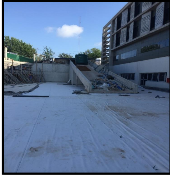
Figura N°20. Rampa vehicular de egreso
