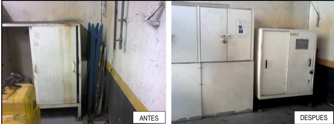
Eliminación de armario degradado de artículos de limpieza y traslado de en desuso.
