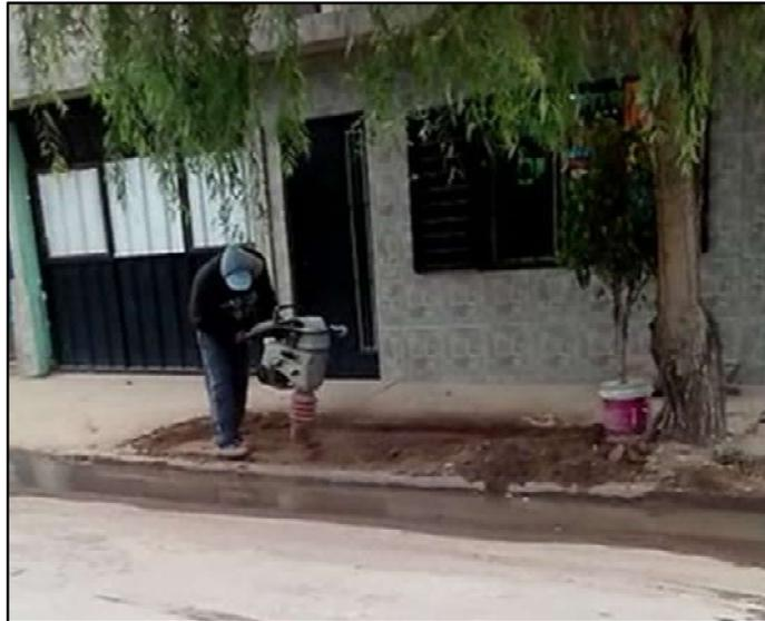
**Figura 47** - Operario compactando mediante el uso de un motopisón, para la posterior reposición de vereda.
