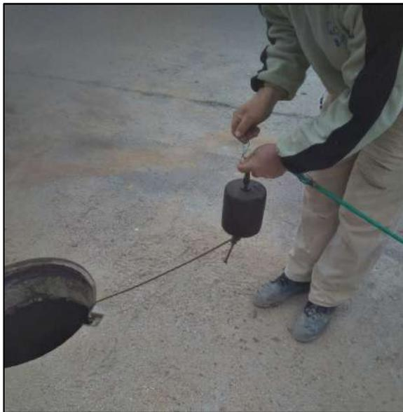
**Figura 45** – Foto tomada a tapón que permite verificar la desobstrucción de la cañería.
