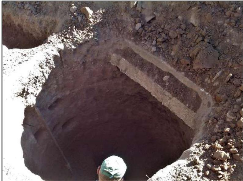
**Figura 32** – Foto tomada durante la excavación de boca de registro bajo cordón cuneta.
