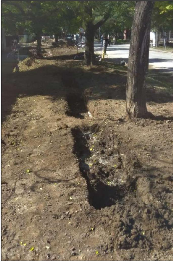
Zanja tapada sin pruebas de la inspección aun realizadas. Para evitar accidentes, daños y/o movimientos en la cañería durante el fin de semana, se procedió al relleno de la misma sin la culminación de la tarea en su totalidad, a la espera de la realización de las pruebas faltantes y la aprobación del tramo.
