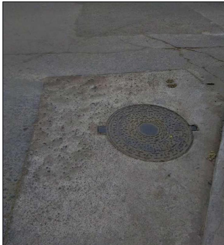
**Figura 49** – Foto tomada a reposición de pavimento deficiente.
