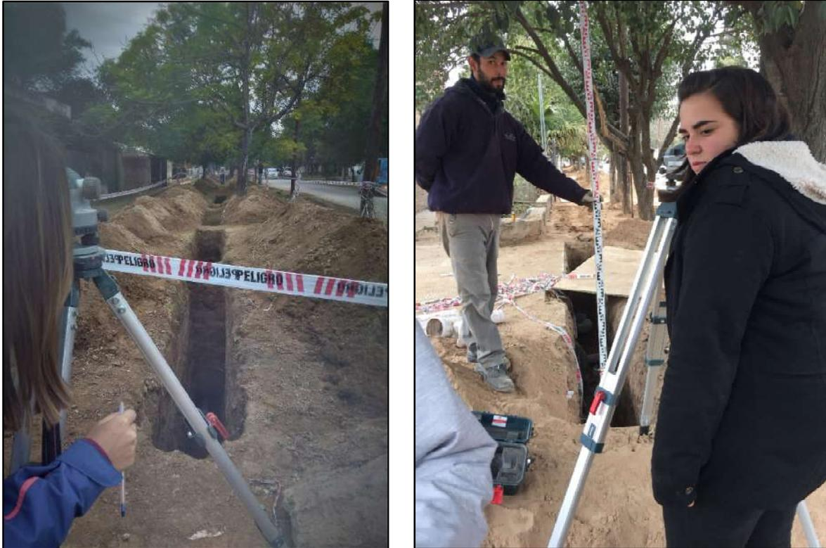
**Figura 42** – Mediante el uso de nivel óptico y regla, se mide el desnivel y longitud del tramo para obtener la pendiente del tramo a verificar.
