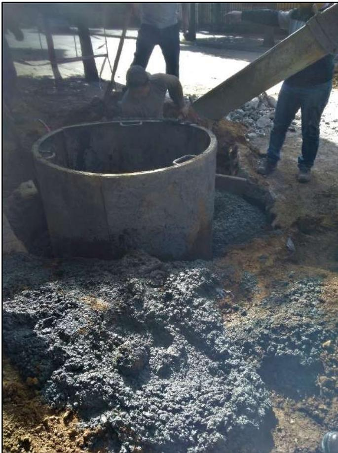
Hormigonado de boca de registro. Se observa falta de limpieza de la zona de hormigonado y falta de elementos de protección personal de los operarios. No se realizaron las pruebas sobre el hormigón elaborado entregado.
