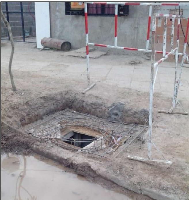
**Figura 39** – Foto tomada a armadura de losa de cierre de boca de registro.
