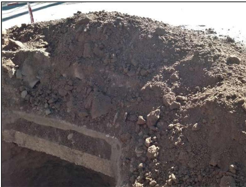
**Figura 35** – Foto tomada a situación de peligro en obra debido al acopio de material en las proximidades de la excavación.
