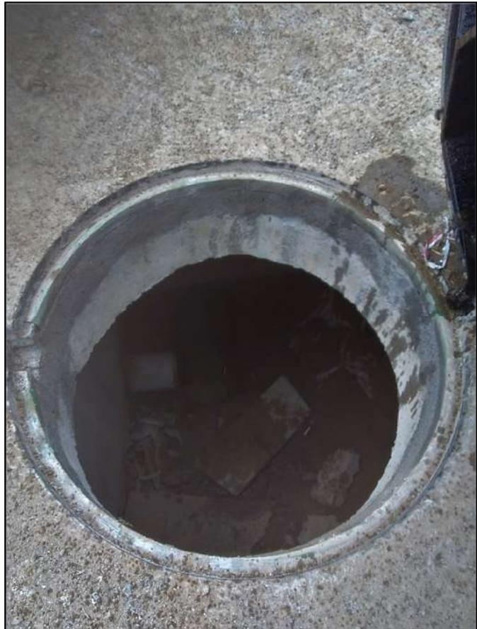
**Figura 40** – Foto tomada a boca de registro, donde se observa que no se completó la realización de cojinetes y detalles.
