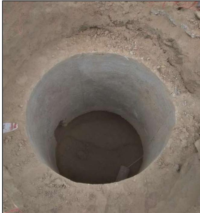
**Figura 38** – Foto tomada a boca de registro hormigonada sin terminar tapa ni detalles.
