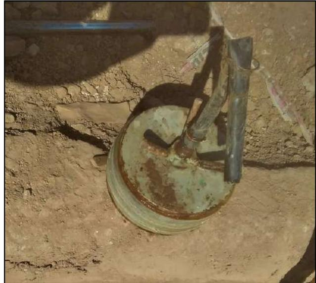
**Figura 43** – Foto tomada a tapón de cañería para prueba hidráulica.
