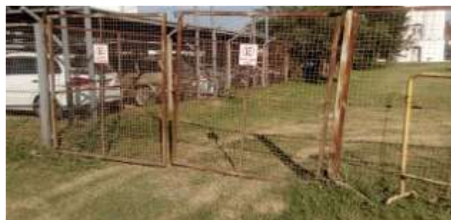
Figura 10 – Portón ingreso vehicular a FCA. Fuente: Fotografía.
