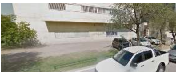
Figura 46 – Playa de estacionamiento Facultad de Artes. Fuente: Fotografía.
