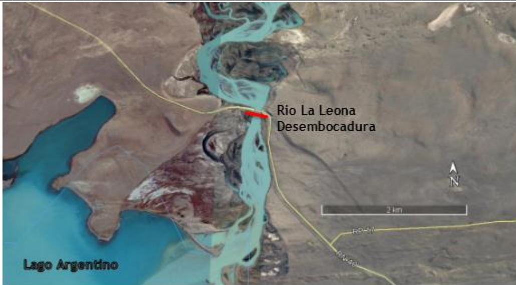
Figura 11.- Sección de medición del río La Leona, aguas abajo en la desembocadura
