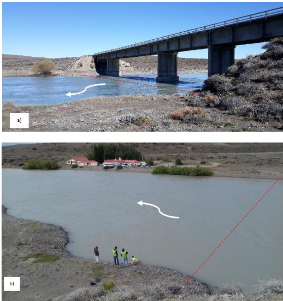
Figura 10.- Sección de medición La Leona Norte, aguas arriba. (a) Vista desde la margen izquierda, octubre 2018- Campaña 1. (b) Vista desde el puente hacia aguas abajo, diciembre 2018 - Campaña 3.
