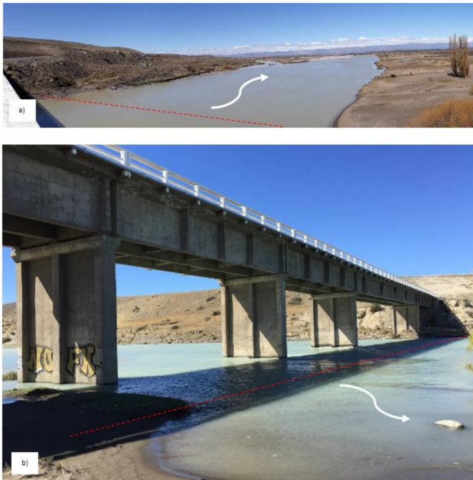
Figura 12.- Sección de medición La Leona Sur. (a) Vista desde el puente hacia aguas abajo, octubre 2018- Campaña 1. (b) Vista desde margen derecha, febrero 2018 - Campaña 5.
