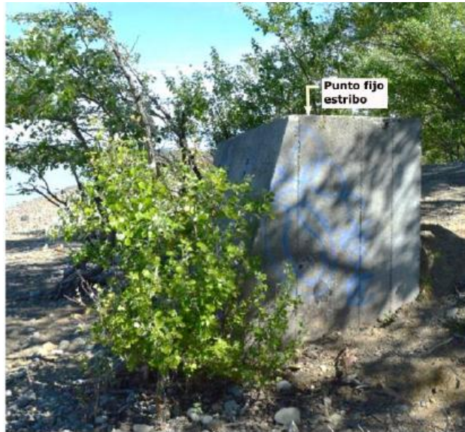
Figura 62.- Referencia de altura tomada en el río Santa Cruz, sección Puente Viejo.
