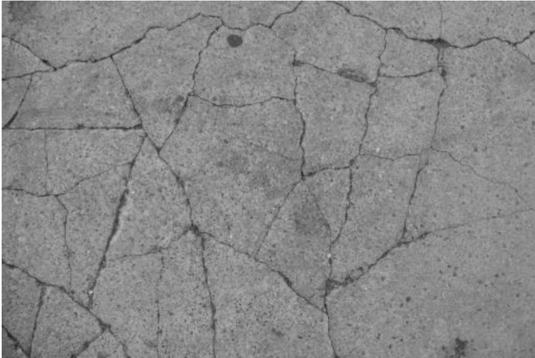
Figura 4.35. Fisuras por contracción plástica
