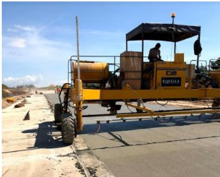
Figura 4.19. Equipo de Aspersion de Antisol
