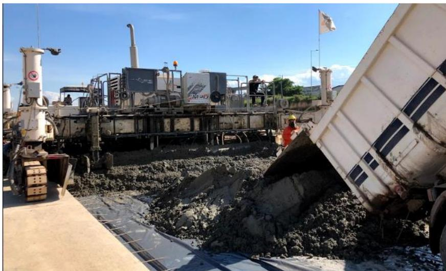
Figura 4.8. Hormigón siendo colado frente a terminadora
