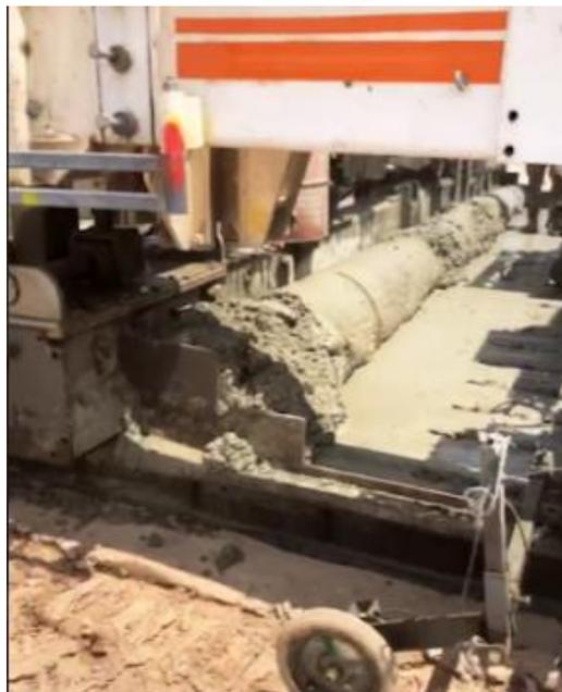
Figura 4.14. Tramper o Viga oscilante
