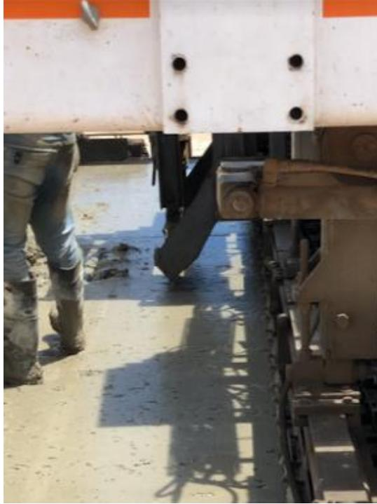
Figura 4.17. Inserter Automático de Barras
