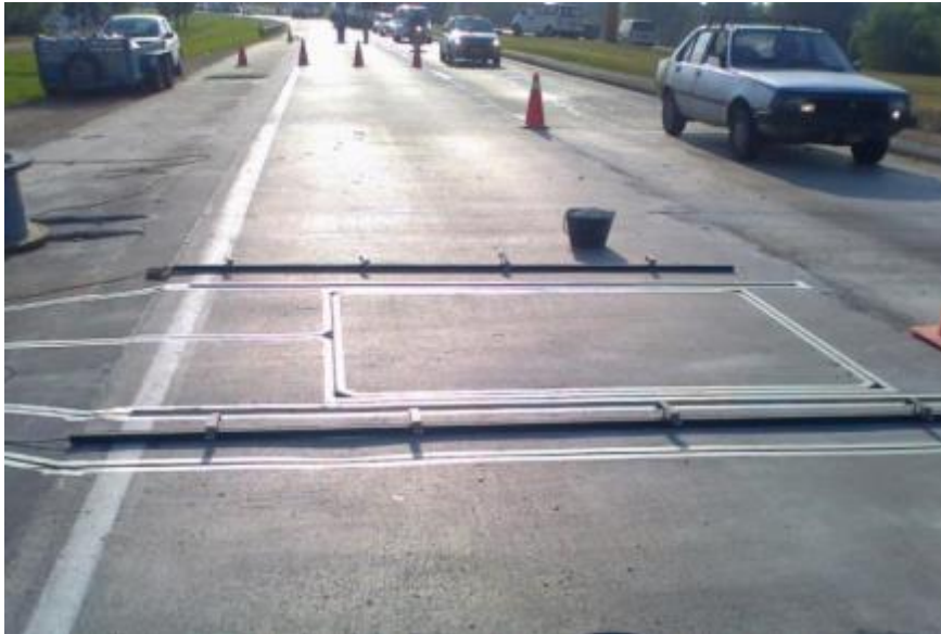
Figura 6-8 – Instalación del Puesto Permanente PP91
