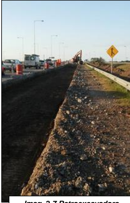
Imag. 2-7 Retroexcavadora realizando trabajo de excavación
