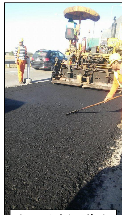
Imag. 2-15 Colocación de base asfáltica
