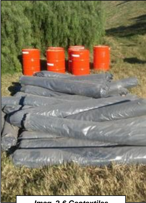
Imag. 2-6 Geotextiles previo a su colocación
