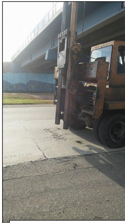
Imag. 2-4 Maquina realizando trabajos de demolición
