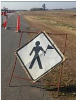
Imag. 2-34 Señal de Presencia de Barandillero
