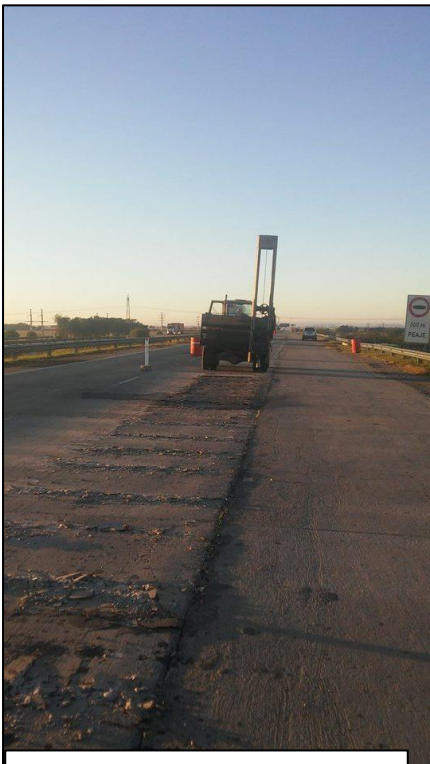
Imag. 2-3 Maquina realizando trabajos de demolición
