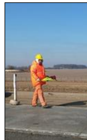
Imag. 2-36 Señal de Presencia de Barandillero
