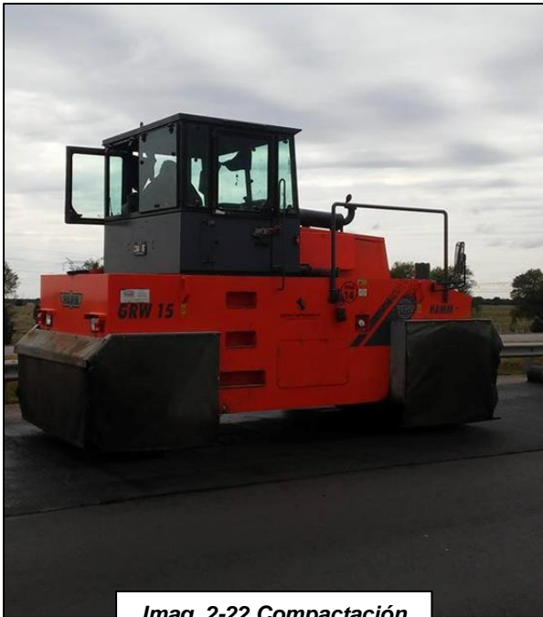
Imag. 2-22 Compactación de base asfáltica
