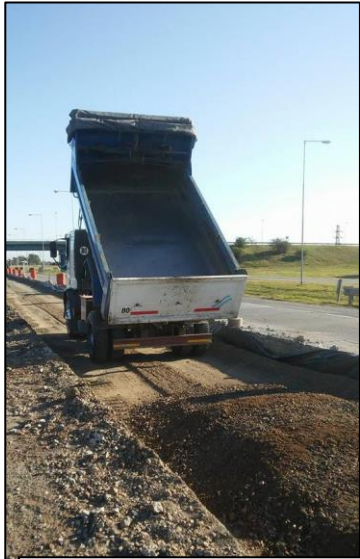
Imag. 2-10 Colocación de la base
