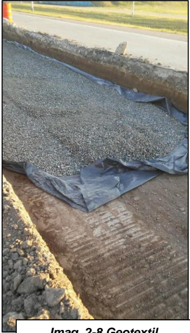
Imag. 2-8 Geotextil colocado
