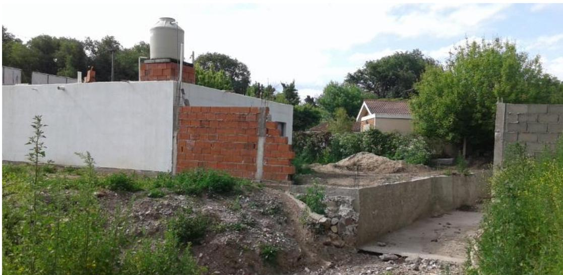
**Figura 1.2-2:** Rotura de Medianera
