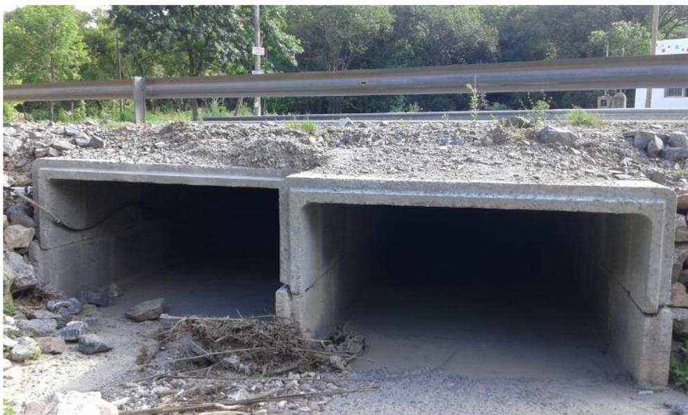
**Figura 1.2-4:** Alcantarilla reconstruida después de la crecida
