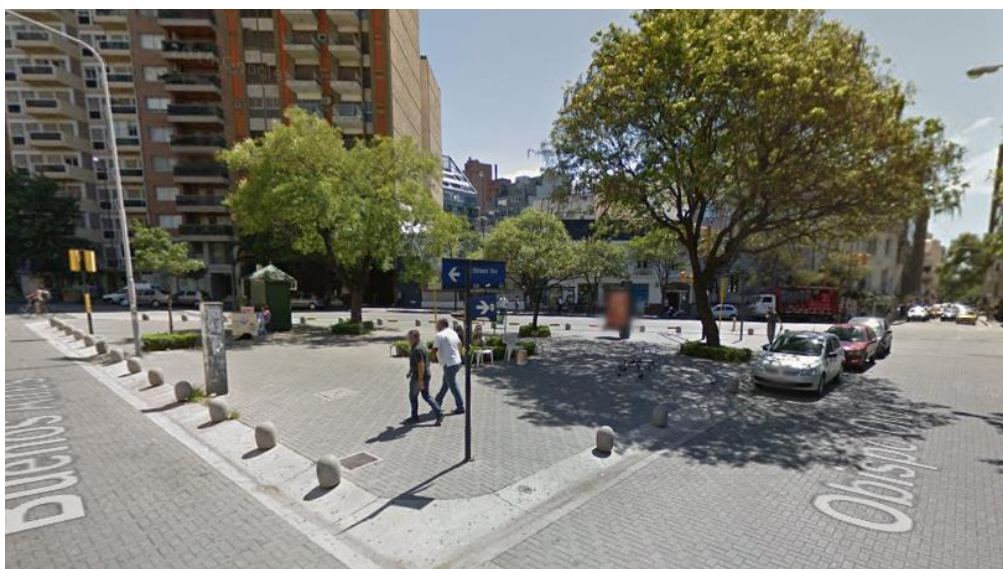
Figura 3.3: Ejemplo de pavimento de adoquines en Córdoba: plaza y calles frente a Iglesia del Sagrado Corazón
