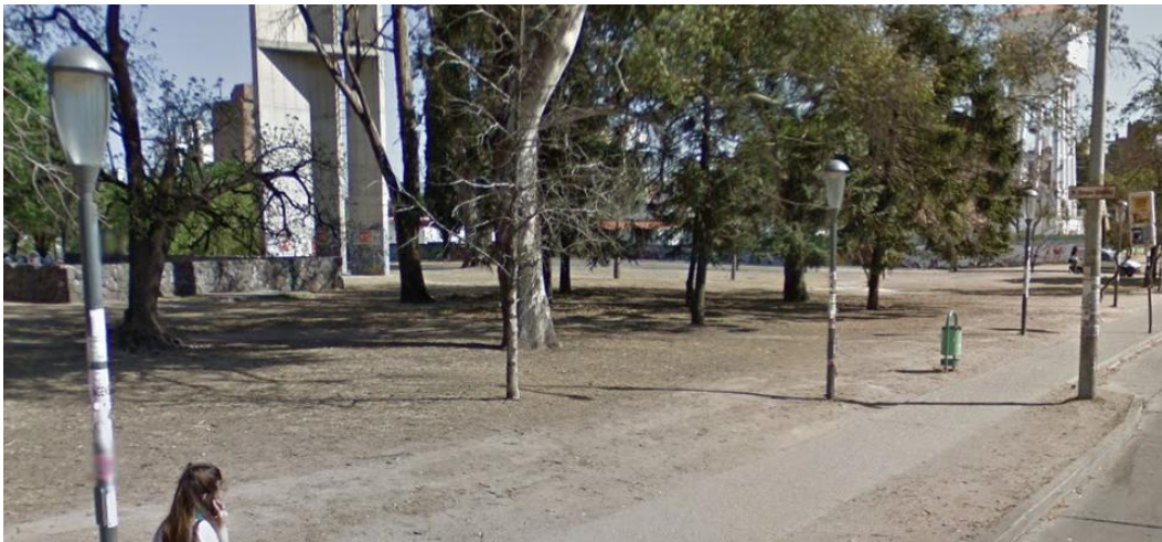
Figura 3.14: Luminarias existentes en Av. Enrique Barros, distanciadas 10 metros aproximadamente
