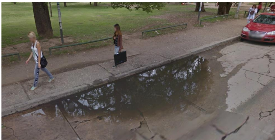
Figura 5.7: Losas hundidas que producen encharcamientos
