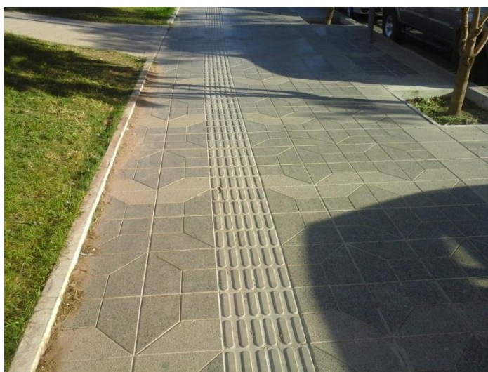
Figura 5.23: Vereda de Losetas de Hormigón con banda guía y borde de Hormigón Prefabricado (Parque Las Tejas)
