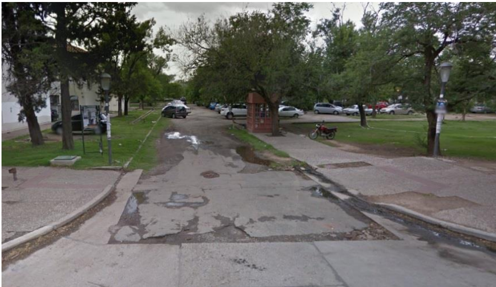
Figura 5.16: Vista actual de la tercera bocacalle
