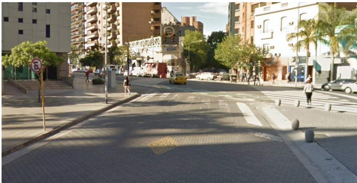
Figura 4.2: Pavimento Intertrabado de Adoquines de Hormigón en Córdoba: Paseo del Buen Pastor
