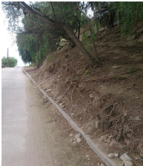
Figura 3.3: Talud existente sobre calle Nicasio.
