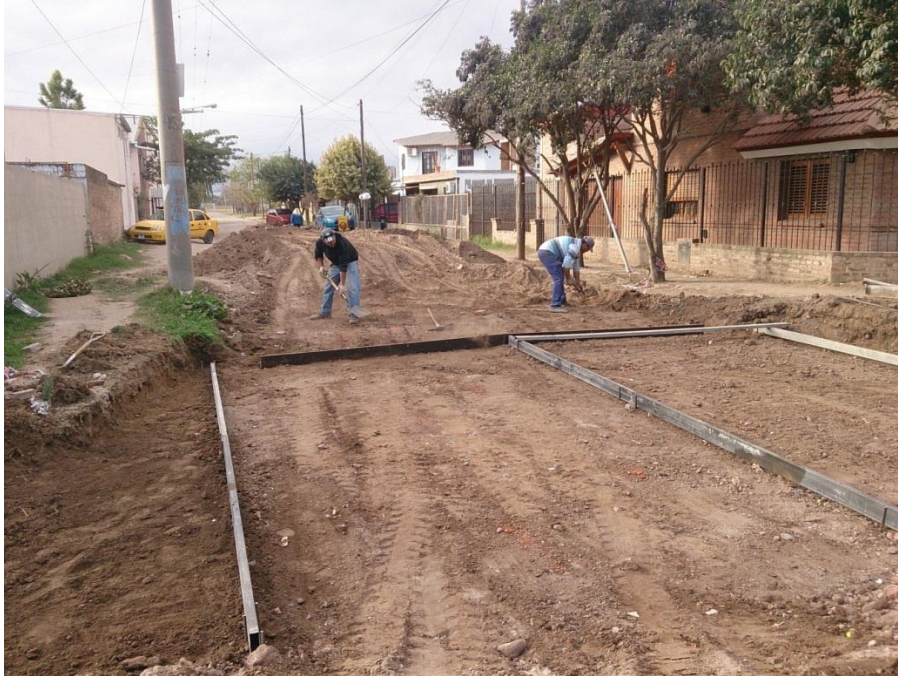
Figura 3.6: Preparación de subrasante para ejecución de badén.
