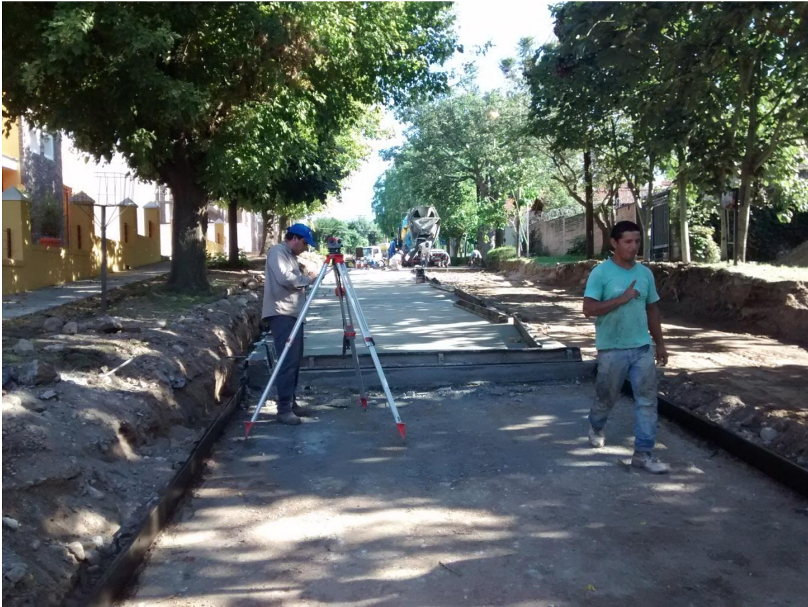
Figura 4.2: Nivelación con nivel óptico.
