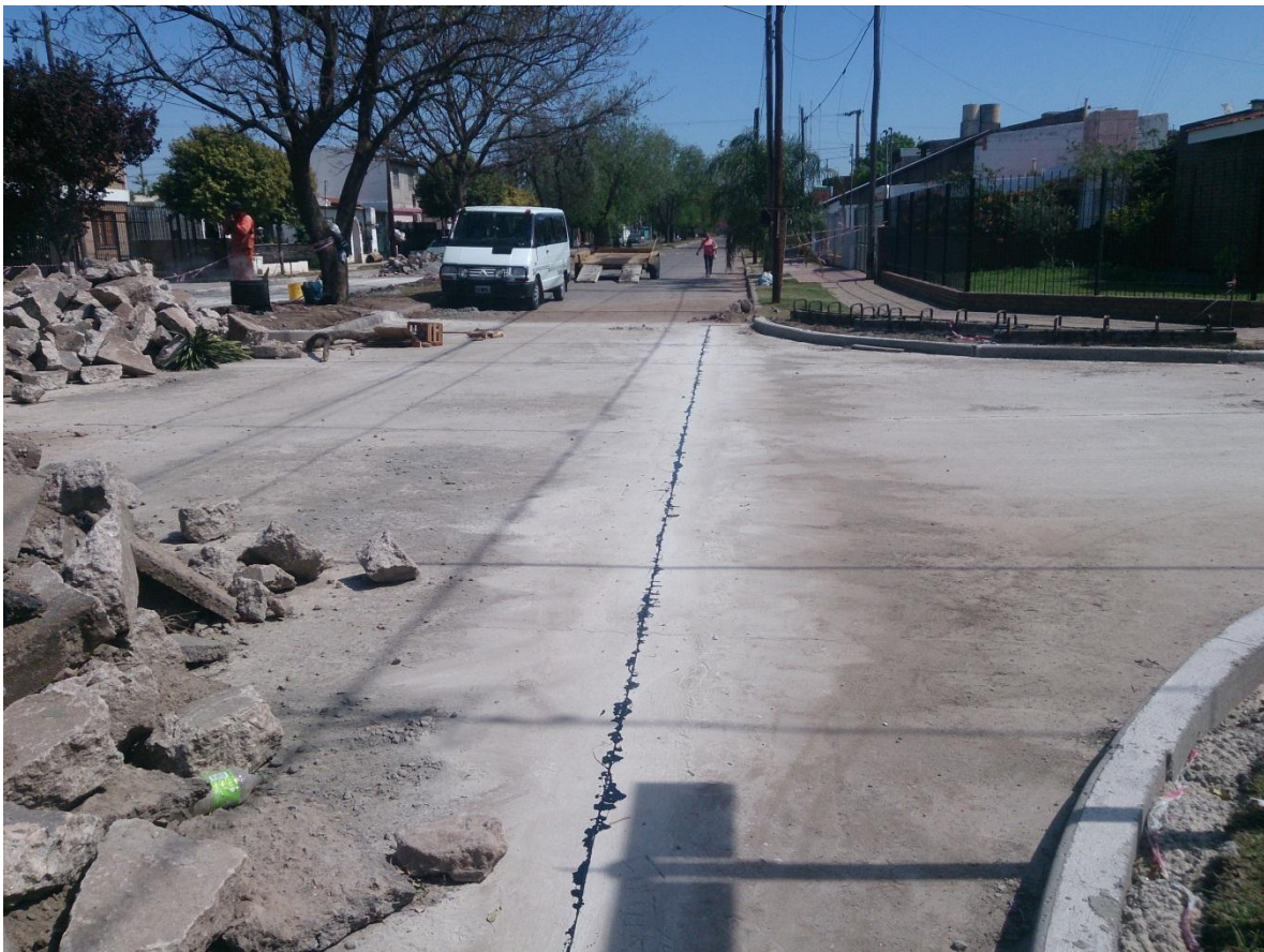
Figura 4.13: Tomado de juntas.
