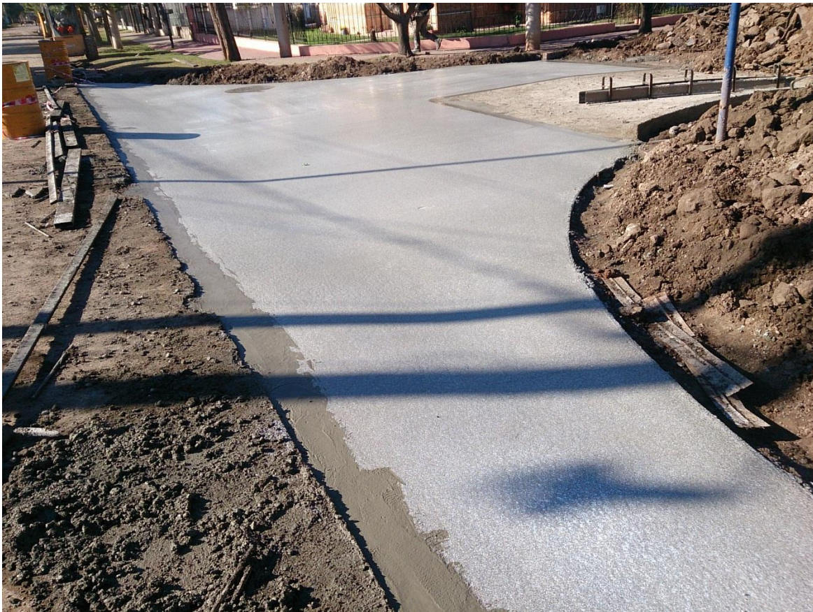
Figura 4.14: Badén con aplicación de Antisol.
