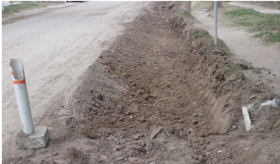
Figura 4.3: Apertura de cajón para ejecución de cordón cuneta.
