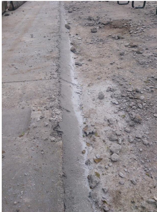
Figura 2.10: Nivel de la cuneta sobre calle Alberto Mascias.
