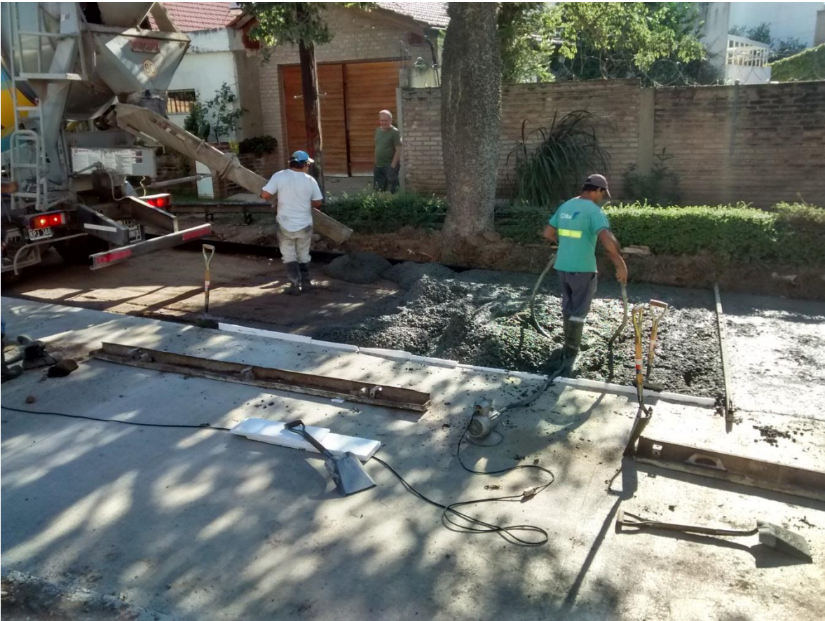
Figura 4.10: Vibrado de hormigón con vibrador monofásico de tipo aguja.
