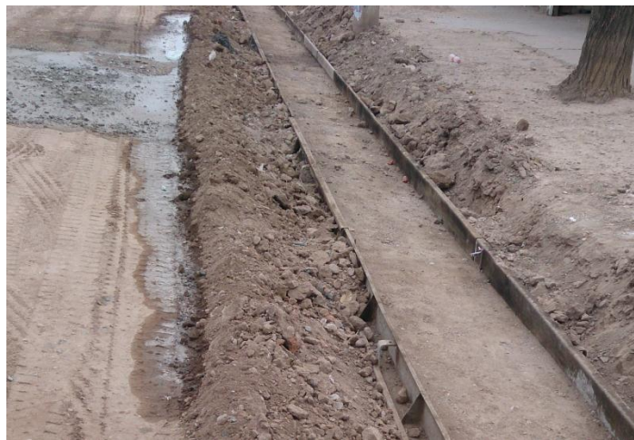
Figura 4.8: Preparación de subrasante.
