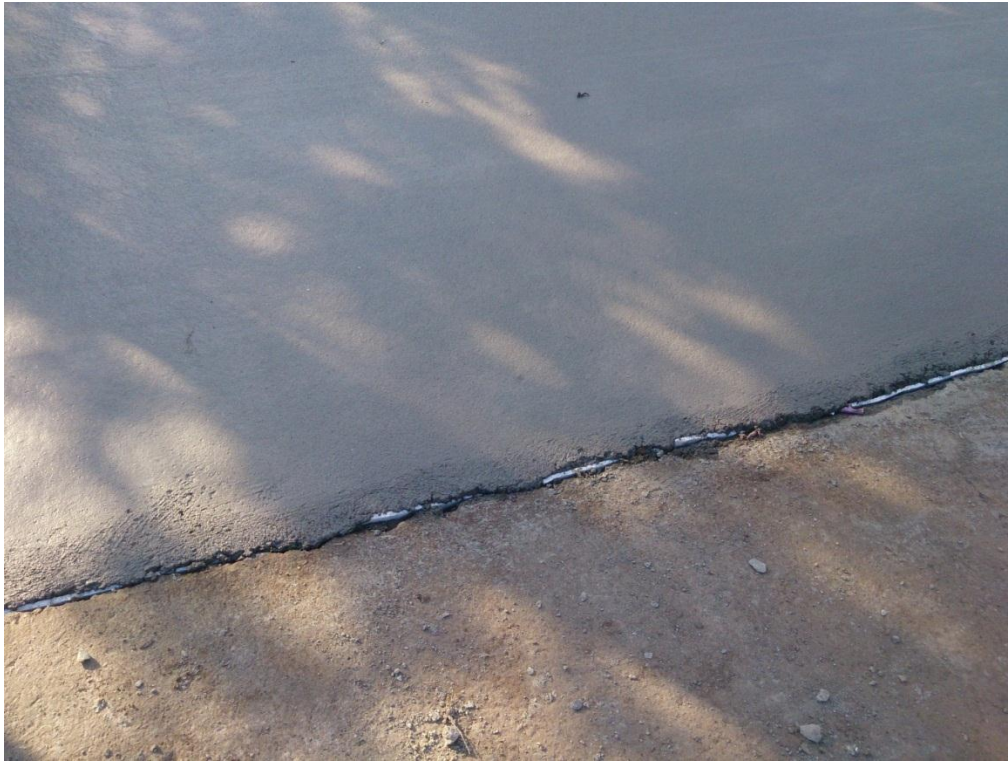
Figura 4.11: Junta de dilatación.
