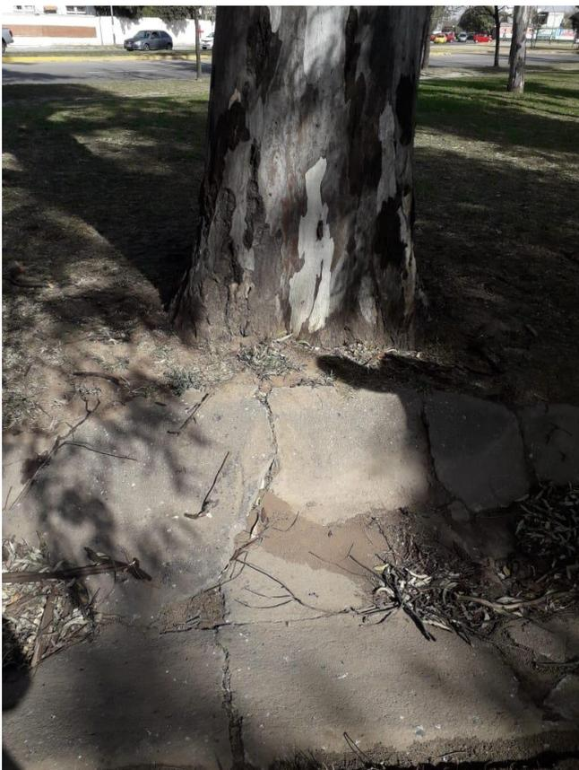
**Figura 17. Acequia fisurada a partir del crecimiento radicular del árbol colindante. Fotografía propia.**
