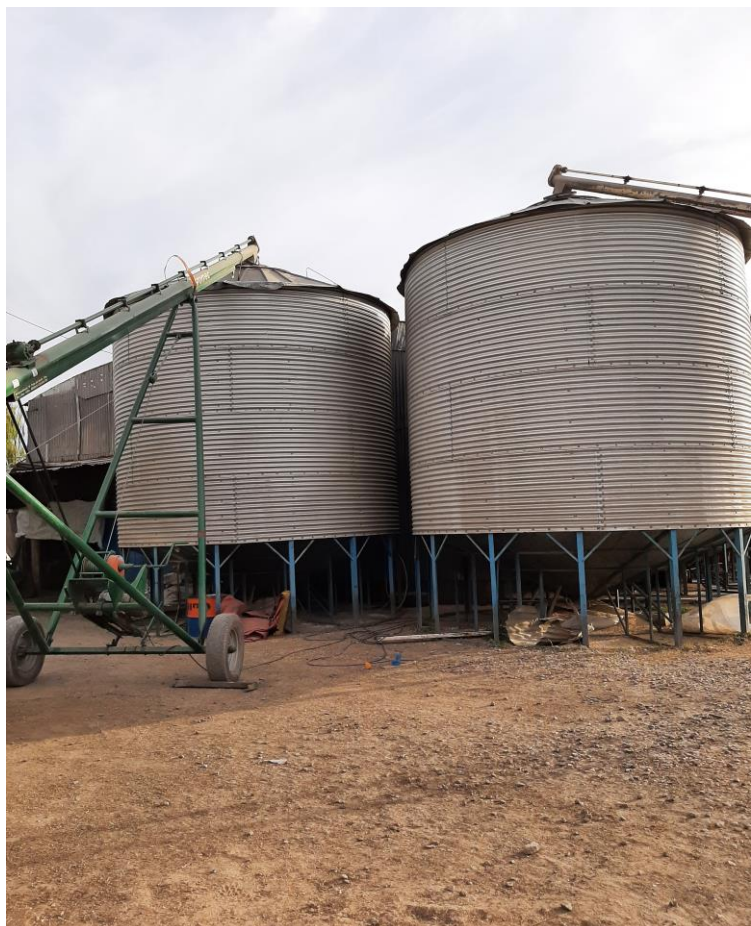
Figura 12: Silos de almacenamiento.
