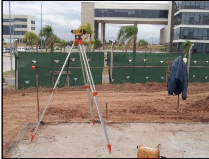
*Fig. 15. Medición Altimétrica en sector Oeste al edificio*
