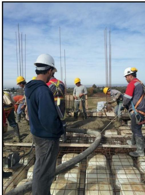
*Fig.33. y Fig. 34. Operaciones de Hormigonado.*
