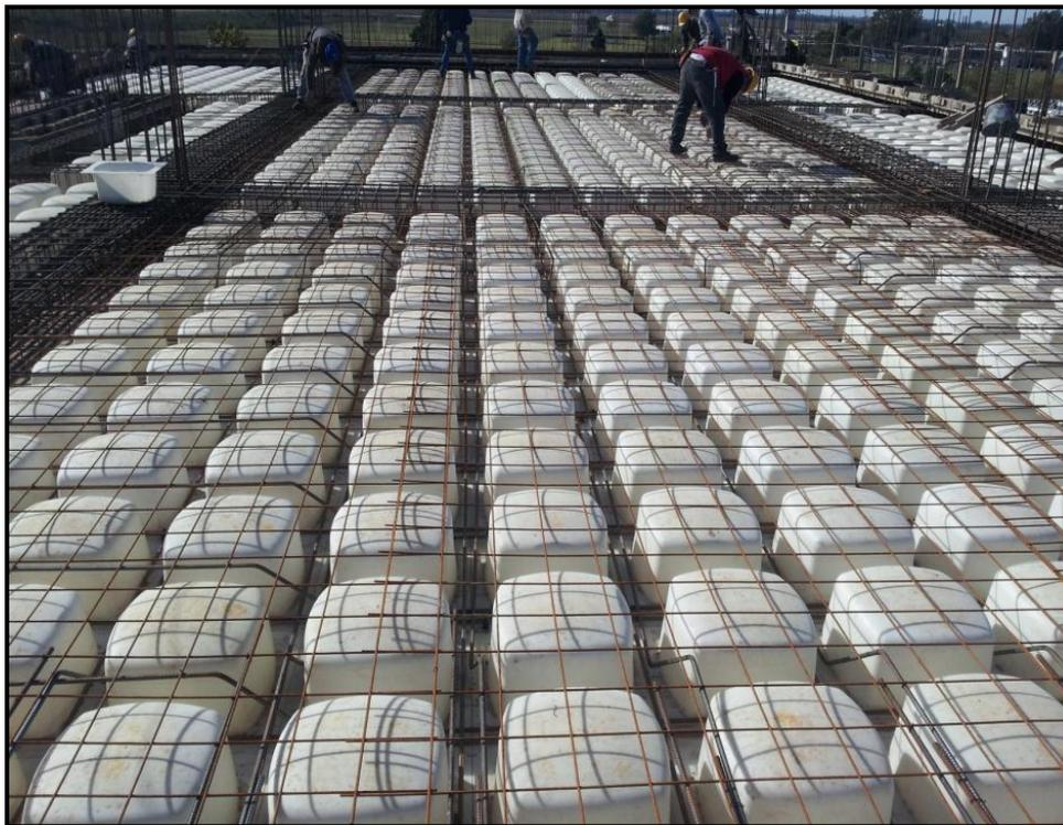
Fig. 30. Armado de losa y disposición de casetones a tope.
