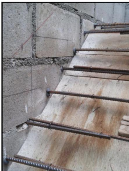
*Fig. 13. Replanteo de escalones sobre muros.*
