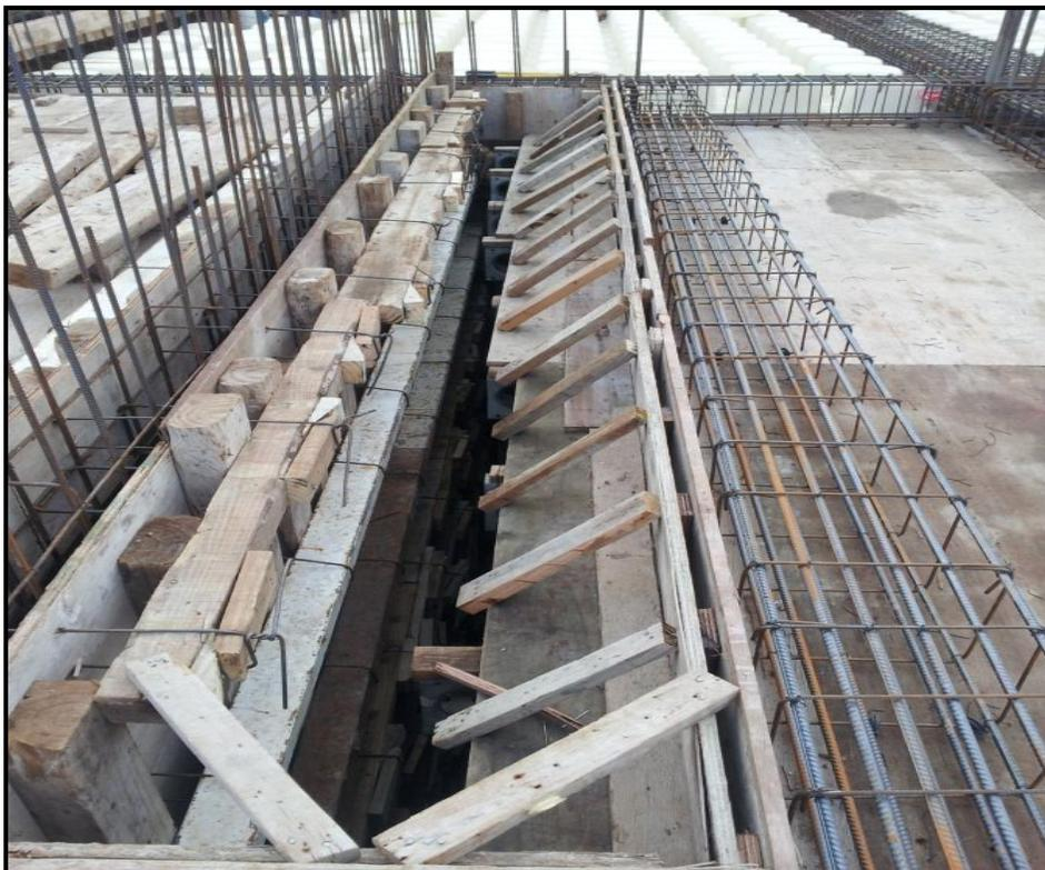
*Fig. 31. Detalle de armado de una viga perimetral a una montante.*
