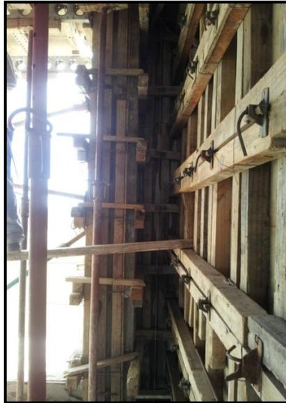
*Fig. 35. Desplazamiento lateral en columna*
