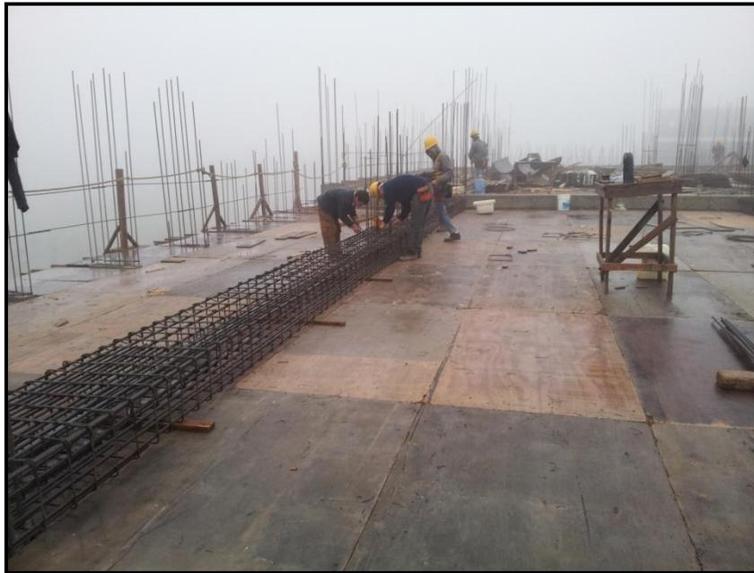
*Fig. 26. Armado de vigas*
