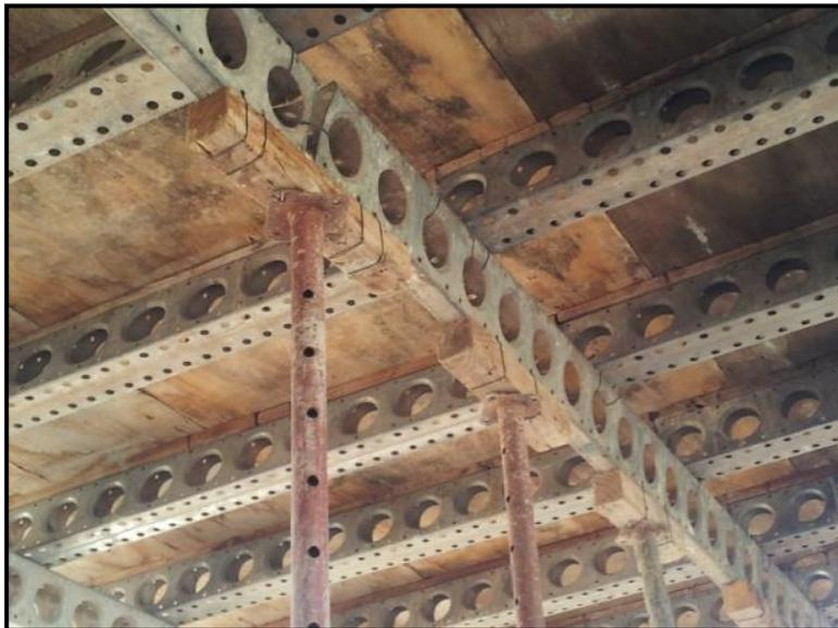
*Fig. 20. Detalle unión de entramado.*
