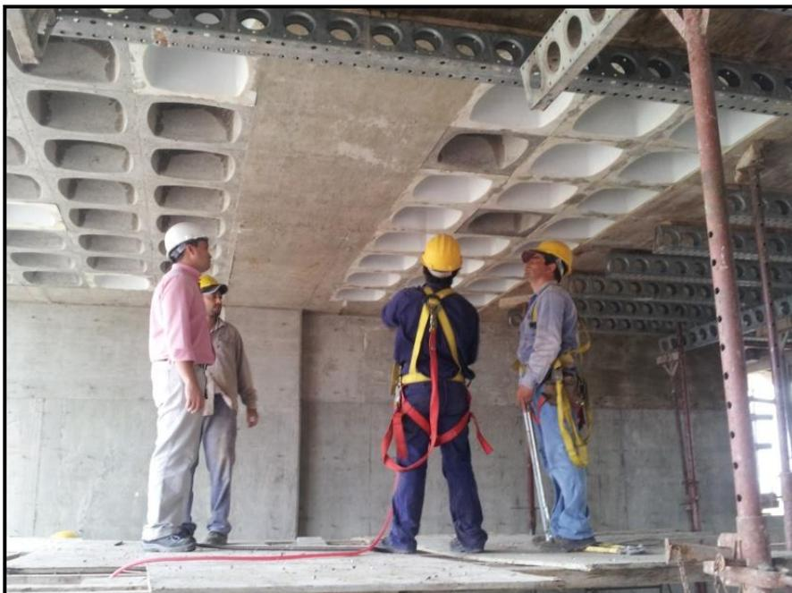
*Fig. 41. Remoción de casetones con incorporación de aire comprimido.*
