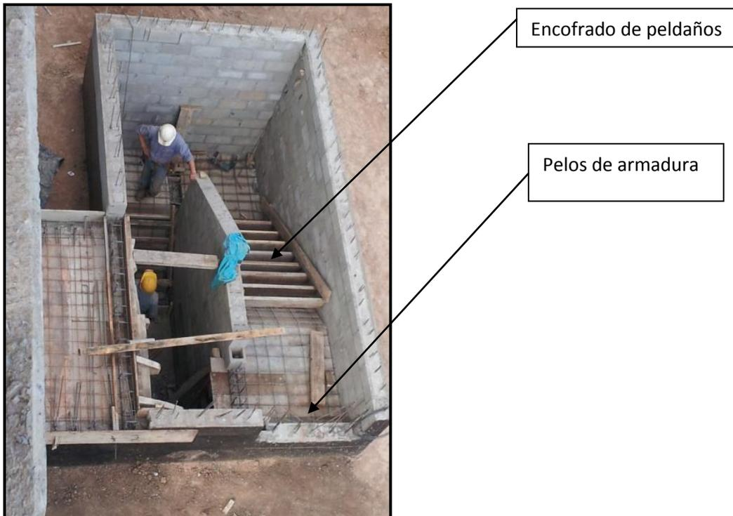
*Fig. 14. Detalle del encofrado de la escalera, con sus peldaños, descanso y armaduras.*
