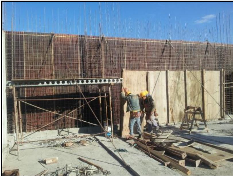
*Fig. 24. Montaje de Fenólicos en tabiques.*
