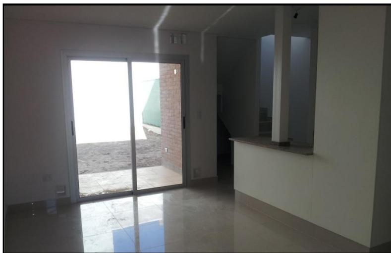
*Fig. 60. Rejillas Inferiores para ingreso de aire y rejillas superiores para egreso de gases de la combustión.*
