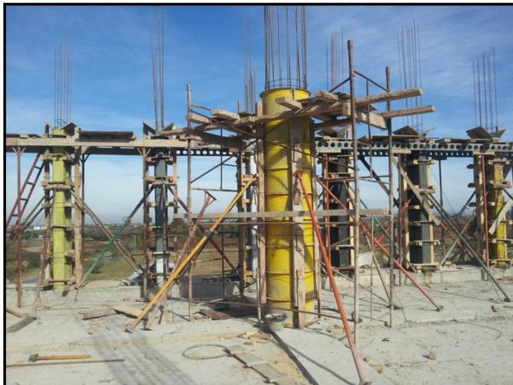
*Fig. 22. Encofrado de columna de sección circular.*
