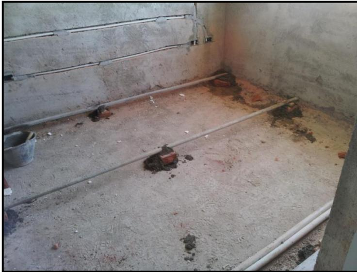
*Fig. 50. Colocación de fajas guías.*
