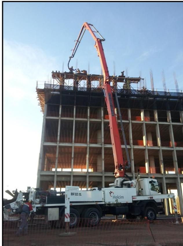
*Fig. 37. Hormigonado de columnas.*
