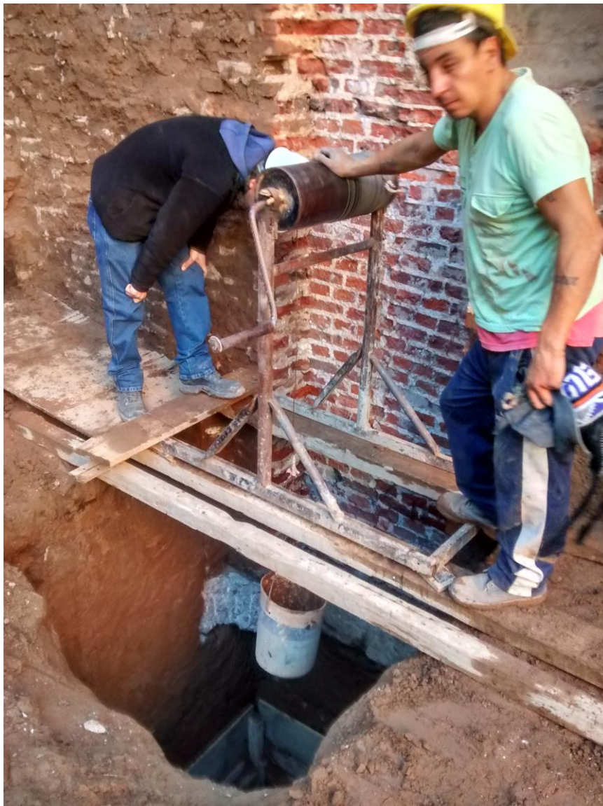
Imagen 5.13 – Obrero operando torno de engranajes
