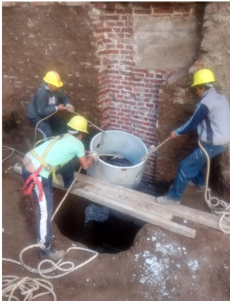
Imagen 5.16 – Obreros bajando aro premoldeado de hormigón
