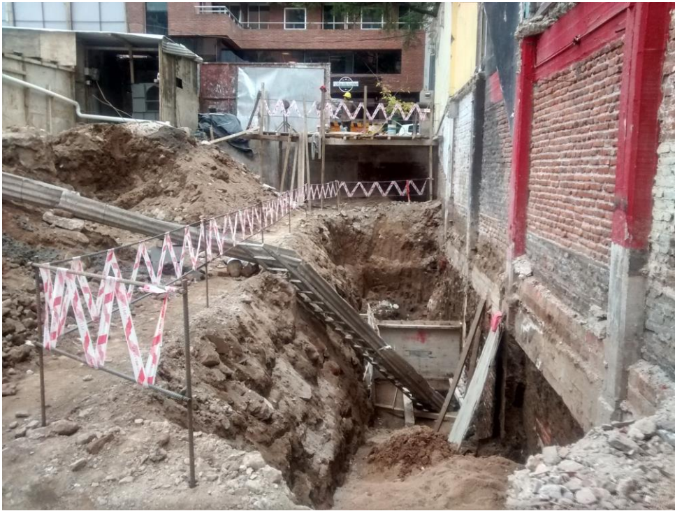
Imagen 5.5 – 3º Paso de Excavación
