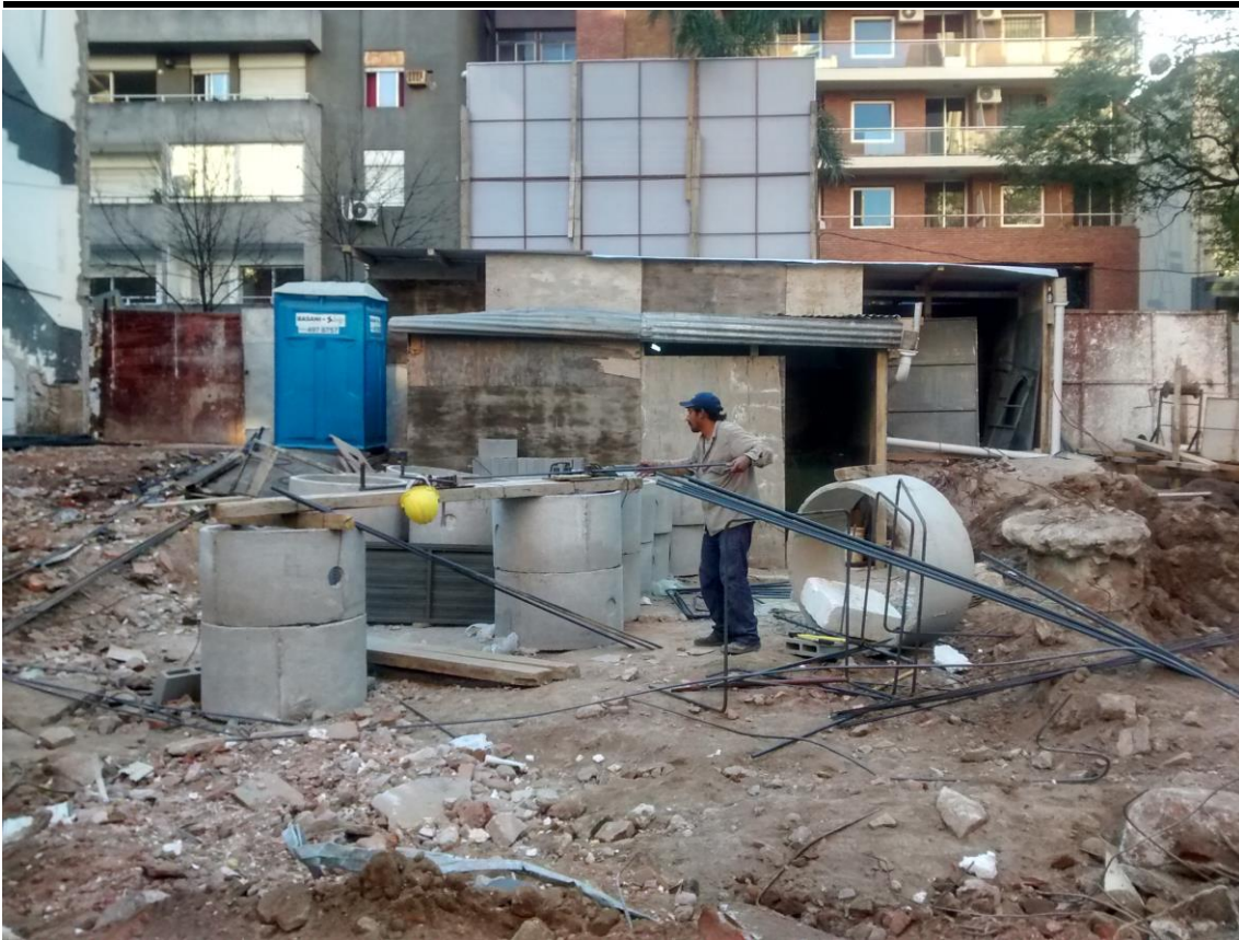
Imagen 5.20 – Obrero realizando armadura del pozo
