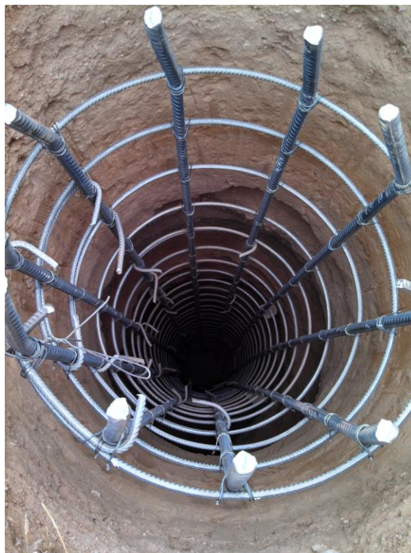
Imagen 5.21 – Armadura de Pozo Romano
