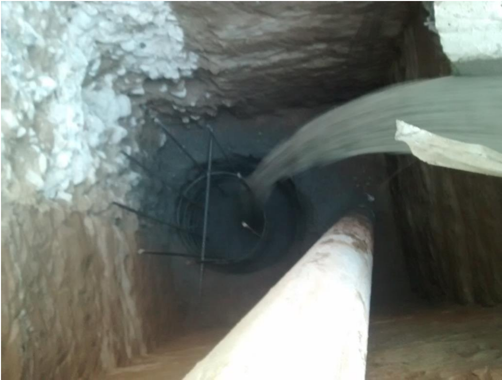
Imagen 5.28 – Descarga directa de hormigón en el pozo
