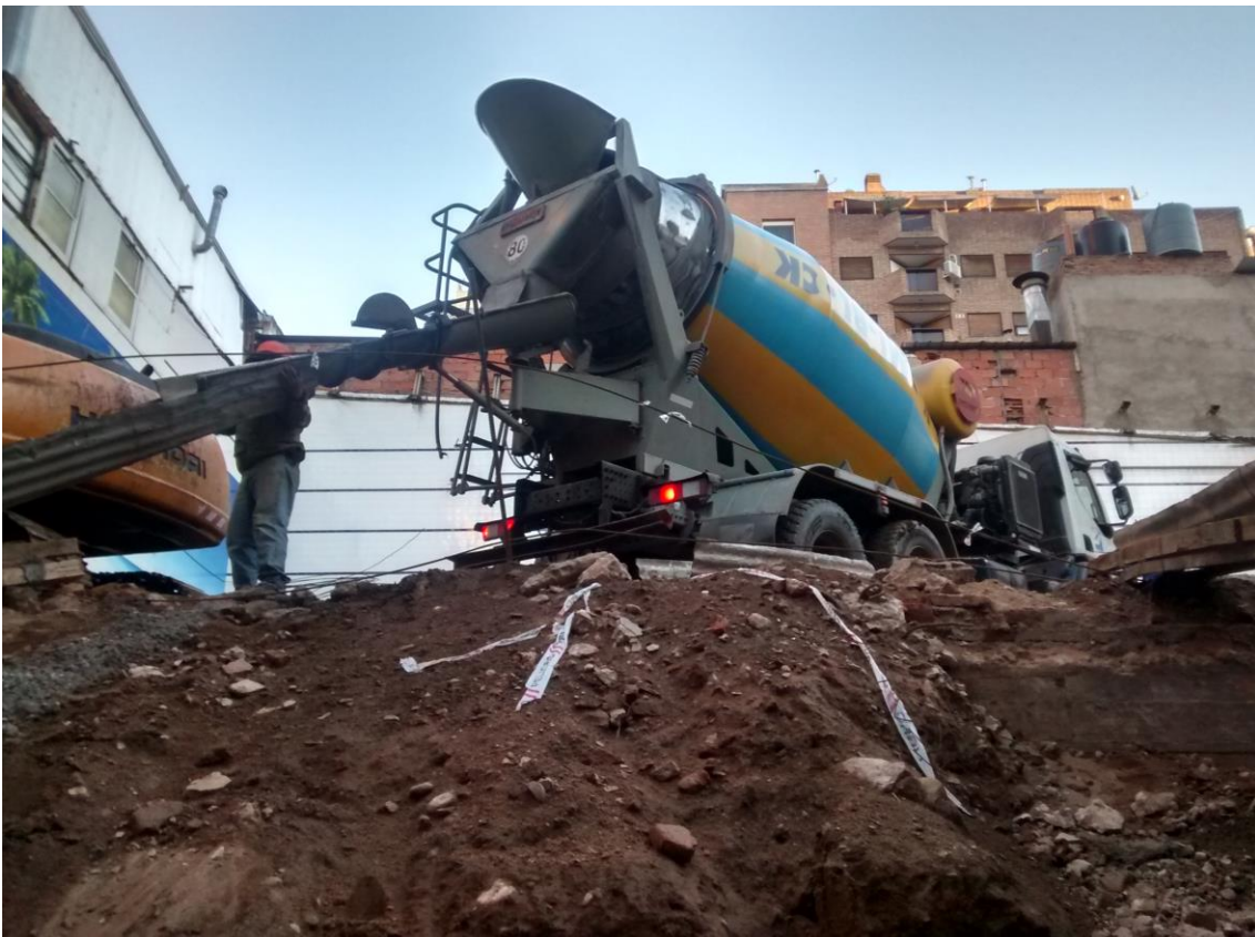
Imagen 5.27 – Camión motohormigonero descargando
