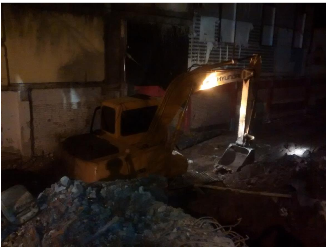
Imagen 5.1 – Retroexcavadora trabajando en turno noche
