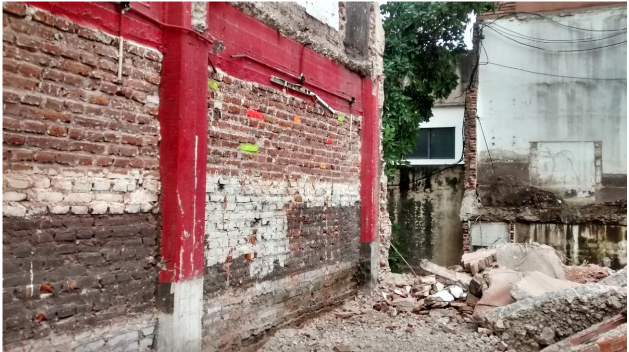
Imagen 5.9 – Ejes de replanteo marcados en muro
