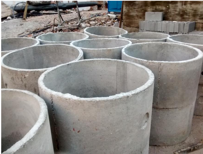
Imagen 5.15 – Zona de acopio de aros premoldeados de hormigón
