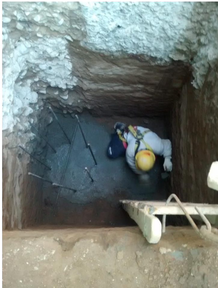
Imagen 5.29 – Obrero uniformizando superficie
