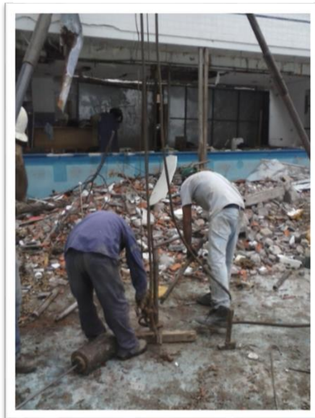
Imagen 2.3 – Ejecución DPSH + SPT
