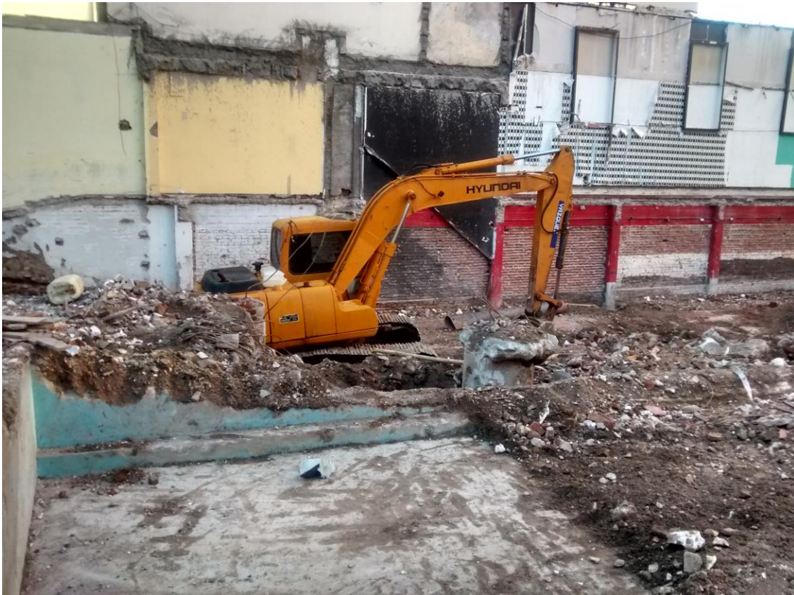
Imagen 5.2 – Retroexcavadora en acción
