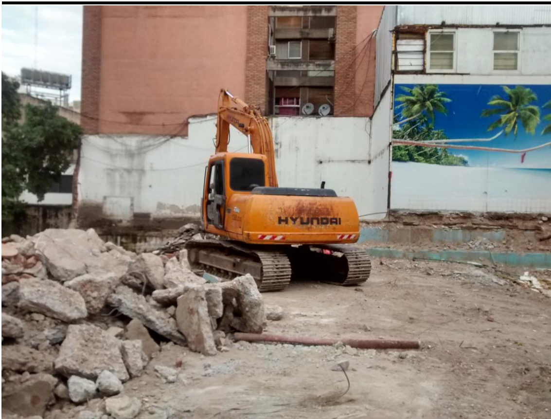
Imagen 5.3 – Retroexcavadora ejecutando talud de excavación
