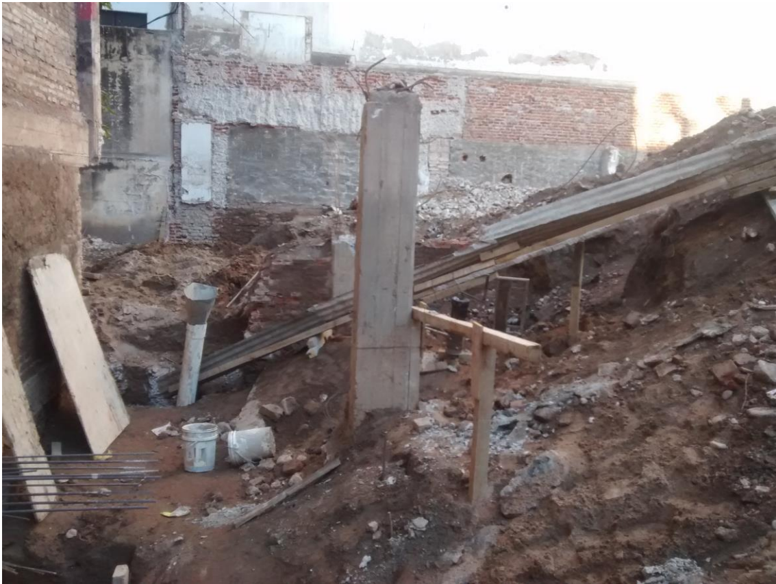
Imagen 5.23 – Hormigonado por medio de manga
