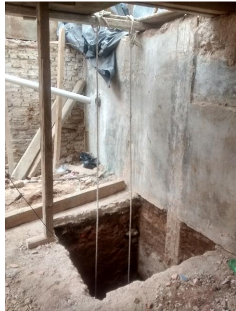
Imagen 5.11 - Comienzo excavación Pozo Romano
