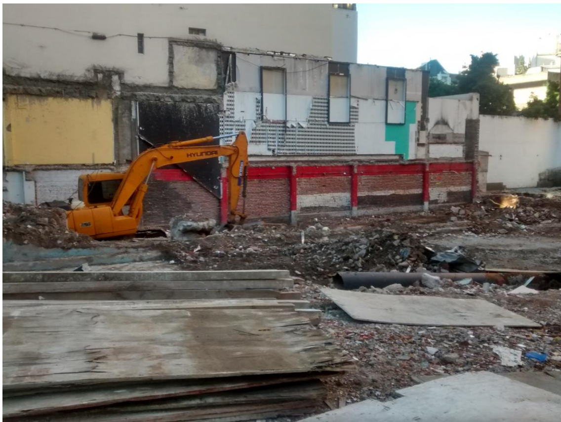
Imagen 5.8 – Muro de fondo, utilizado para replanteo de pozos
