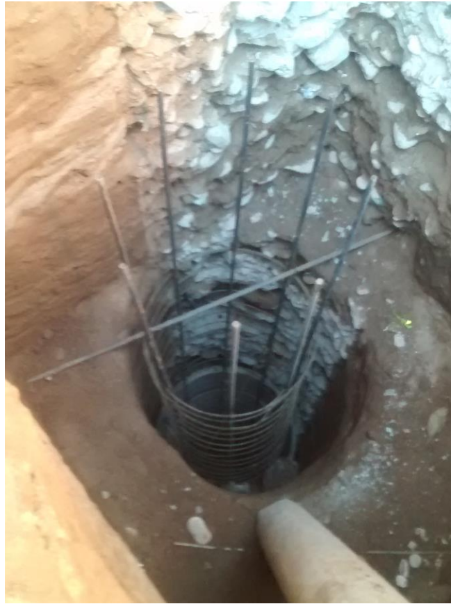
Imagen 5.22 – Colocación de armadura en pozo
