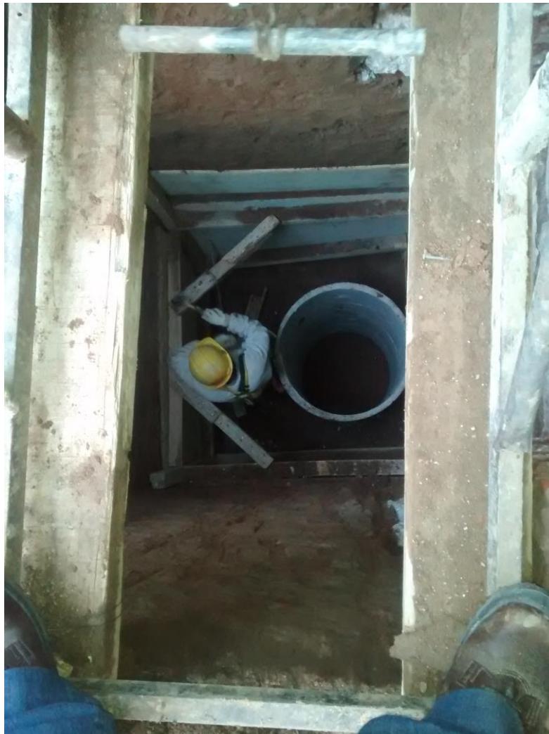
Imagen 5.14 – Operario construyendo entibado de pozo P2/C36
