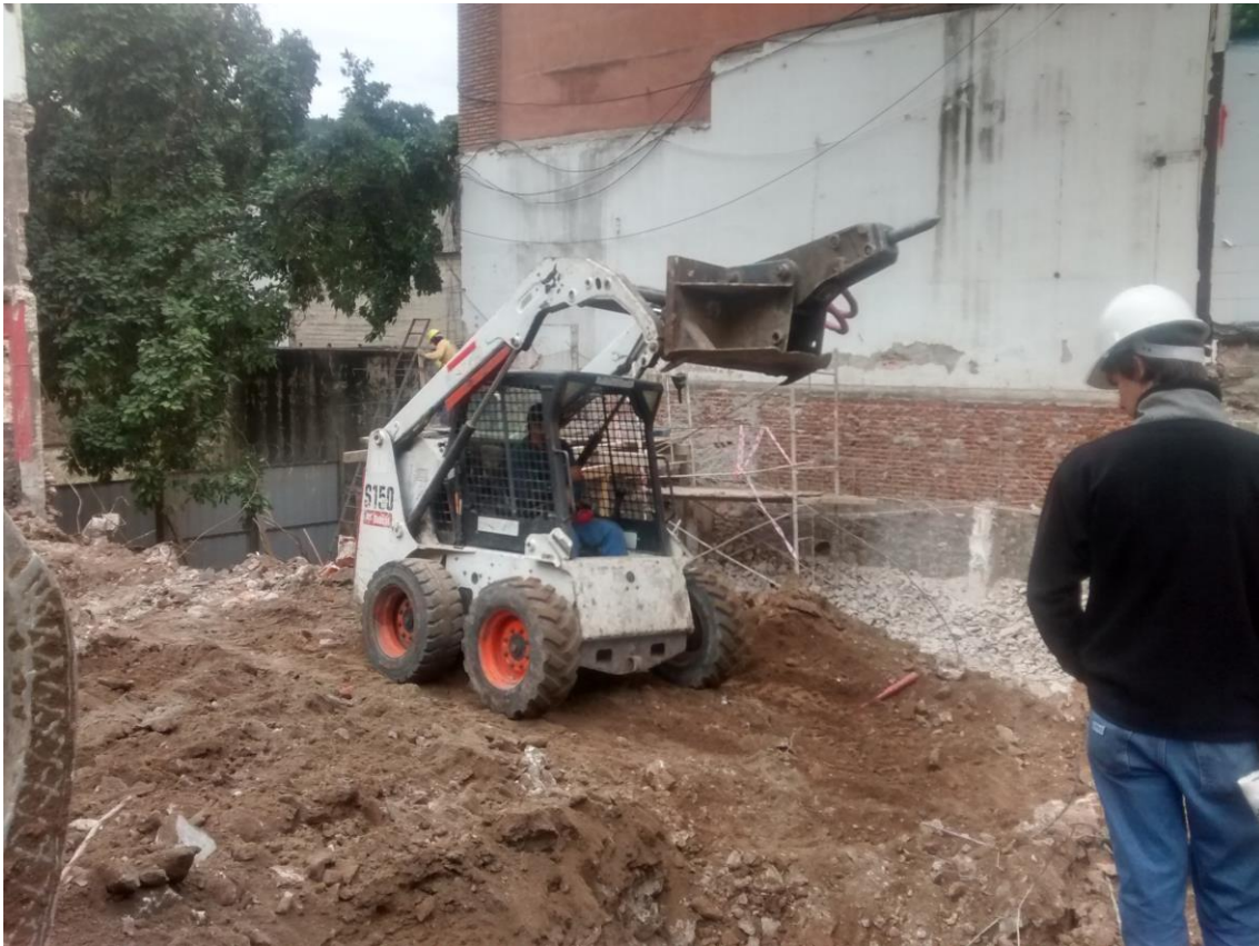
Imagen 5.7 – 4º Paso de Excavación, trabajo con Bobcat con martillo neumático
