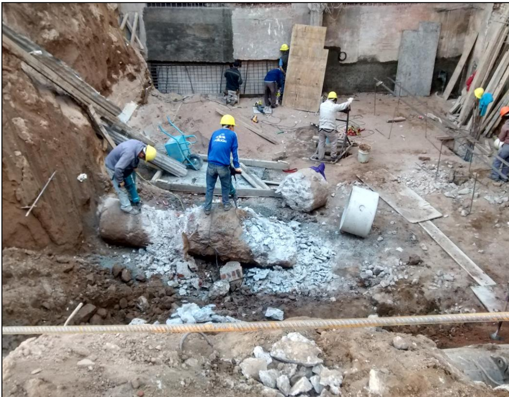
Imagen 5.6 – 5º Paso de Excavación
