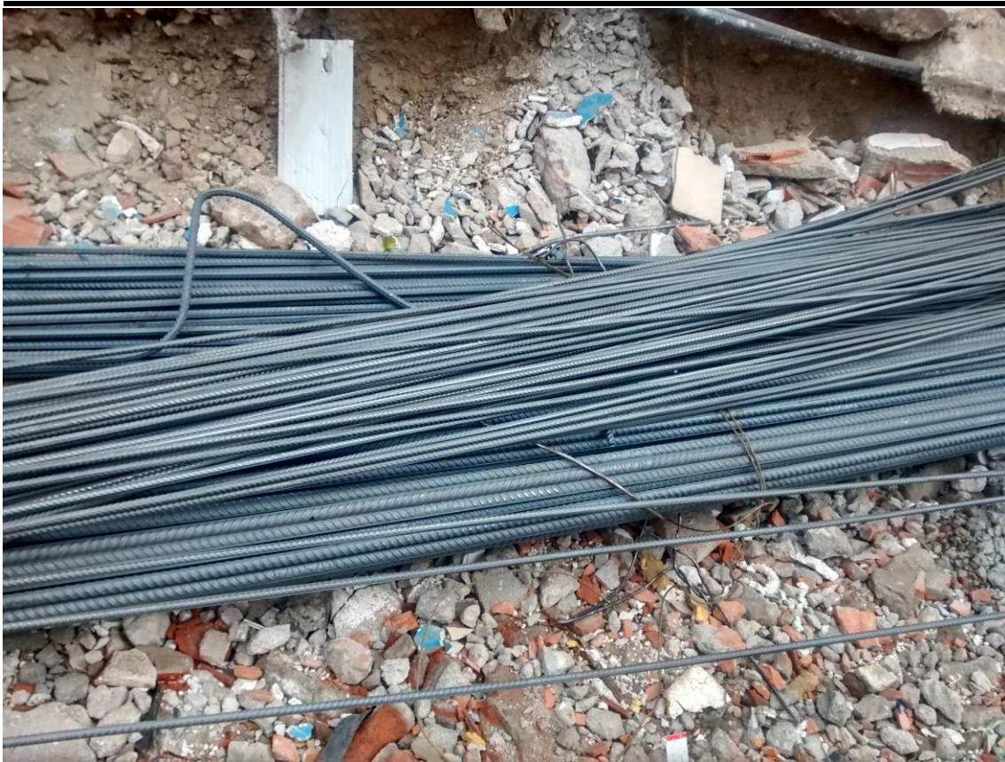
Imagen 5.18 – Zona de acopio de hierros
