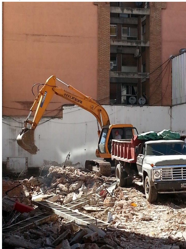
Imagen 5.4 – Camión recogiendo suelo y restos de escombros
