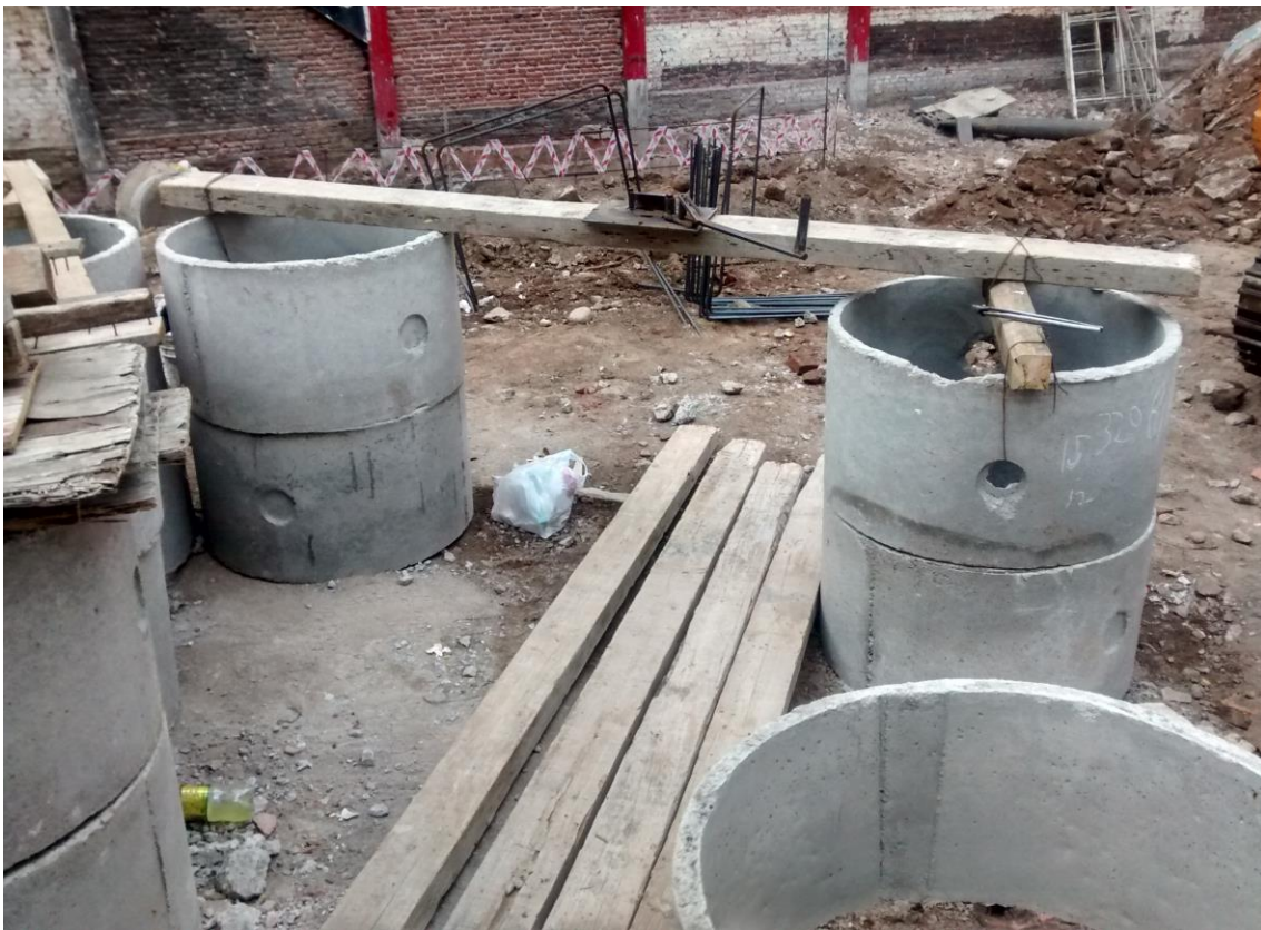
Imagen 5.19 – Zona destinada a la confección de armaduras
