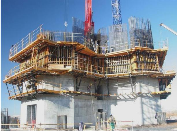
Construcción de dos silos, utilizando encofrados Auto trepantes, se observa el hormigonado de las dos etapas anterior y la colocación de las armaduras para la próxima elevación y su colado propiamente dicho.
