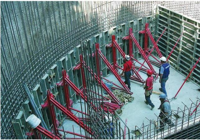
Existen sistemas de encofrado de muros circulares, para manipular con grúa, formados por un bastidor de acero cincado y una superficie de contrachapado fenólico.
