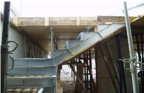
Encofrado de chapa galvanizada luego se arma
