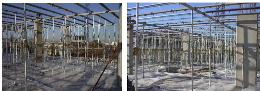
Armado del esqueleto, conformado por banquetas y sobre banquetas de arriostramiento transversales
