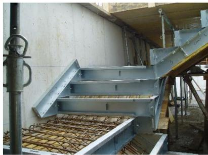
Primero se arma el fondo, luego se coloca la AS (armaduras) y los encofrados para las contrahuellas y sus laterales
