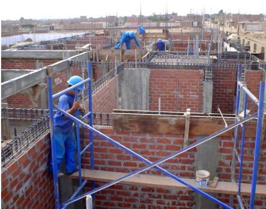
Estructura independiente de vigas y columnas. En la fotografía se observa el armado de encofrado de vigas.
