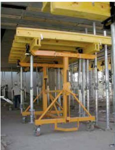
Esta operación se realiza mediante el uso de balancines o grúas que permiten recoger y dejar la mesa en su posición solo con movimientos de grúa.
