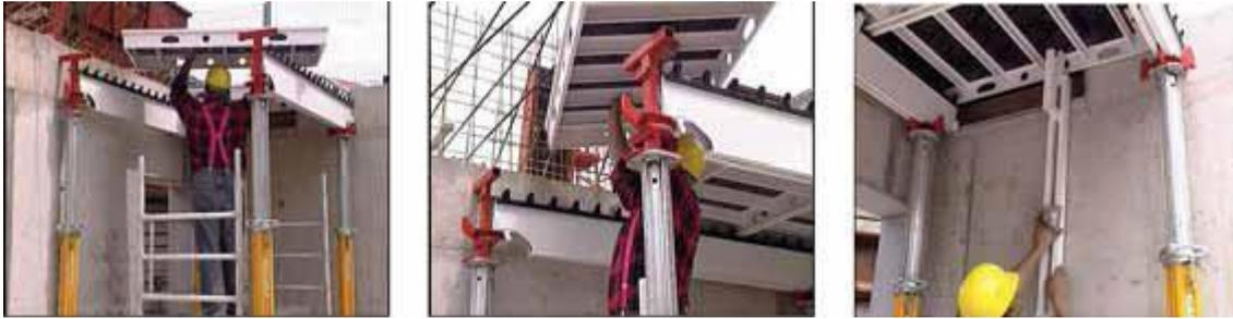
Una vez estabilizado el primer módulo iremos avanzando conforme a las instrucciones del fabricante. Este sistema permite el montaje mediante el uso de varas metálicas del siguiente modo:
