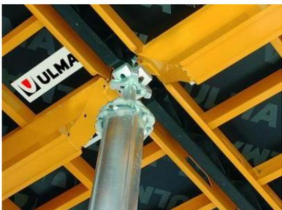
Control y sujeción de vigas primarias
