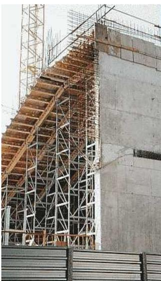
Los andamios metálicos están formados por la yuxtaposición y enlace de tubos metálicos (acero dulce, aluminio, tubos galvanizados). La unión entre barras está acompañada por medio de manijas y acoplamientos patentados.
