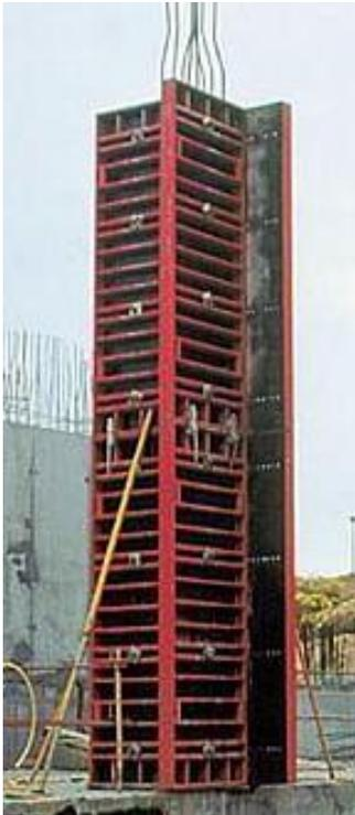
Sistema para encofrar pilares cuadrados y rectangulares con paneles a reducción, que permite realizar las diferentes secciones que demanda el mercado con un único panel que se ajusta gracias a una retícula con variaciones cada 5 cm.
