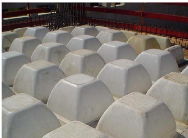
Este sistema de recuperación del encofrado, ya sea parcial o total, debe tener en cuenta además de su cálculo para sostener y sostenerse, la secuencia del desencofrado, la limpieza de cada elemento, el almacenamiento y su posterior mantenimiento; para obtener elementos en buenas condiciones y que puedan ser utilizados en otras oportunidades.
