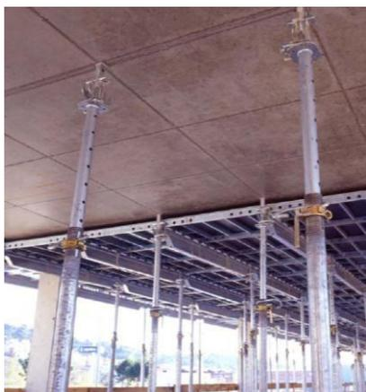
Por lo general son piezas telescópicas, provistos con una base, una cabeza t (cabezal) un sistema de extensión según sea la marca y modelo utilizado.
