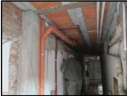
Plomero colocando tuberías
