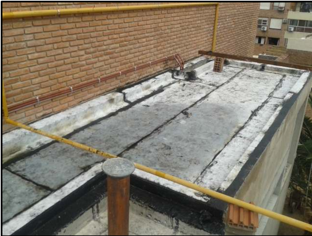
Prueba de estanqueidad
