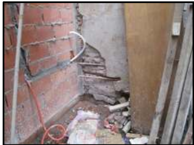
Corrugado flexible, Cocina Planta Baja.
