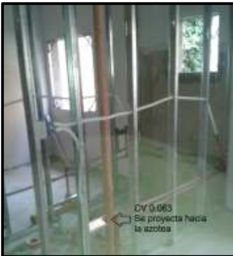
Proyección CV hacia azotea
