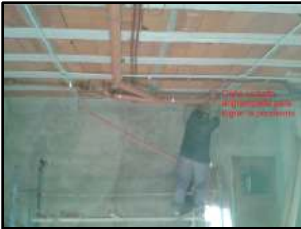
Sujeción de cañerías con grampas
