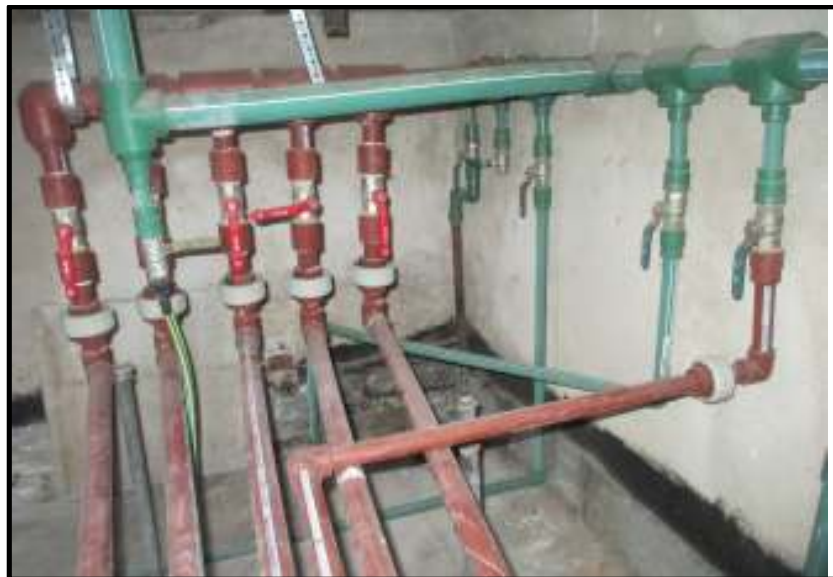
Colectora, puente de empalme y bajadas provisionarias
