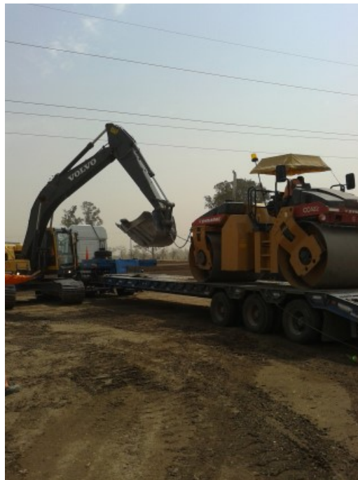
Figura 7.7: Excavadora auxiliando a RV bloqueado. Rumbo al taller central
