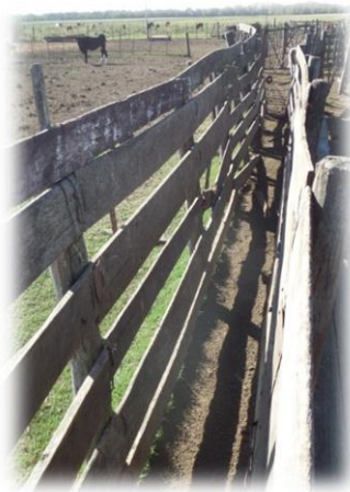
Figura 11: Vista interna de la manga.
