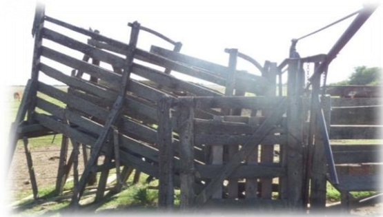
Figura 14: Cargadero que presenta separación entre sus tablas.
