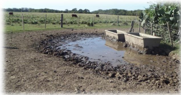
Figura 17: Pérdida ocasional de agua por ruptura del flotante y sin protección exterior.
