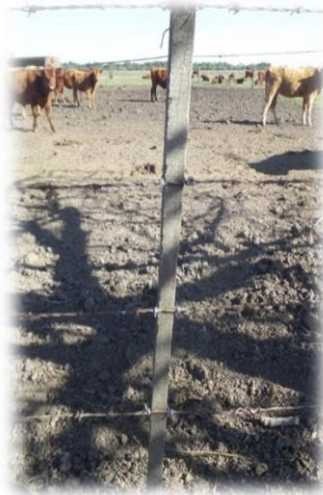
Figura 7: Alambrado interno del corral con púas y ataduras libres.
