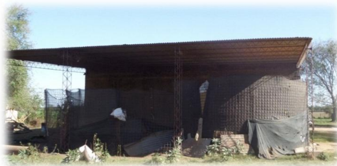
Figura 20: Silo de malla de alambre con grano de maíz para la alimentación del ganado.
