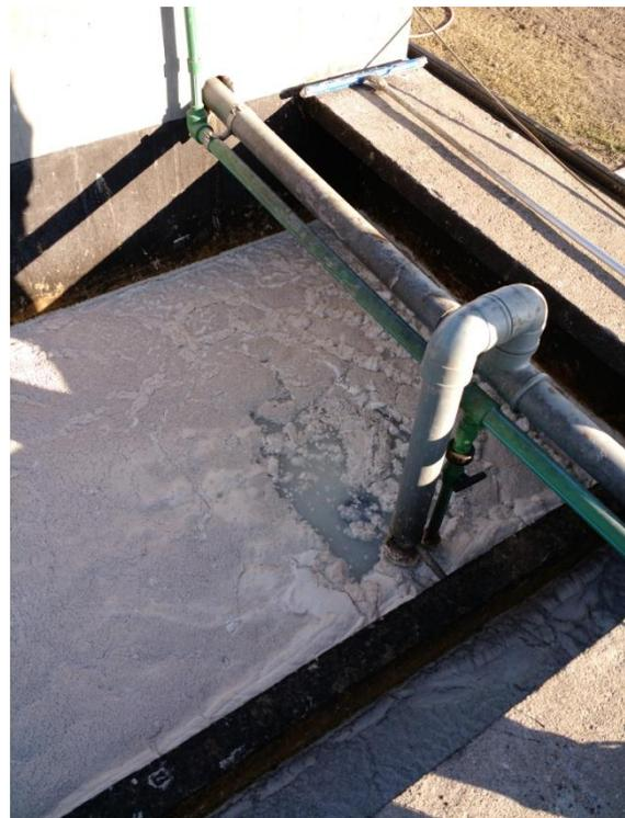
Figura 17. Sistema Air Lift.
