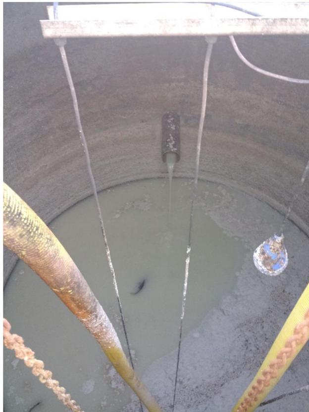
Figura 16. Entrada del efluente crudo al tanque ecualizador.
