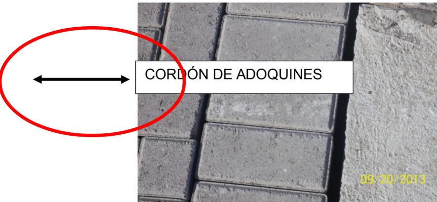
Fig. N° 103-8 Primera fila del patrón en obra
