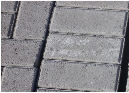
Fig. N° 110-8 juntas de adoquines
