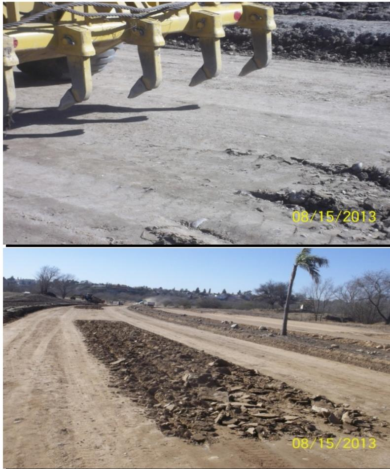
Fig. N° 47-6 Escarificación en zona de densidad no verificada
