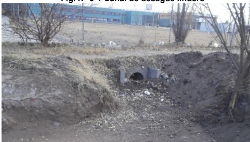
Fig. N° 10-1 Alcantarilla de desagüe de terreno lindero
