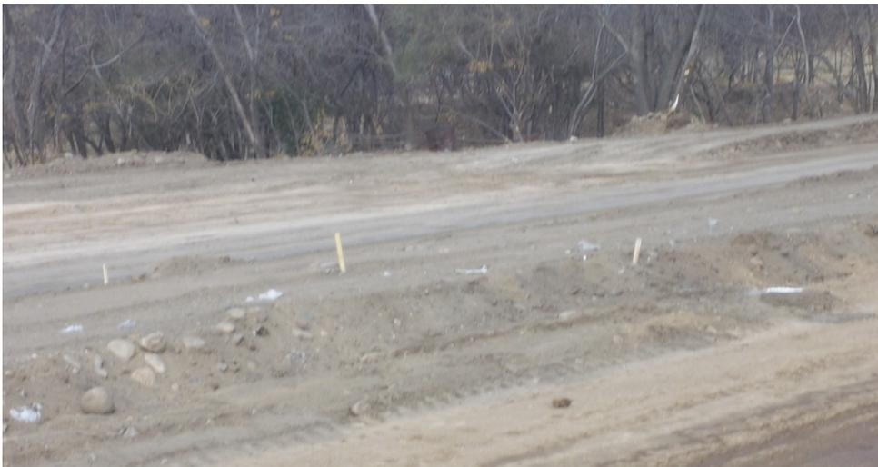
Fig. N° 56-7 Puntos de referencia para nivelación
