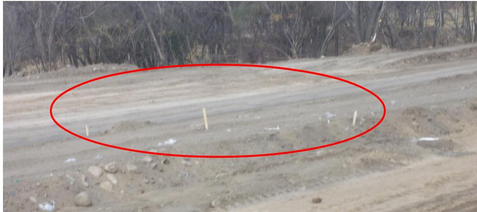
Fig. N° 27-4 Estacas de cantero central
