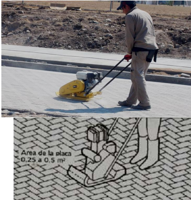
Fig. N° 86-8 Compactación de adoquines
