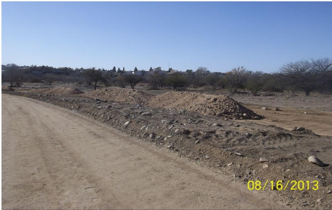
Fig. N° 59-7 Distribución de la segunda capa de la base granular
