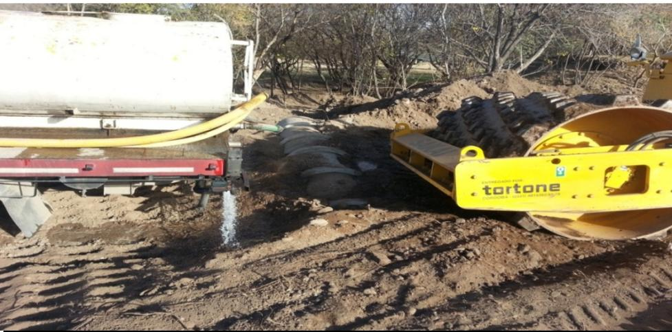
Fig. N° 41-5 riego con camión regador
