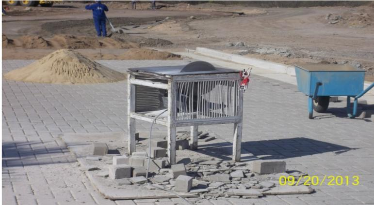
Fig. N° 114-8 corte de adoquín en obra con cierra circular
