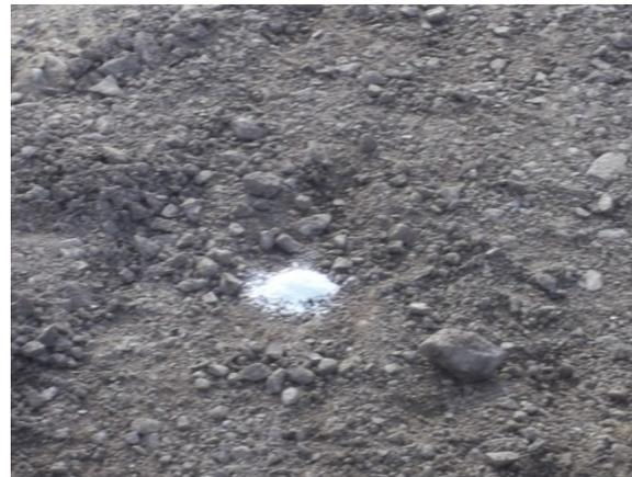
fotos podemos ver como se colocaban las estacas de madera la logrando un tipo de mojón coronado con cal para que cuando pase la maquina quede en contraste con el suelo indicando el nivel en que esta la capa con respecto al corte.
