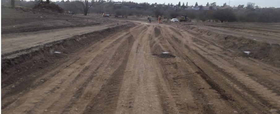
Fig. N° 54-7 replanteo de la primera capa de la base referenciados al eje que pasaba por el centro del cantero central en función de la pendiente de la vía.
