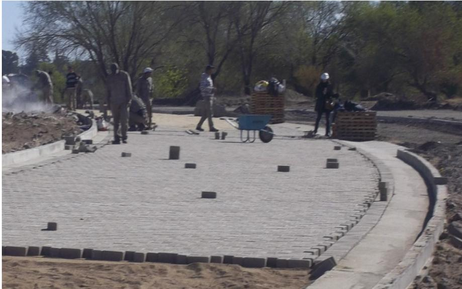
Fig. N° 90-8 Estructura de confinamiento en obra
