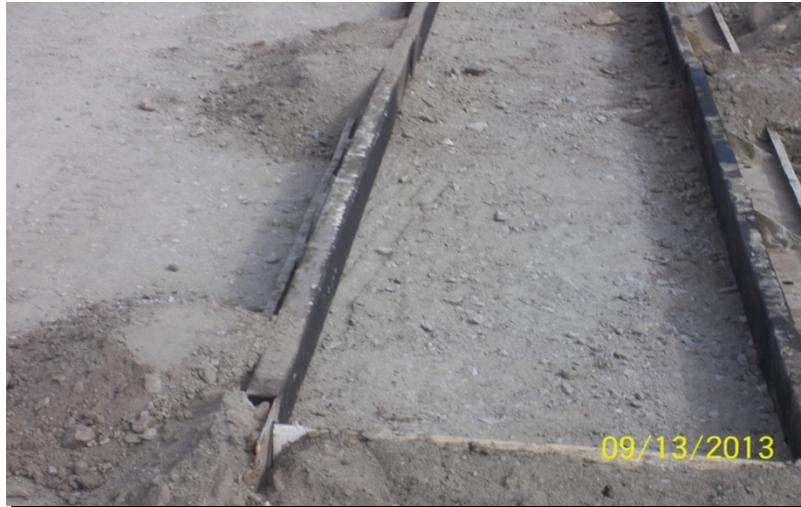
Fig. N° 67-7 Encofrados de cordones cunetas
