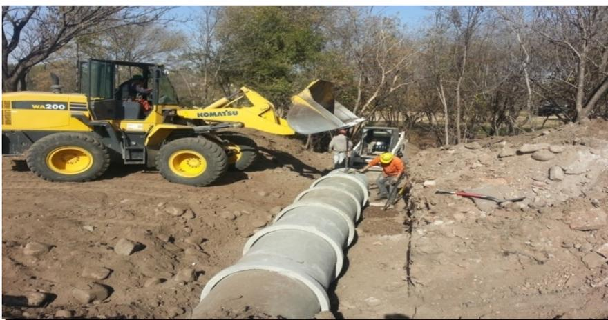
Fig. N° 39-5 Colocación de alcantarilla de sección circular
