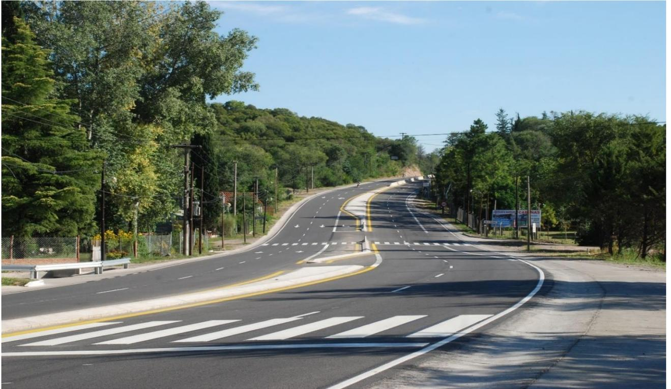
*Ilustración 165: Pintura termoplástica aplicada por VAWA en la ruta provincial E-*
