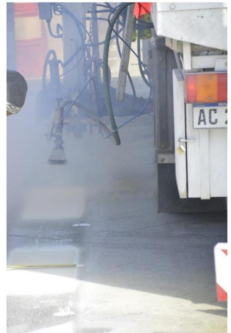
*Ilustración 9: Proceso de aplicación por método Spray de pintura termoplástica*
