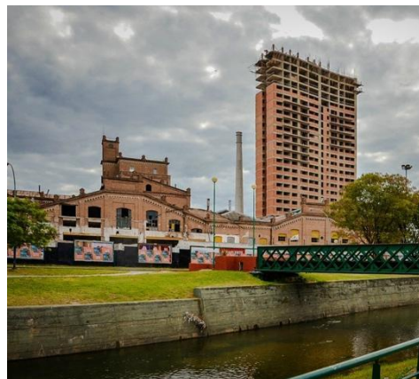
Fig. 6 Vista del actual estado de las obras paralizadas en el predio de la ex cervecería Córdoba. Fuente: Street view de Google Earth
