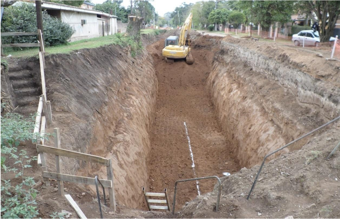
Figura N°2-7: Replanteo del eje del canal.
