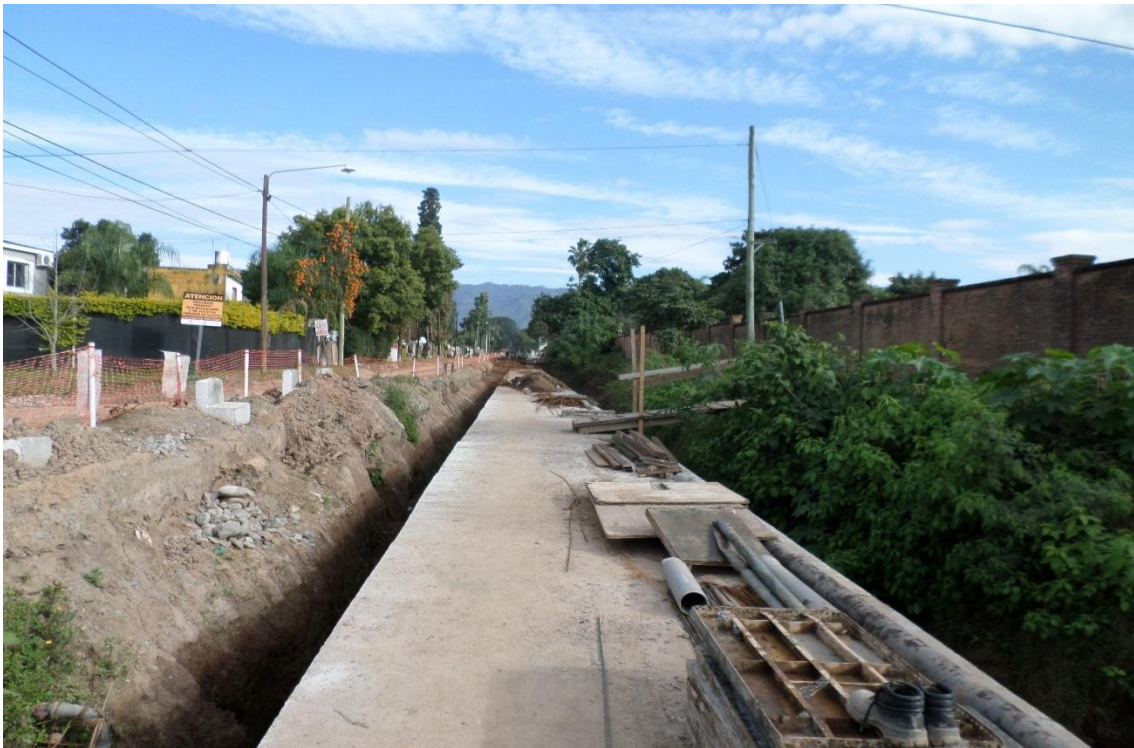
Figura N°2-13: Sección terminada con laterales sin compactar.
