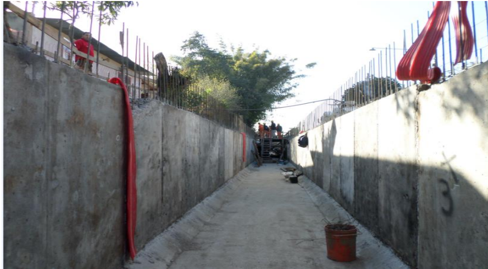
Figura N° 4-6: Tabique Hormigonado.
