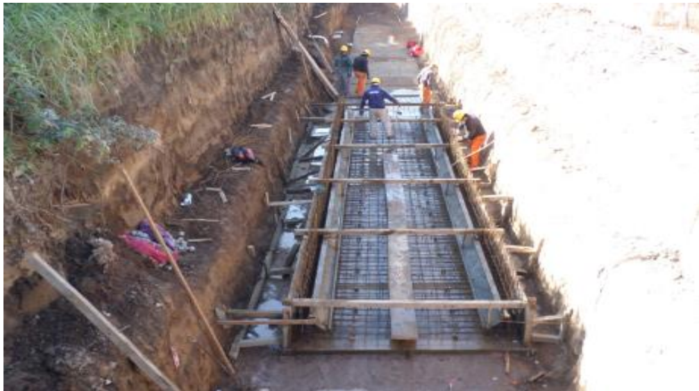
Figura N°4-3: Solera: armado y encofrado.
