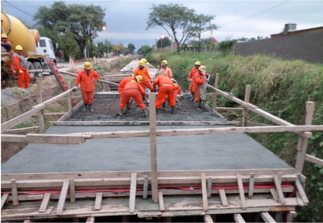
Figura N°4-10: Losa: Hormigonado.
