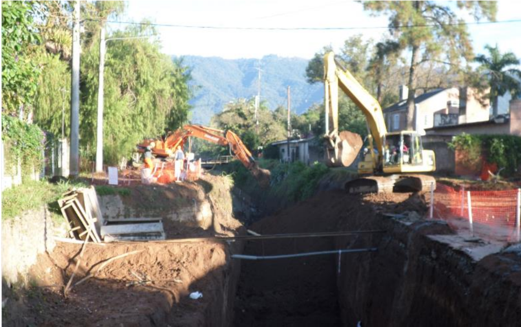
Figura N°3-1: Solución de interferencia (caño de agua potable).
