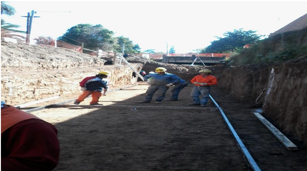
Figura N°4-1: H-8: Terreno preparado para el colado del Hormigón de limpieza.
