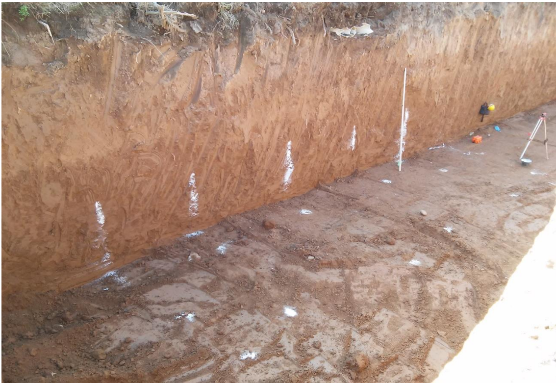
Figura N°2-8: materialización de los bordes de excavación.
