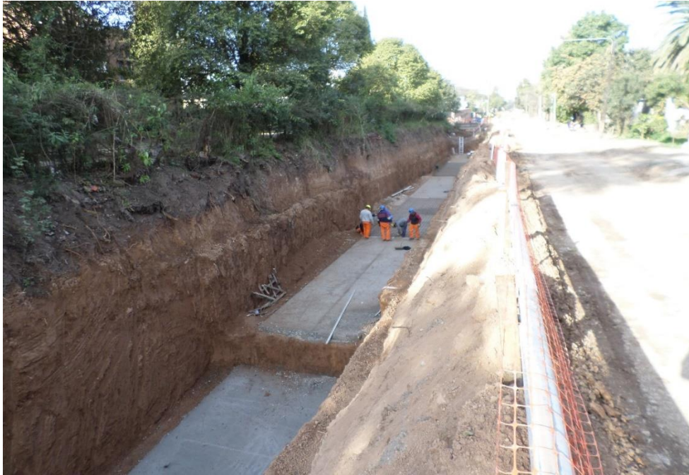
Figura N°4-2: H-8: Varios tramos de Hormigón de limpieza terminados.
