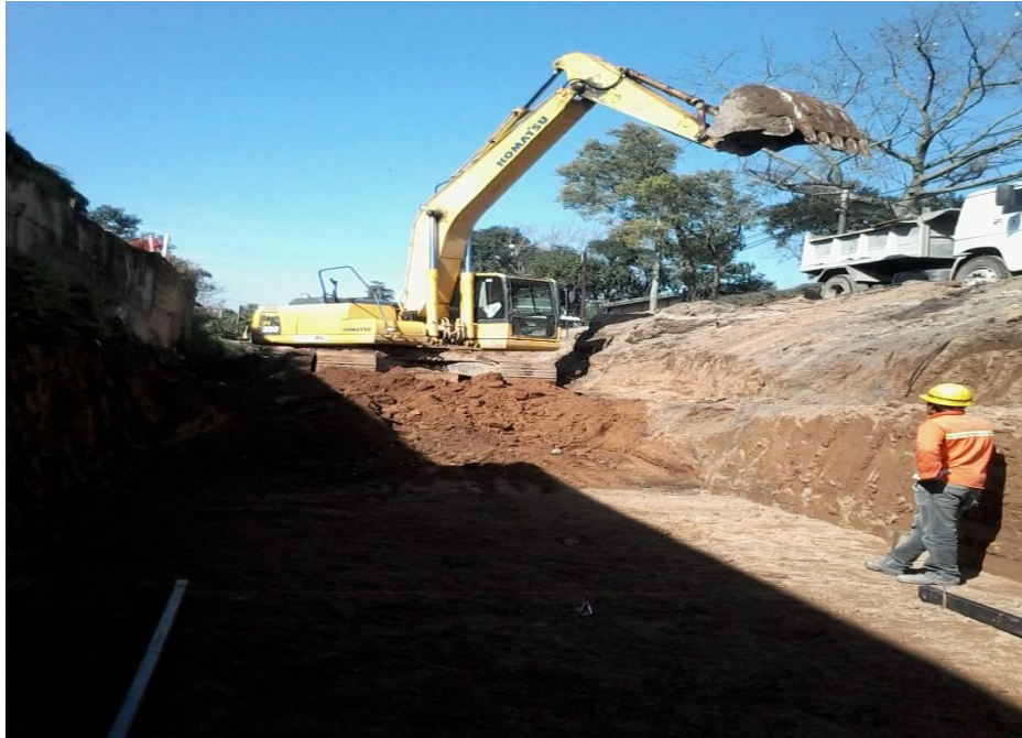
Figura N°2-10: Extracción de suelo y traslado del mismo.
