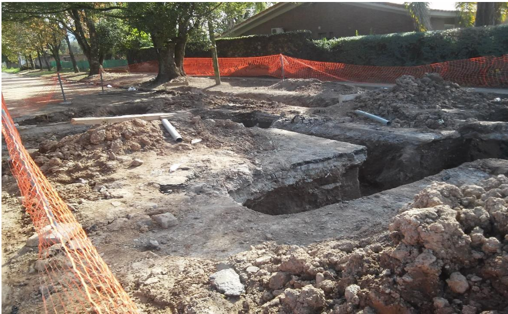
Figura N°3-28: Excavación del imbornal. Cloaca RD-L
