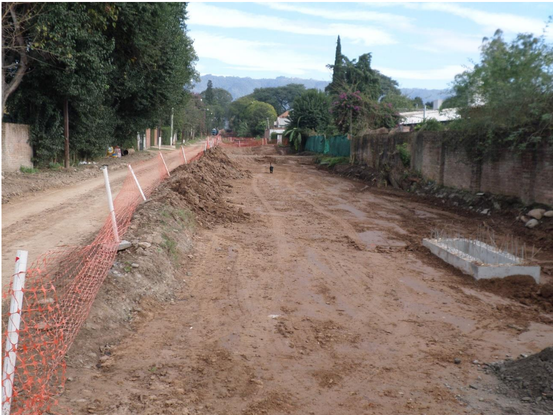
Figura 2-15: Compactación a nivel de rasante.
