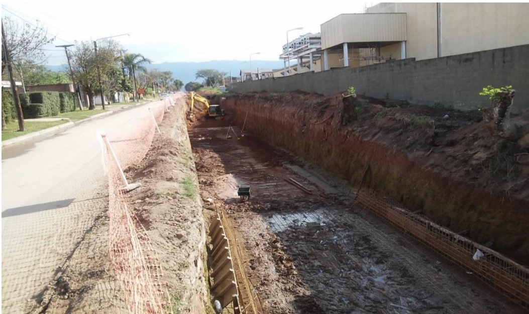
Figura N°2-6: Nivel estacionado para replantear eje y borde de excavación.
