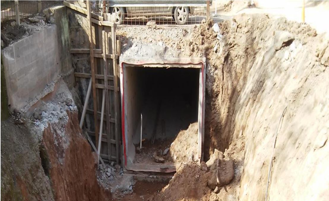
Figura N°4-12: Sección terminada. Se puede apreciar las juntas realizadas entre cada módulo.
