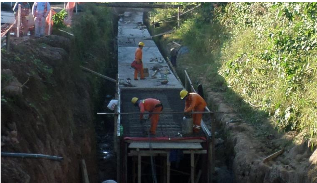
Figura N° 4-9: Losa: armado.
