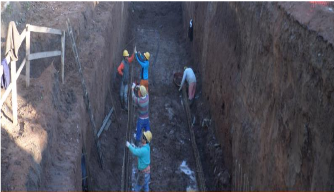
Figura N° 4-5: Tabique: armado.
