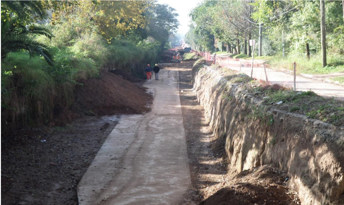
Figura N°2-14: Compactación hasta nivel de losa. Se observa también acopio de material para la compactación de uno de los laterales.
