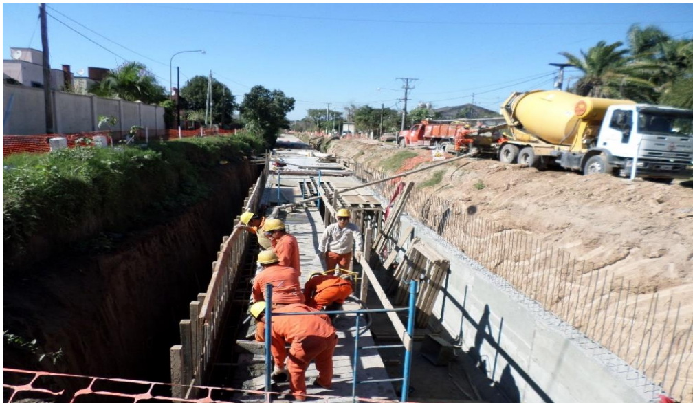
Figura N° 4-7: Losa: inicio de Trabajos de encofrado.
