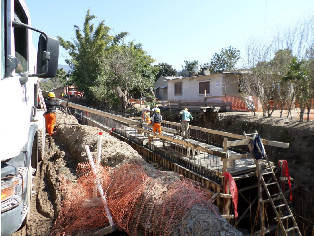
Figura N° 4-8: Losa: encofrado.
