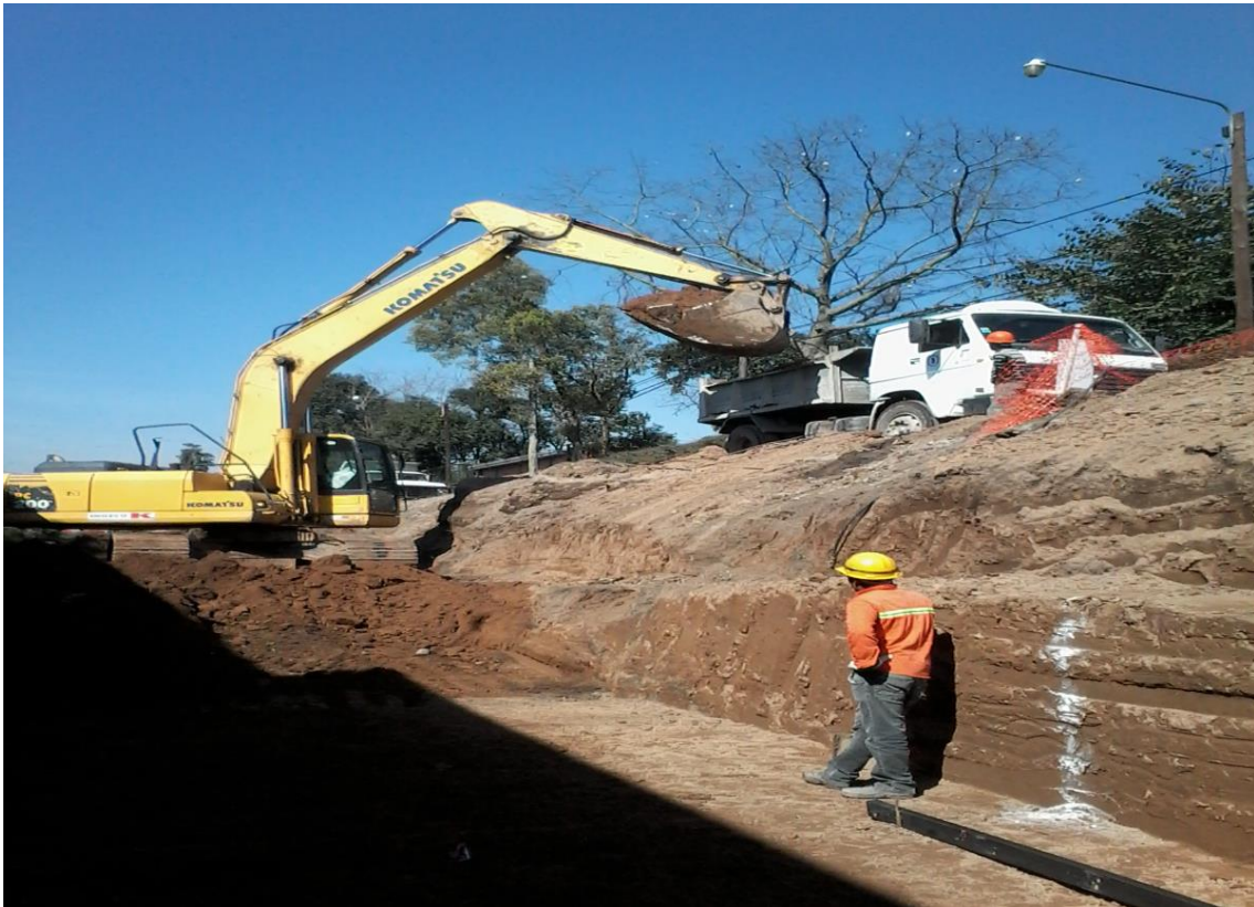
Figura N°2-9: Extracción del suelo y traslado del mismo.
