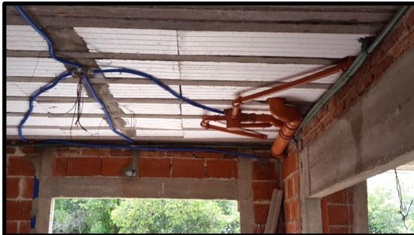
**Figura 2. 16.** - Instalación eléctrica y cloaca.
