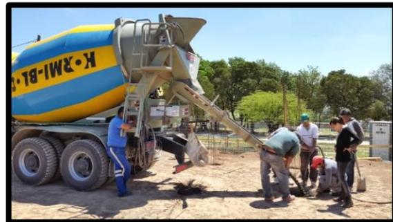
**Figura 2. 8. -** Posicionamiento de armadura y colado de hormigón.
