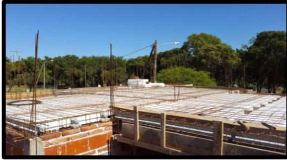
**Figura 2. 14. - Armado final de losa sobre P.B.**
