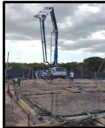
**Figura 2. 7. -** Hormigonado de vigas riostras
