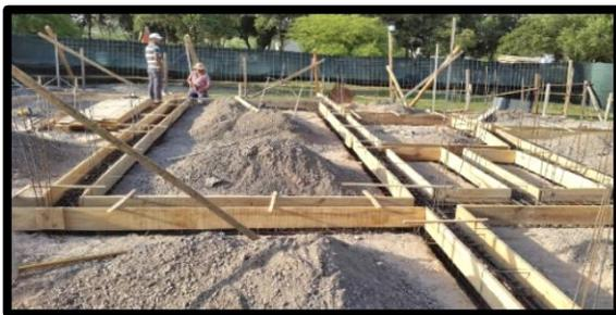
**Figura 2. 9 -** Posicionamiento y encofrado de vigas riostras.
