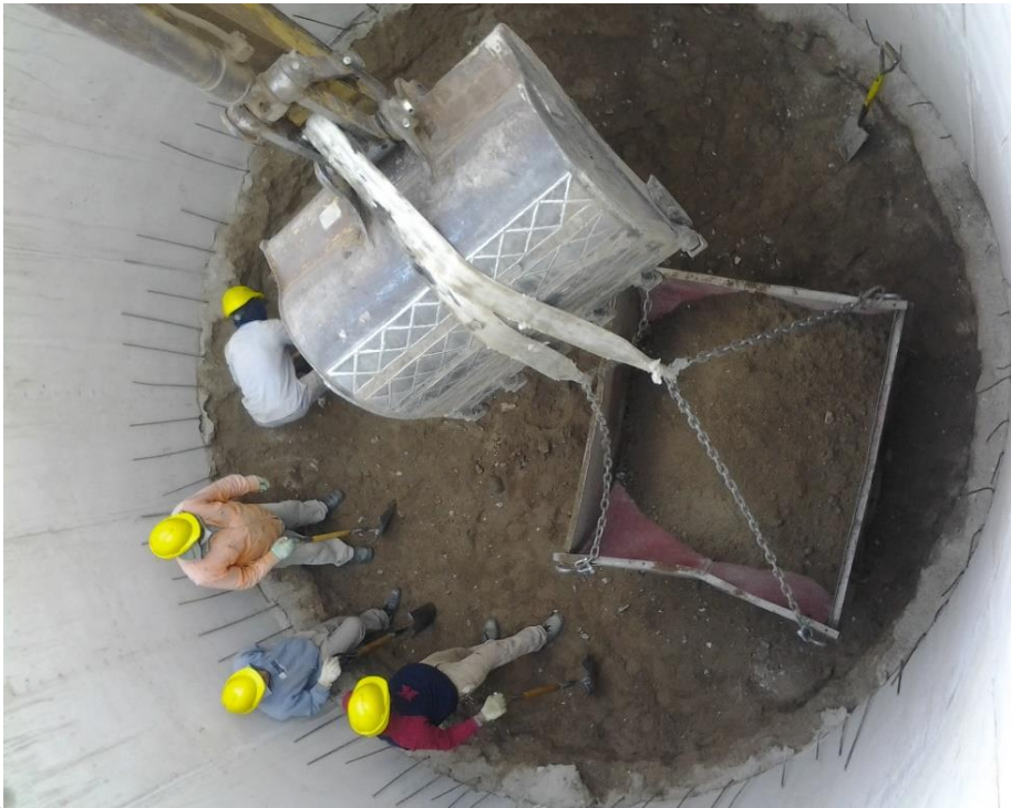
Fig. 3.36 Retiro de suelo de foso de noria
