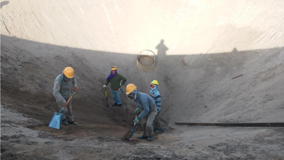
Fig. 3.37 Perfilado de fondo cono de silos
