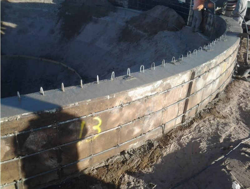
Fig. 3.39 Encofrado viga anillo
