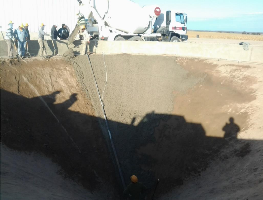
Fig. 3.41 Colado de hormigón de limpieza en fondo cono
