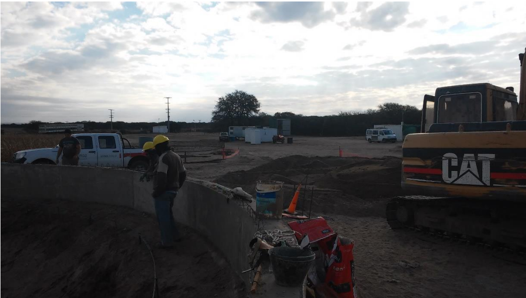
Fig. 3.40 Viga anillo
