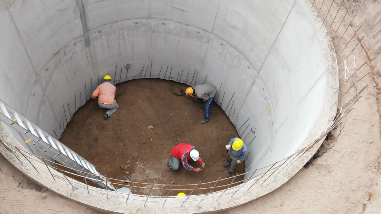
Fig. 3.35 Excavación para descenso de foso de noria
