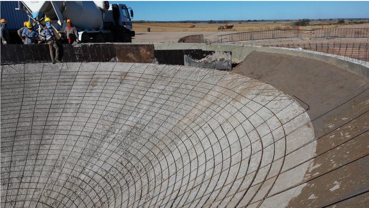
Fig. 3.42 Barro cemento y armaduras en fondo cono
