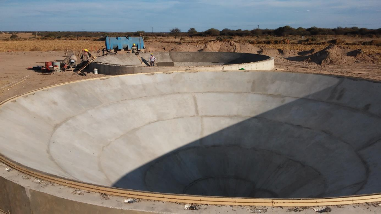
Fig. 3.45 Fundación de Silos
