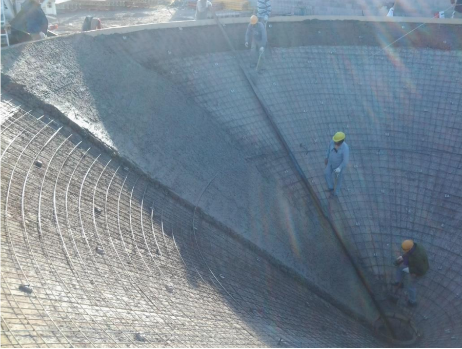
Fig. 3.43 Colado de hormigón fondo cono
