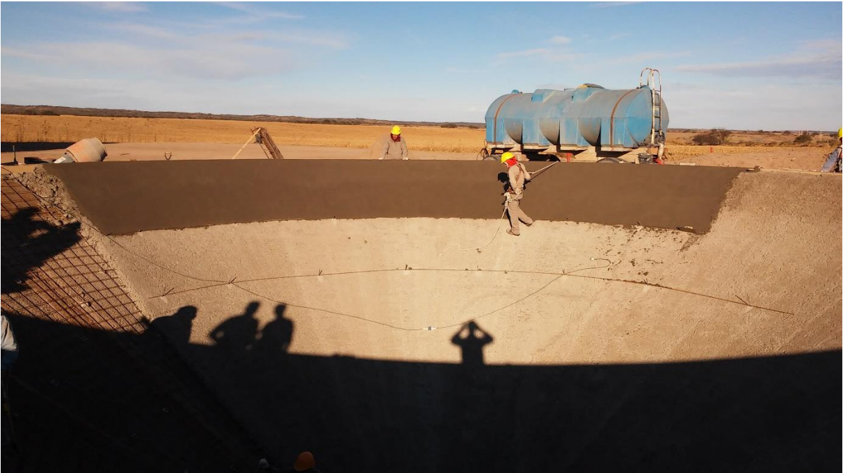
Fig. 3.44 Carpeta de terminación fondo cono
