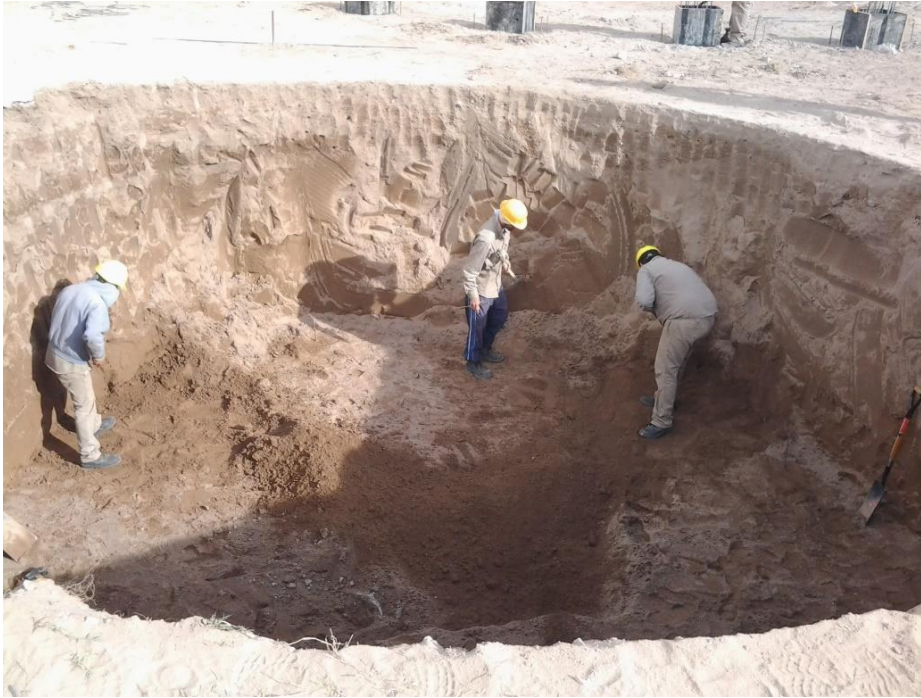
Fig. 3.33 Excavación foso de noria
