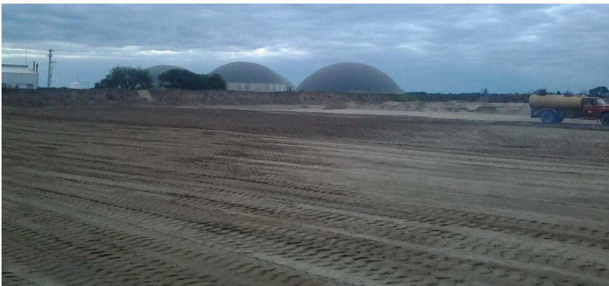
Fig. 3.29 Movimiento de suelos
