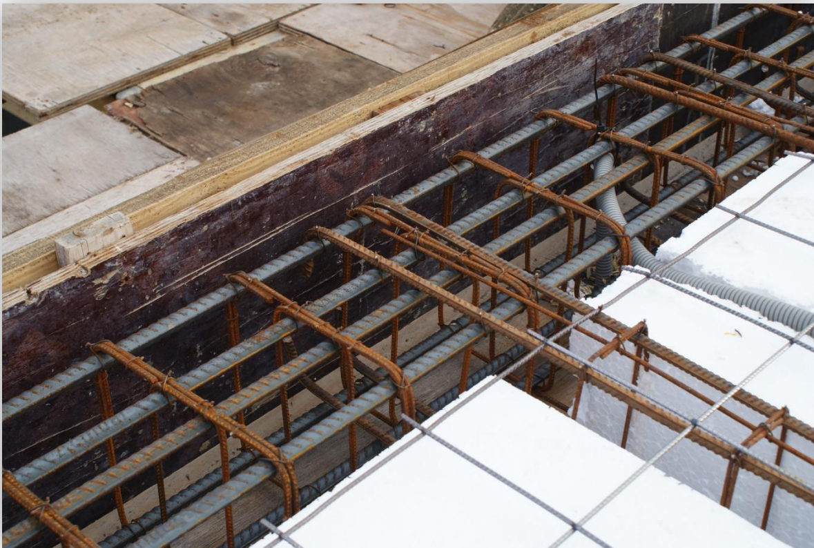
figura 3.10: Anclaje de losa nervurada en viga
