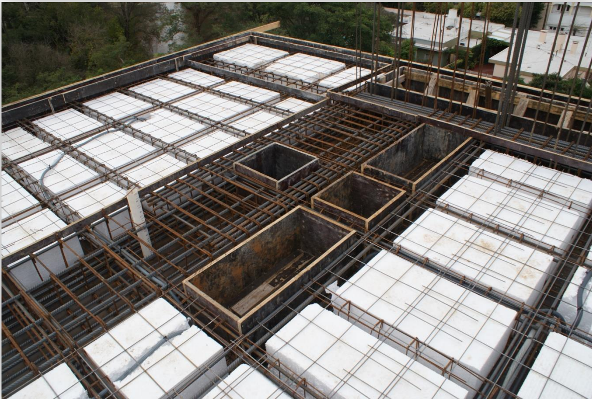
figura 3.14: Espacios para conductos y ductos
