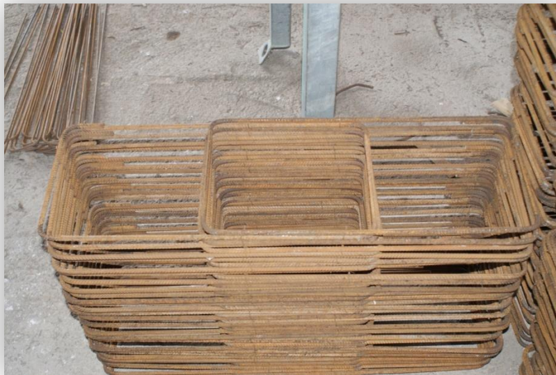
figura 3.22: Estribos de cuatro ramas
