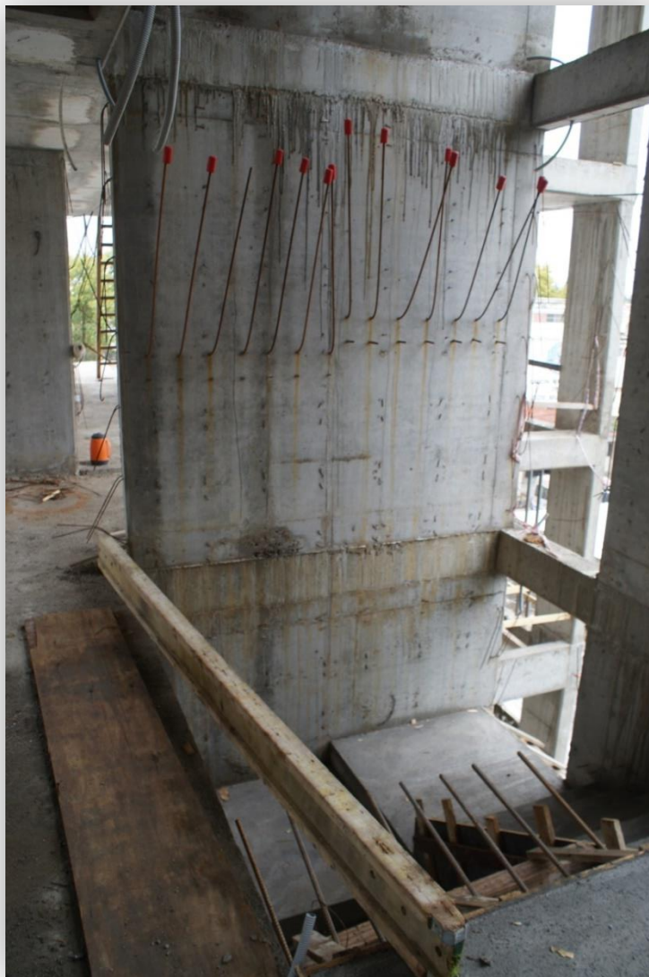
figura 3.28: Armadura de espera en tabiques
