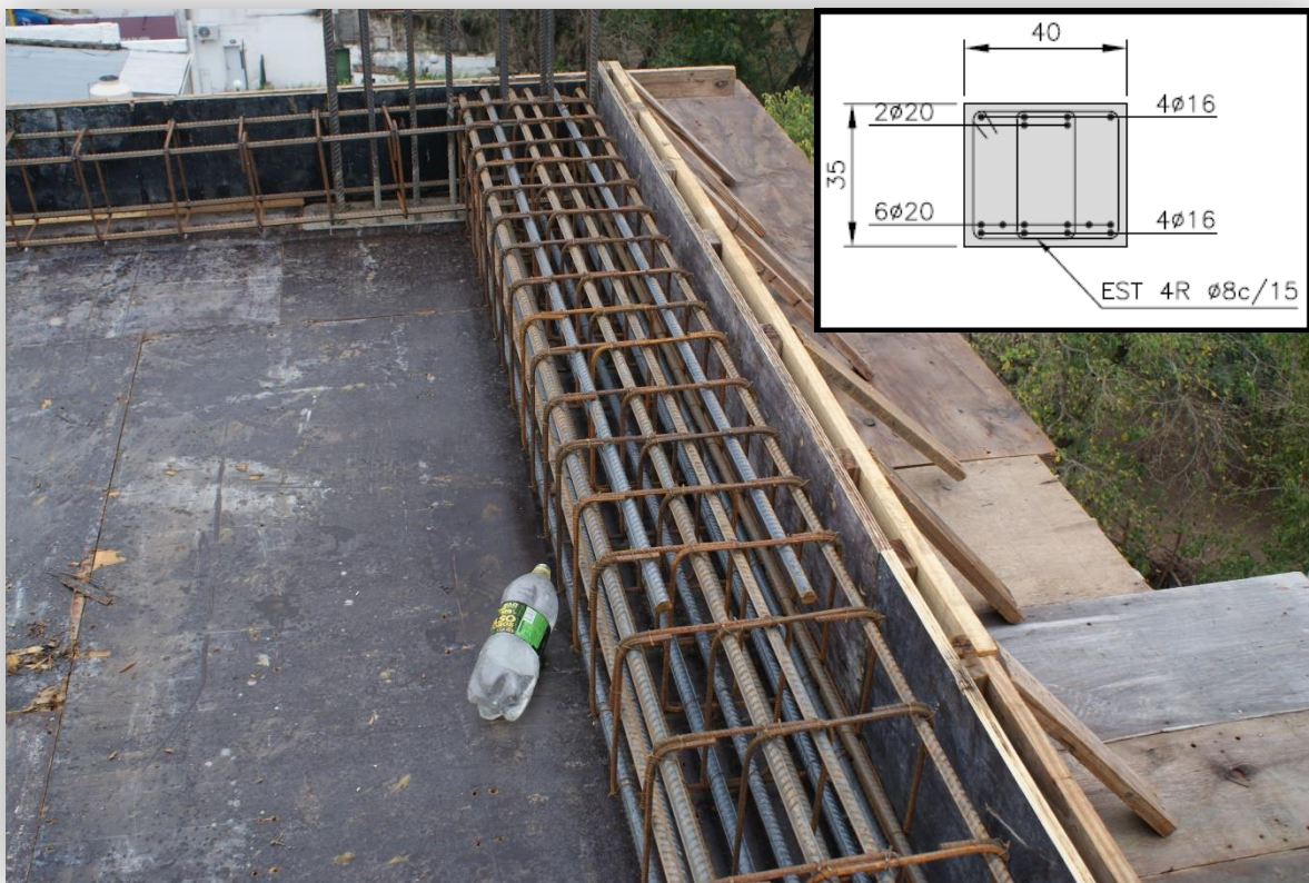
figura 3.4: Refuerzos en extremo de viga
