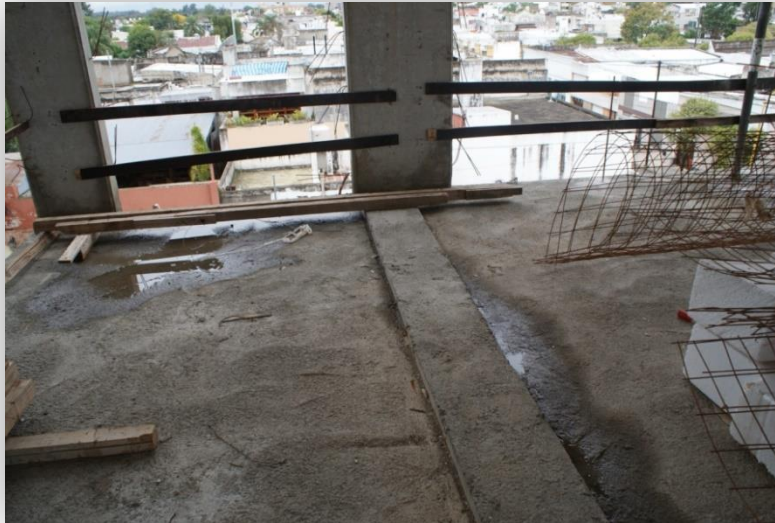
figura 3.34: Viga invertida hormigonada
