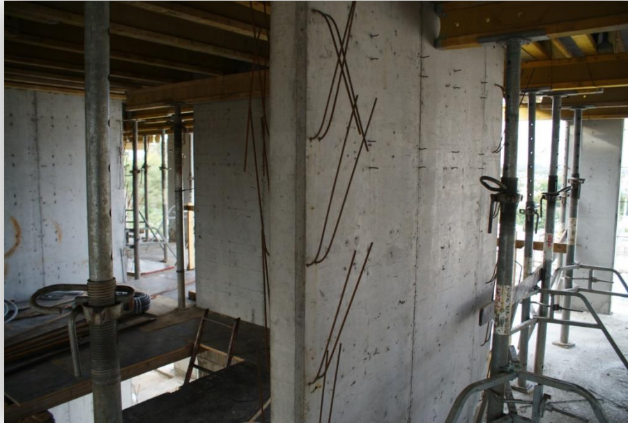
figura 3.32: Pelos para mampostería en tabique
