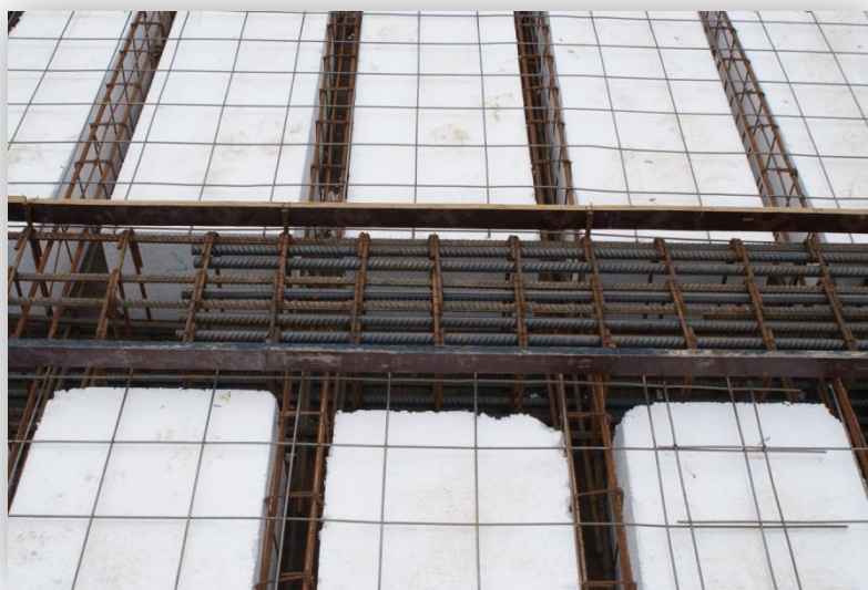
figura 3.12: Encofrado de viga invertida
