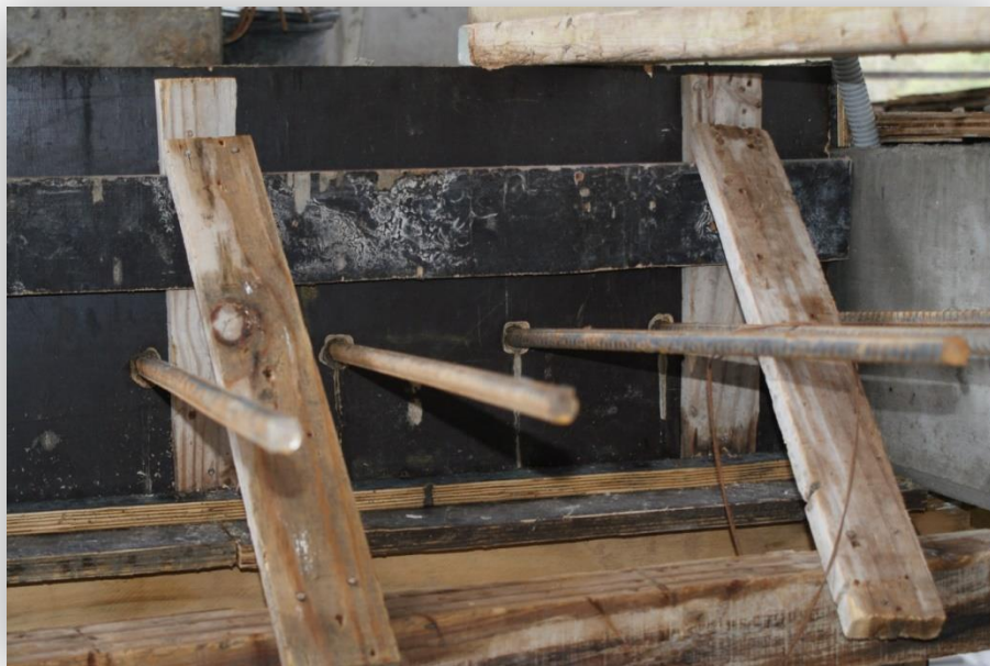
figura 3.33: Pelos para losa en pendiente de escalera
