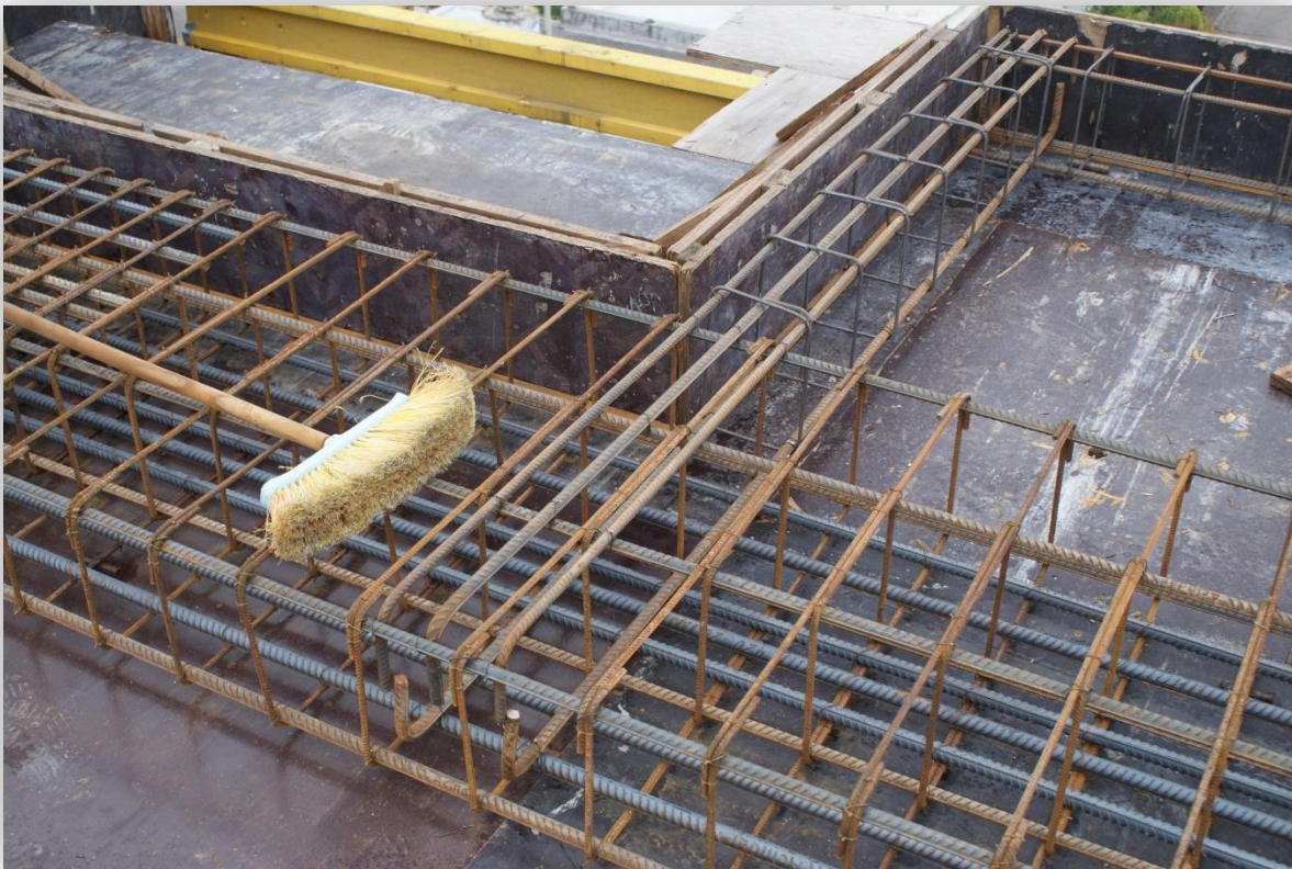
figura 3.3: Viga en voladizo
