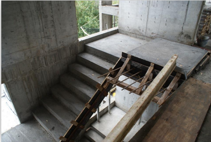
figura 3.29: Armadura de espera en descanso
