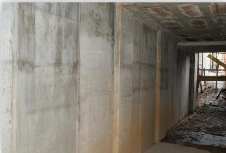
figura 3.38: Hormigonado tabiques de submuración
