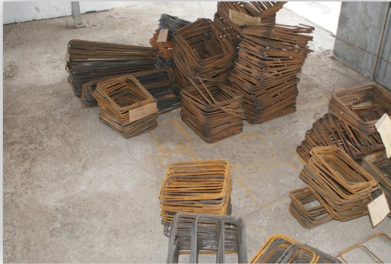
figura 3.21: Paquete de estribos
