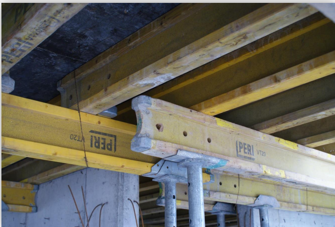
figura 3.31: Encofrados PERI
