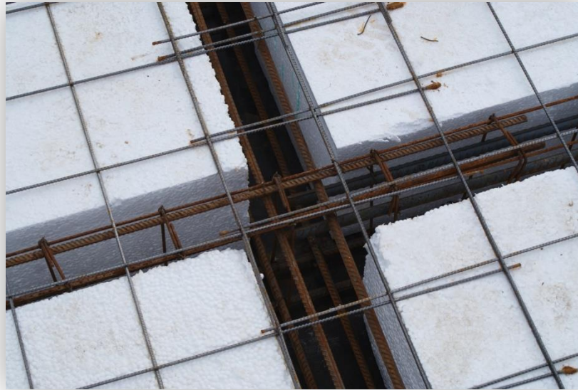
figura 3.8: Nervio de refuerzo de losa
