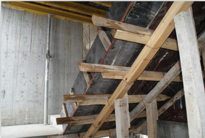
figura 3.30: Encofrado de escalera
