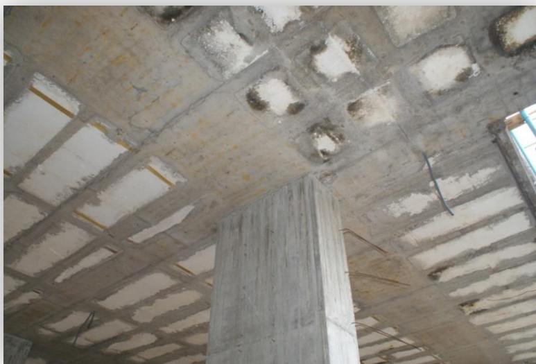
figura 3.35: Hormigonado de viga columna
