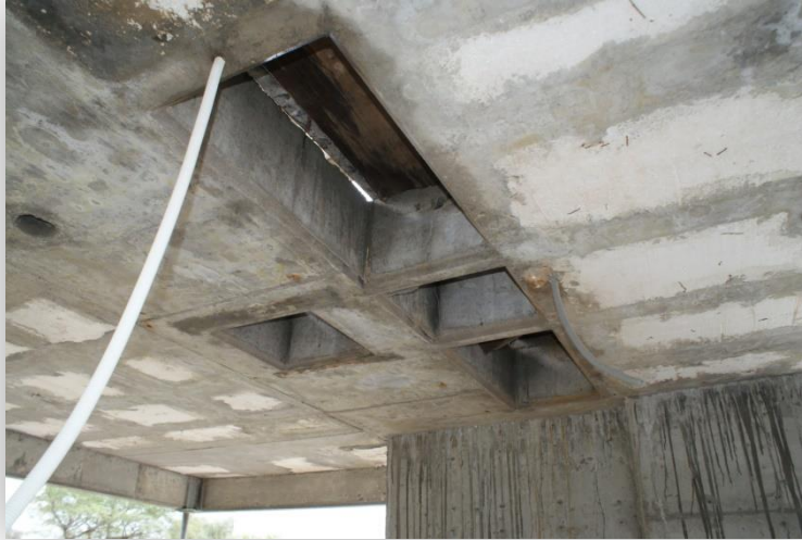
figura 3.36: Hormigonado conductos y ductos
